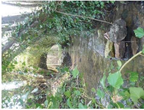
D : Caisse recouverte de pierres.
