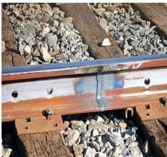
FIGURE 5.3 – Soudure aluminothermique
