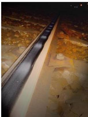
FIGURE 5.1 – Usure ondulatoire du rail
