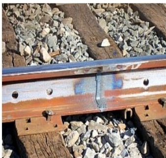
FIGURE 5.3 – Soudure aluminothermique
