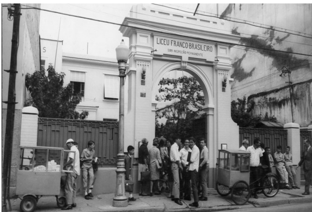
figure 8 : la façade du Lycée -années 1950-1960 (CDM)
