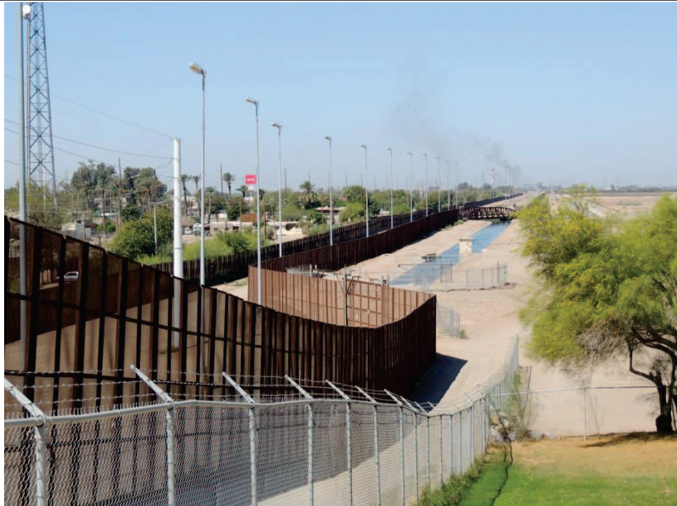
La triple-barrière à San Luis dans le comté de Yuma. Parallèlement aux « barrières » en taules sur la ligne frontière (à gauche de l'image) sont déployés des grillages en acier, des réverbères et une route de patrouille. Crédits : Damien Simonneau – Mars 2013.
