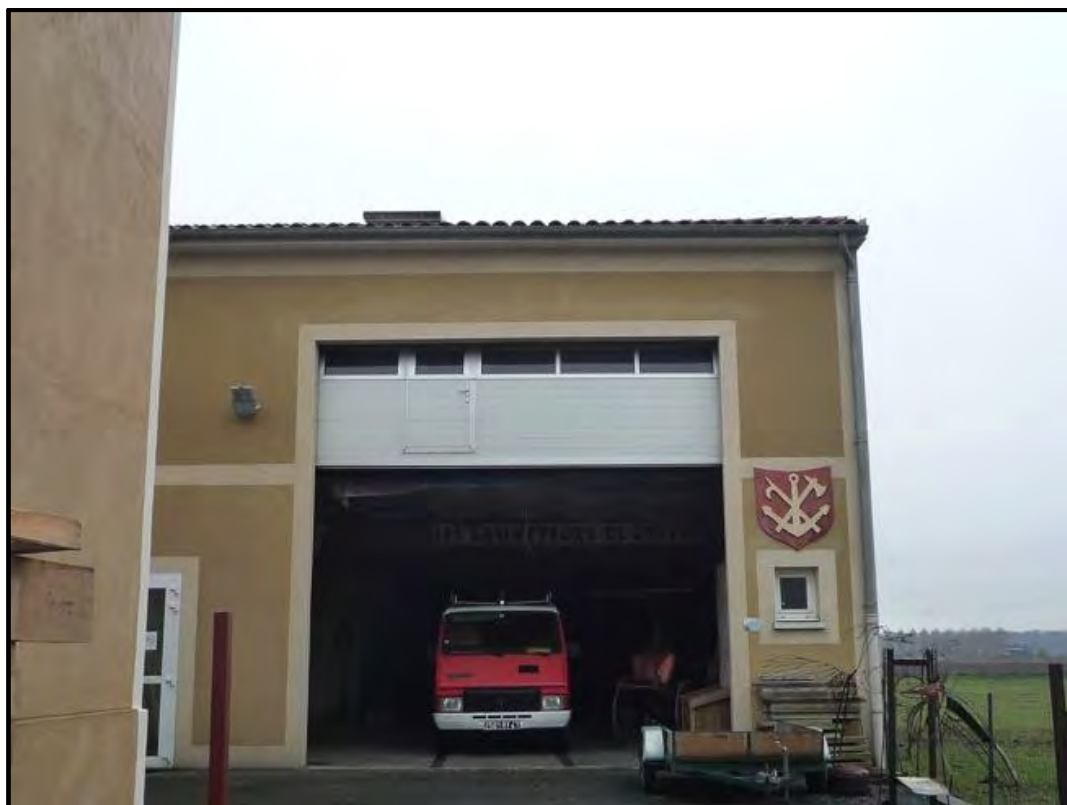
Photo 5-2 Local des sauveteurs de Couthures-sur-Garonne qui fait également office de PC sécurité en cas d'inondation majeure (Source : Guilhem Juteau).
