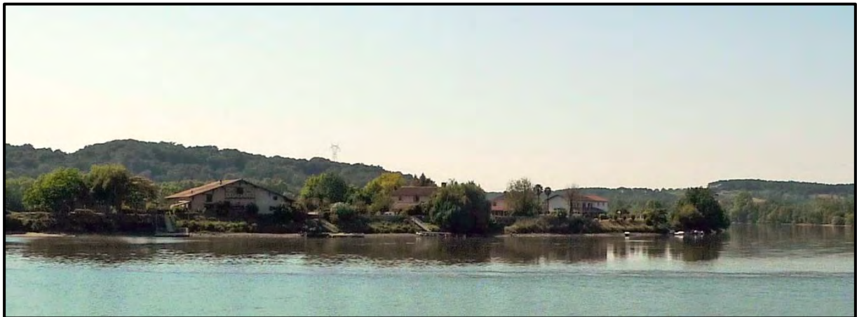
Photo 6-3 Exemple de maisons landaises en bord d'Adour à la confluence avec les Gaves Réunis (Cliché : France DAUPRAS - 2012).
