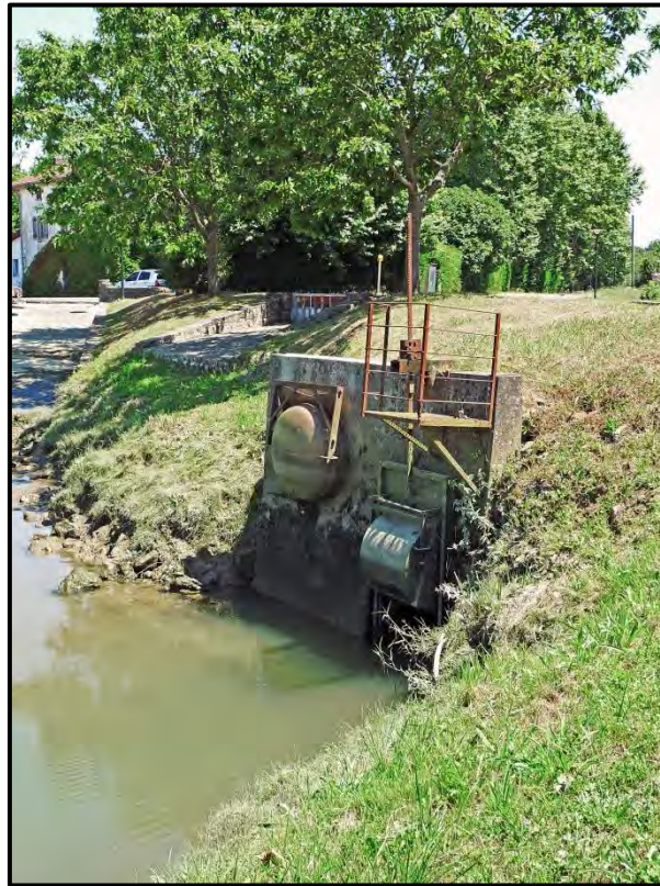
Photo 6-2 Porte à clapet – commune de Saint Laurent de Gosse (cliché : France DAUPRAS - 2012).
