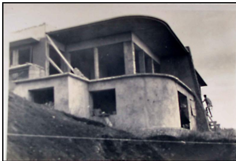
Figure 39. Chantier Peyron, La Montagne (Saint-Denis), 1952.
