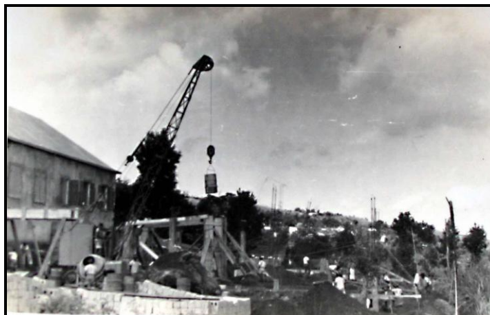
Figure 41. Ecole en chantier, 1952.
