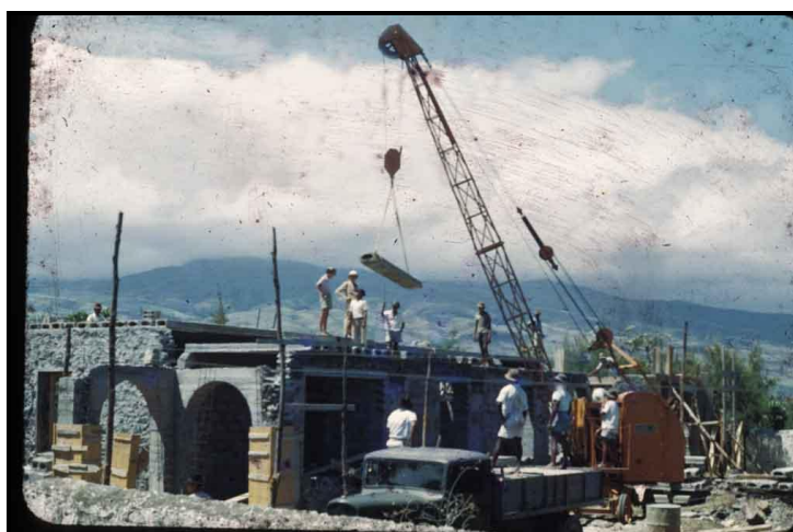
Figure 37. Chantier de l'hôpital de Saint-Louis.
