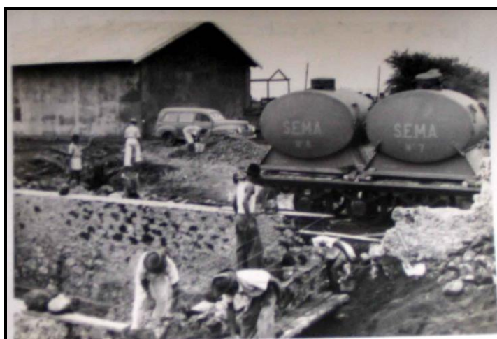
Figure 56. Ouvriers sur un chantier, années 1950.
