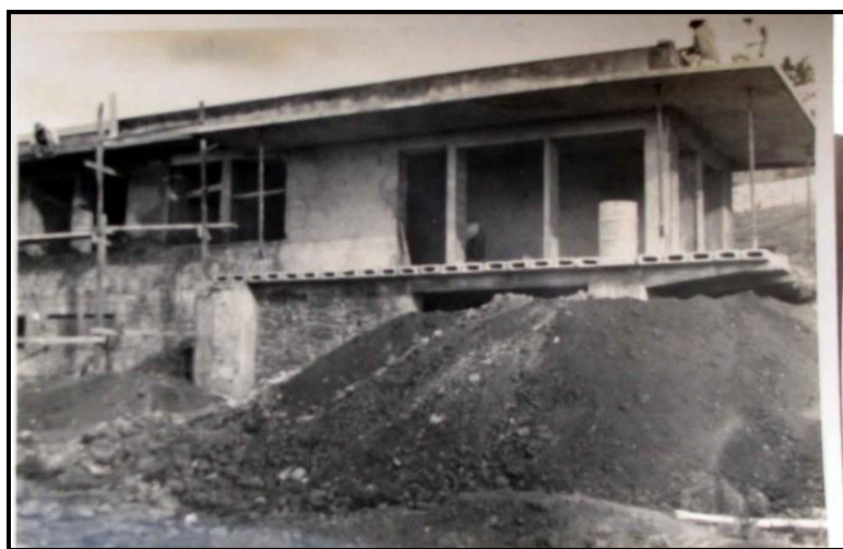
Figure 45. Chantier des Sucreries de bourbon.
