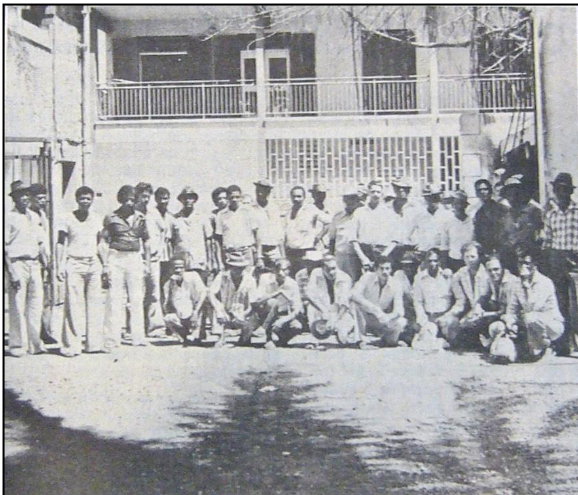
Figure 61. Les ouvriers du bâtiment des Etablissements Isautier (mars 1979) 1107
