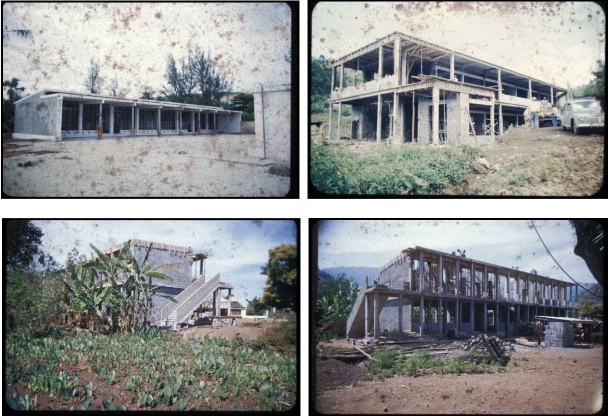
Figure 38. Chantiers divers, écoles dans le sud de l'île.
