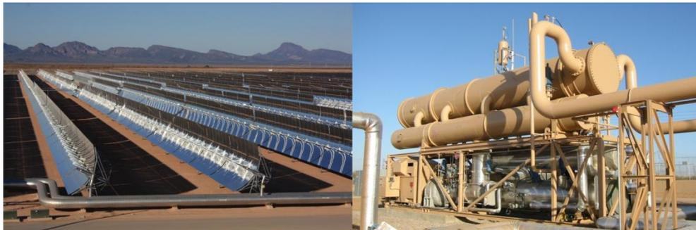
**Figure 5 : Centrale ASP Saguero d'1-MWe utilisant des capteurs cylindro-paraboliques et une machine ORC (source : Arizona Public Service Co.)**
