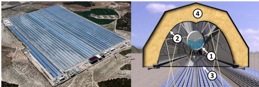
Figure 6 : Centrale Puerto Errado 1 d'1,4 MWe utilisant des capteurs linéaires de Fresnel Nova-1 (source : Novatec Solar)
