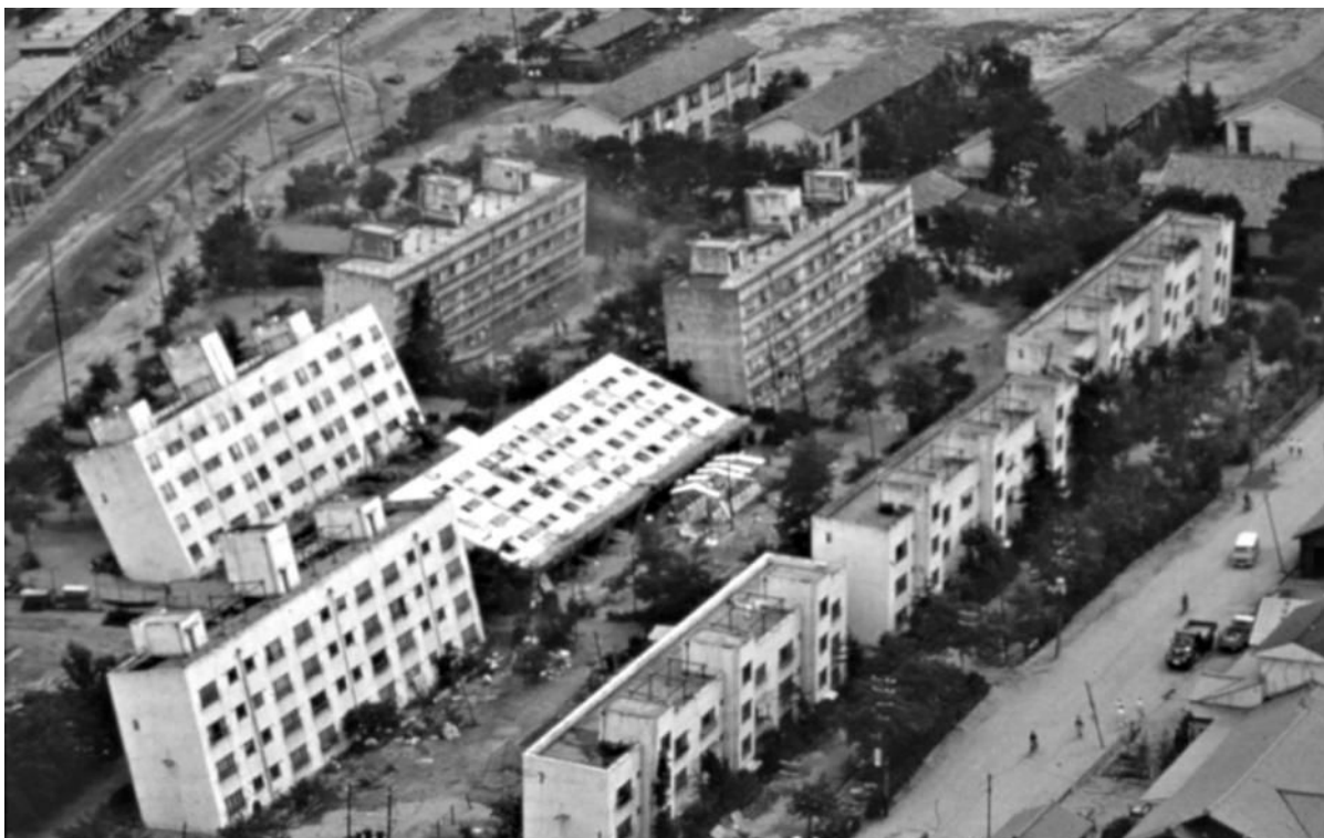
Figure 1. 9: Les ruptures par perte de capacité portante des fondations du complexe de bâtiments de Kawagichi-Cho, après le séisme de Niigata en Japon, 1964 (Copy right Pearson education, 2011).
