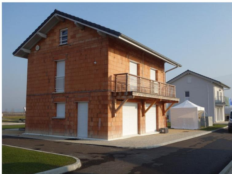
FIGURE 2.10 – INCAS-MA avant la pose d'enduit aérogel
