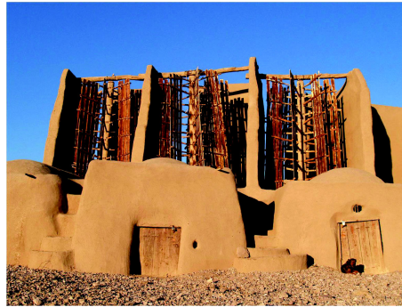
Figure V.2: Eolienne verticale à Nishtafun en Iran (600 AD).
