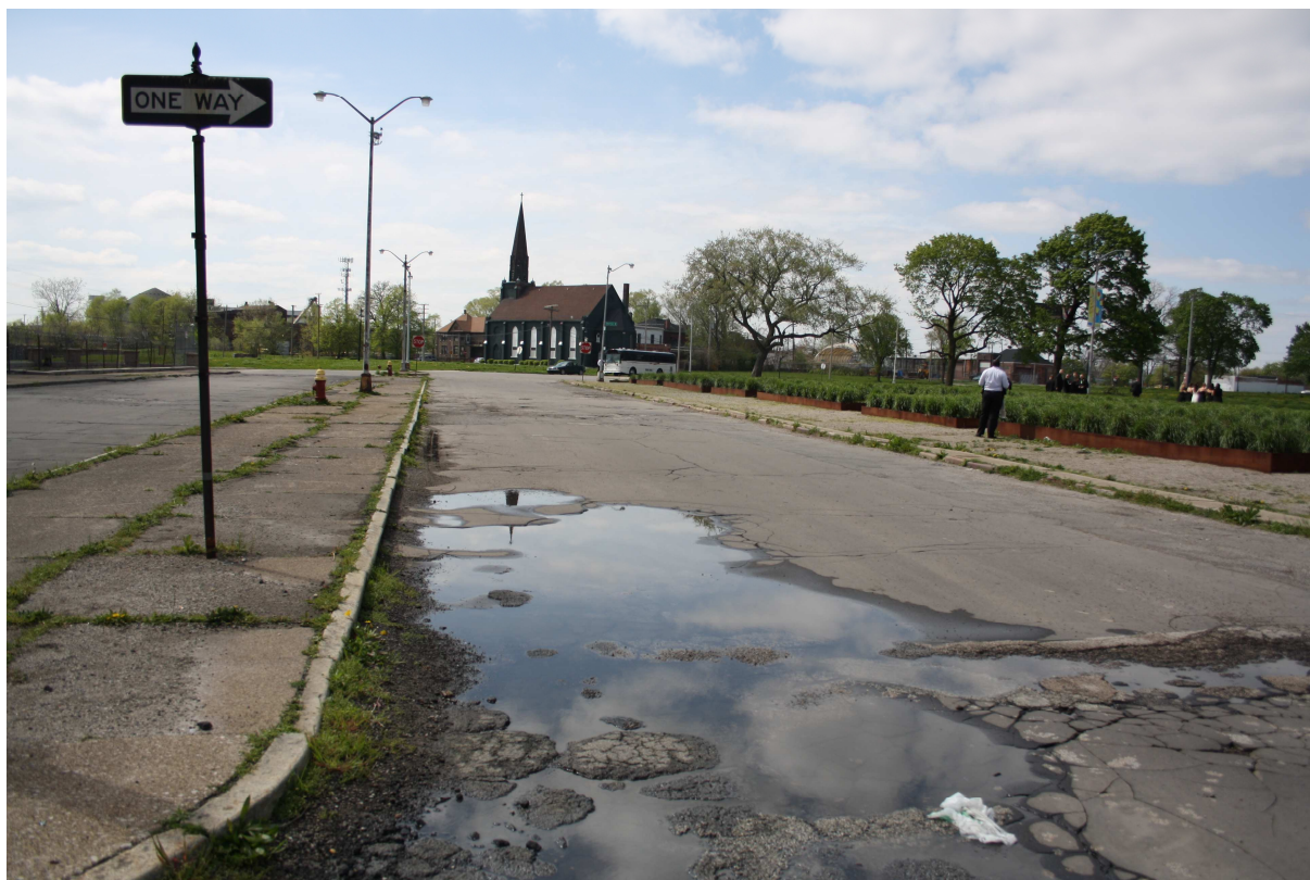
Devant la Michigan Central Station, trottoirs envahis par les mauvaises herbes et routes mal entretenues.
