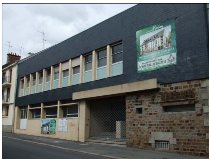
Photographie 5.2 - Les anciens établissements « Barbier » en voie de réhabilitation (Fougères).
