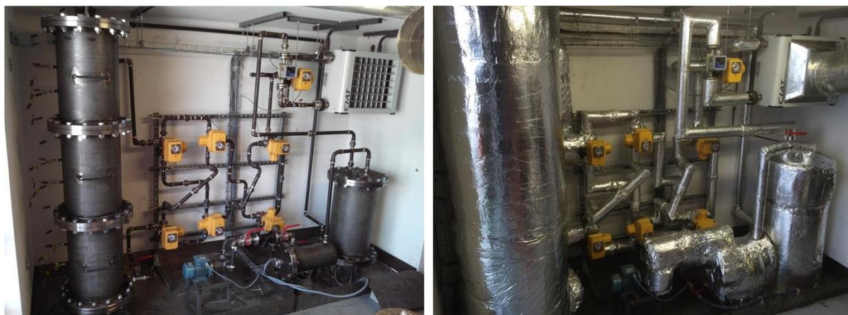
Figure 105 : Photographies du démonstrateur avant et après la mise en place de l'isolation.
