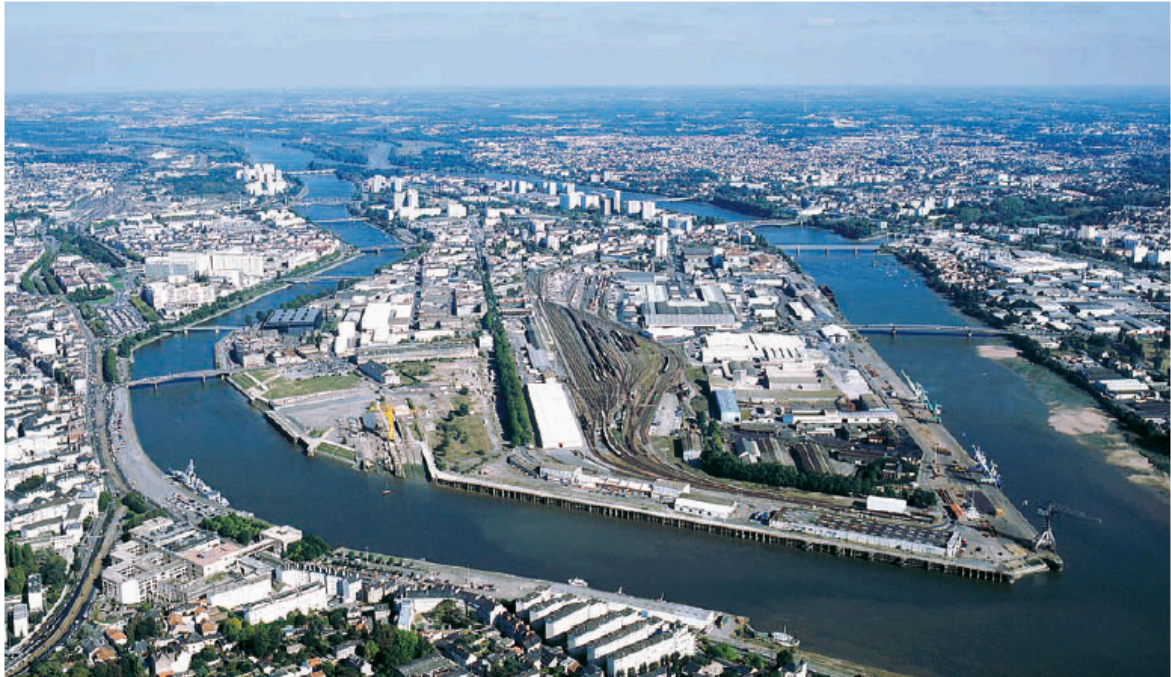
Figure 14 : Le périmètre inchangé du site de Nantes État au milieu des années 2000
