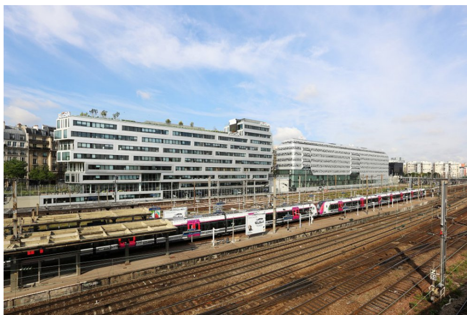
Figure 37 : Du service ferroviaire à la promotion immobilière : les immeubles « strato » et « rezo » réalisés par la SNEF et Bouygues Immobiliers
