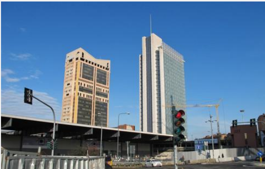
Figure 24 : Les tours Garibaldi en cours de réhabilitation avec au premier plan la gare
