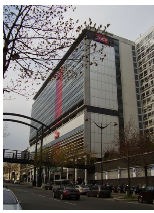
Entretien 68 : Siège de la SNCF, rue du Commandant Mouchotte
