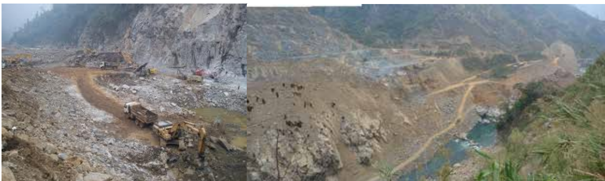
Figure 1. 7: Chantier de construction du barrage hydroélectrique de Huoi Quang Source: Nguyen Van Thiet (mission 2010)
