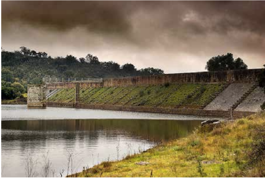
Figure 1. 1. Barrage de Cornalvo (Mérida, Espagne) construit par les Romains en l'an 130, avec une capacité de réservoir de 3 millions m 3 , toujours en activité. Source: Wikipédia.
