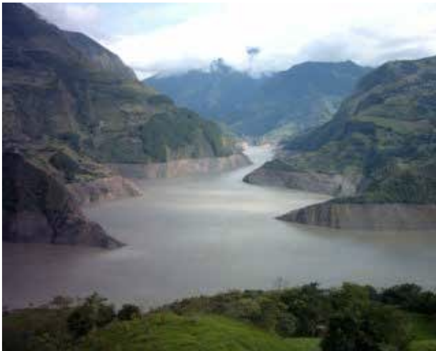
Réservoir du barrage de Huoi Quang
