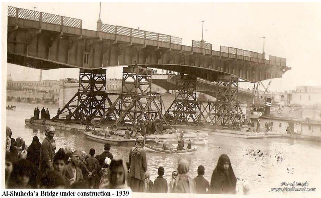
Fig. 19 : Les Bagdadiens regardent les travaux de la construction du pont du Roi Fayçal, en 1939 (Al-Ahrar actuellement). Source : images Google
