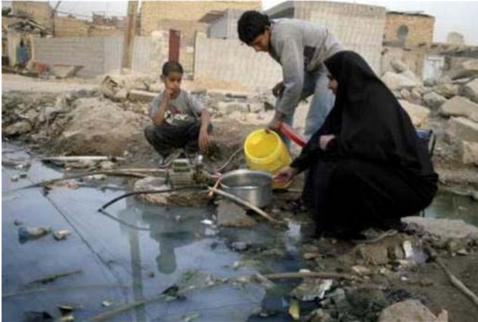
Fig. 50: La condition des réseaux d'approvisionnement en eau dans certains quartiers périphériques de Bagdad Source. journaux locaux irakiens
