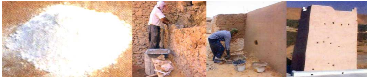
Figure I-6 : L'utilisation du plâtre et du mortier de chaux dans la construction à Ghardaia
