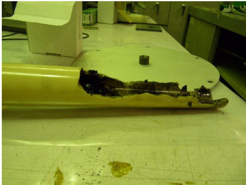
FIGURE 5.4: Connecteur cassé de la haute tension
