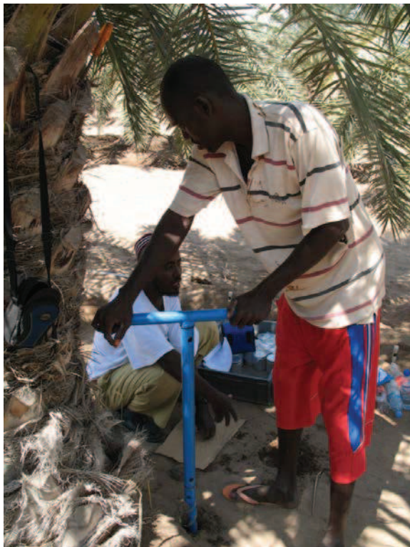
Photo 3.9 : Installation des tubes d'accès de la sonde à neutrons
