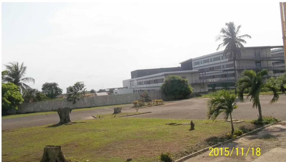
Figure 17 : vue de la façade arrière du centre hospitalier universitaire d'Owendo. Image prise à partir de la façade avant de la F.M.S.S.
