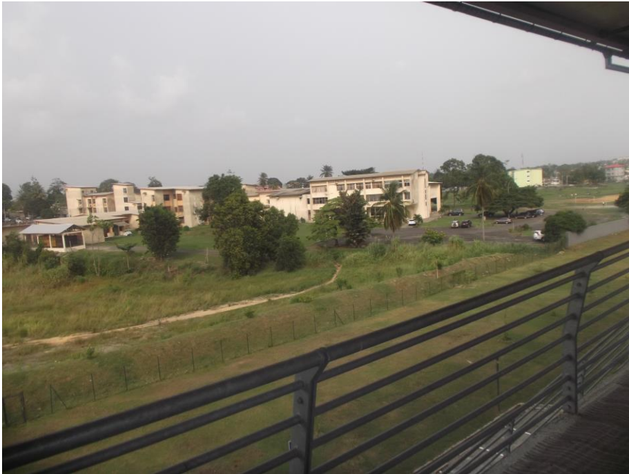
Figure 16 : vue aérienne de la F.M.S.S., façade avant Prise d'image à partir du CHU d'Owendo.
