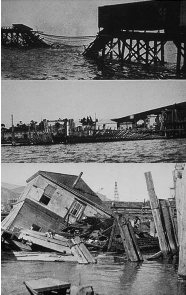
Figure 8 : Photographies anciennes dans la baie de San Francisco, de constructions détruites par Terredo Navalis . D'après Hill et al. , 1927
