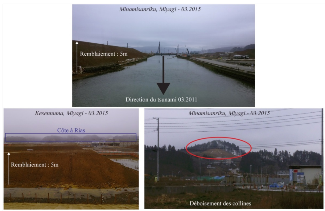
Figure 66 : Remblaiement et déboisement pour la reconstruction dans la province de Miyagi (Japon) suite au tsunami de 2011
