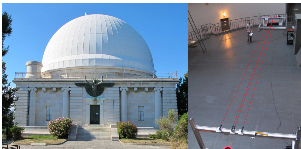
FIGURE 3.61 – Photographies de la coupole Bishoffsheim et de l'installation de l'instrument INTENSE à l'intérieur du bâtiment.
