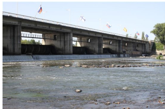
Le pont-barrage de l'Europe
