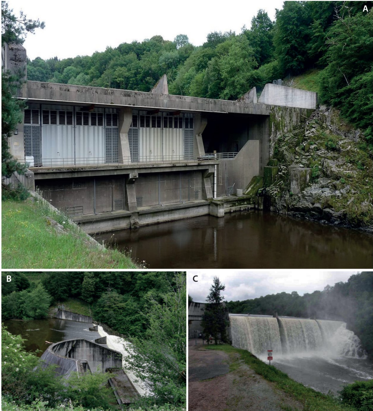
Figure 4.1.2e. (A) Vue aval du barrage-contreforts de Champsanglard et son usine hydroélectrique (B) Vue en travers illustrant l'eau s'écoulant par un déversoir. (C) Vue aval en plan large montrant le barrage submergé par les eaux (source : comité français des barrages et des réservoirs : CFBD).
