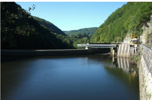
Le barrage de Vaussaire
