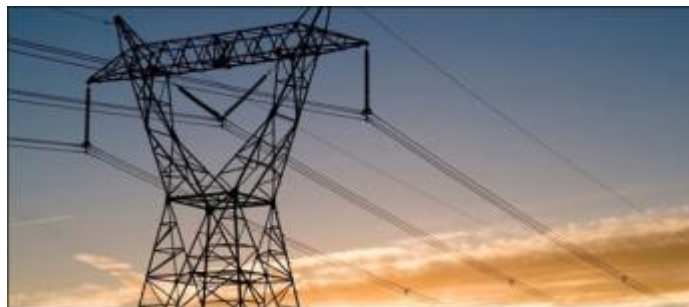
Figure I-4 Photographie d'une ligne haute tension
