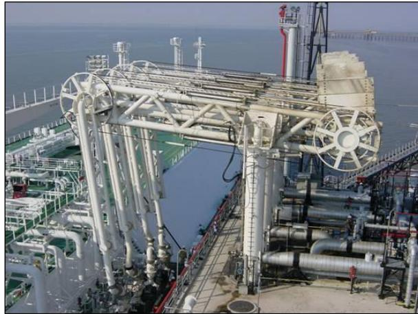
**Figure I.6.** Bras de terminal méthanier permettant le chargement/déchargement du GNL<sup>8</sup>.
