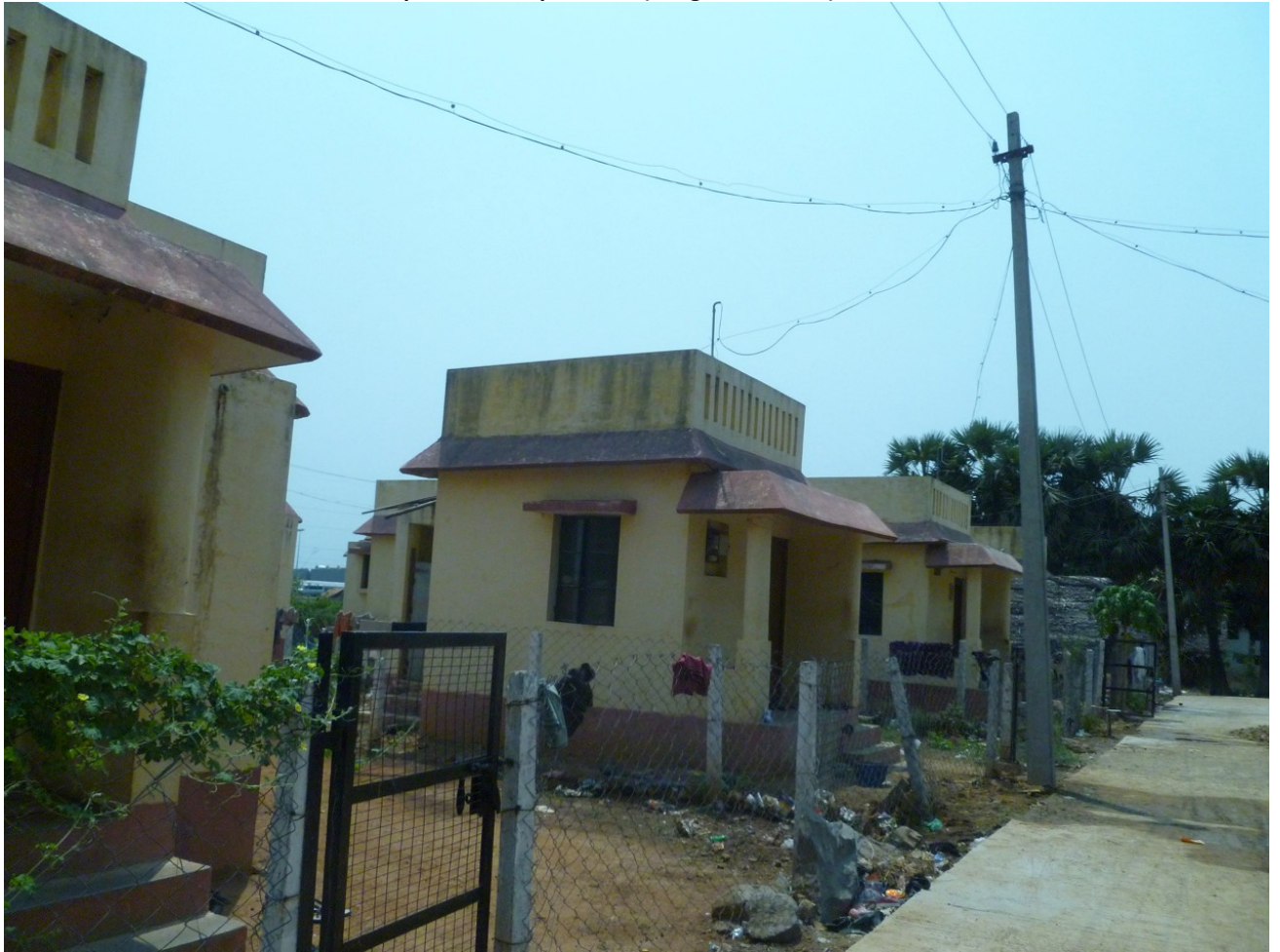
Illustration 27 : maisons reconstruites par les entrepreneurs (Oragadam, 2013).
