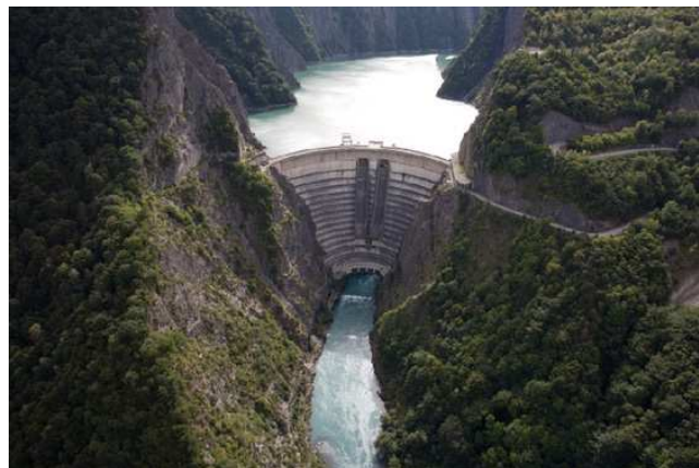
FIG. 1.16 – Barrage et retenue de Monteynard (Isère)
