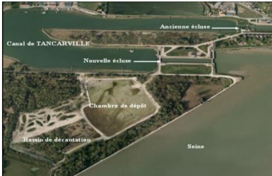
Figure I-6 : Vue d'ensemble de la chambre de dépôt de Tancarville, des écluses et de la zone de décantation.
