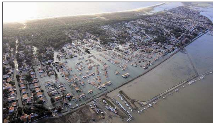
Photo II.9 La Faute-sur-Mer inondée suite à la tempête Xynthia (Source : Crédit photo PQR/Ouest France)
