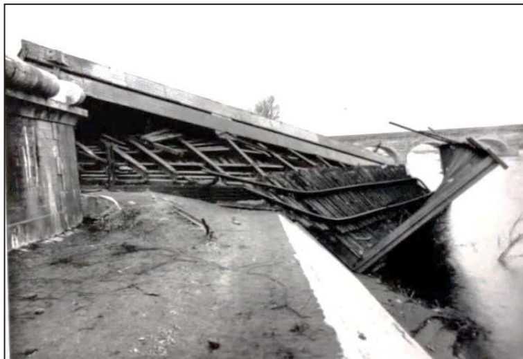
Photo III.2 Les débris du pont Cacor emportés par la crue non-loin du Pont Canal (Source : AD Tarn-Et-Garonne, Série Fi, 3Fi53)
