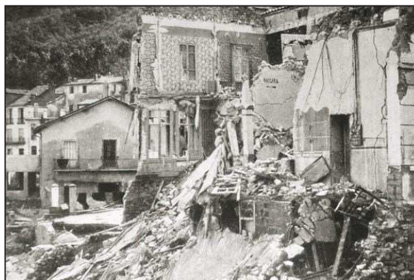
Photo II.3 Le casino d'Amélie-les-Bains, détruit par les crues du Tech d'octobre 1940 (Source : L'Illustration, n° 5097, p. 260)
