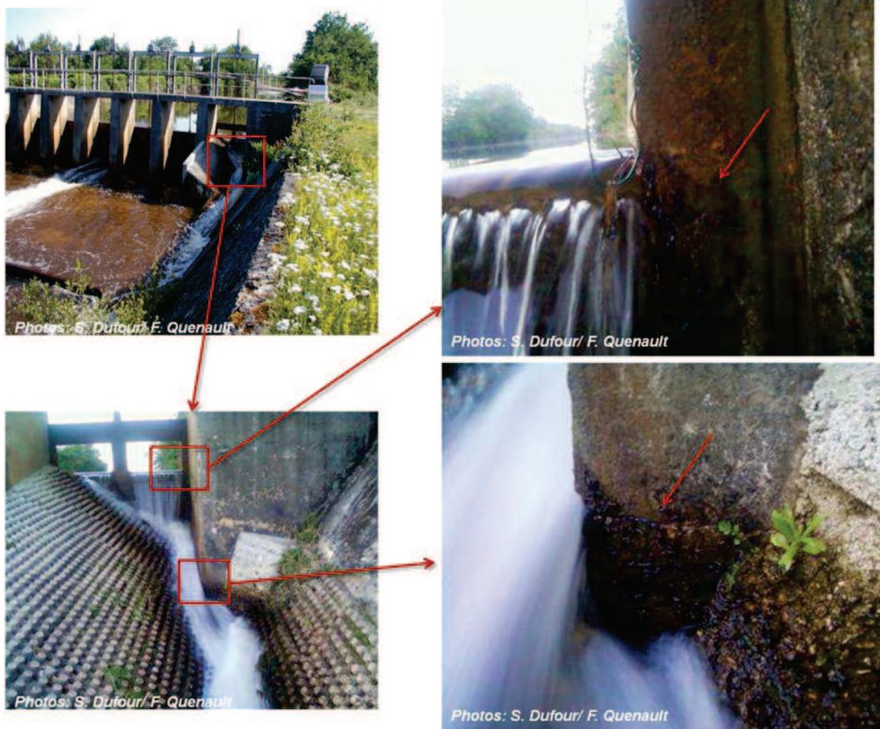
**Figure 12)** L'exemple d'un dispositif de franchissement inadapté au site de Langouarde, l'un des sites d'échantillonnage (segment 2). On observe un amas de civelles escaladant les parois verticales afin d'accéder aux zones amont. Ces individus sont hors de l'eau et ne peuvent donc pas s'orienter par le sens du courant. Par ailleurs, les anguilles mises hors de l'eau ne seraient pas capables de retrouver une source d'eau (Rudsinke 1960). Photos : Sébastien Dufour & Franck Quenault (SIAEBVELG).
