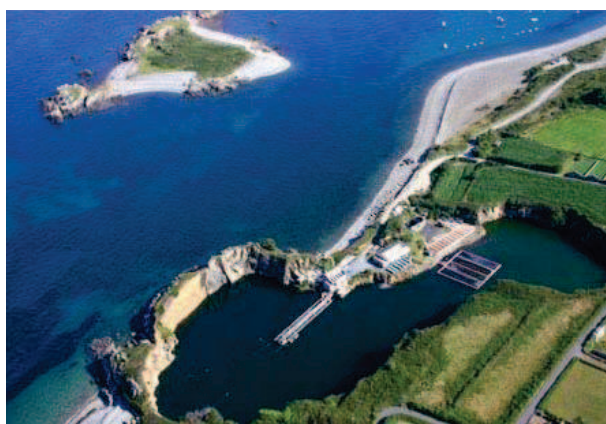
Figure 25 : Vue aérienne de l'écloserie de Guernesey
