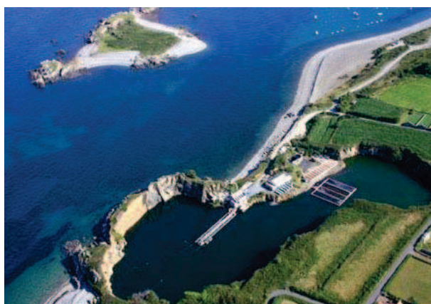
Figure 25 : Vue aérienne de l'écloserie de Guernesey
