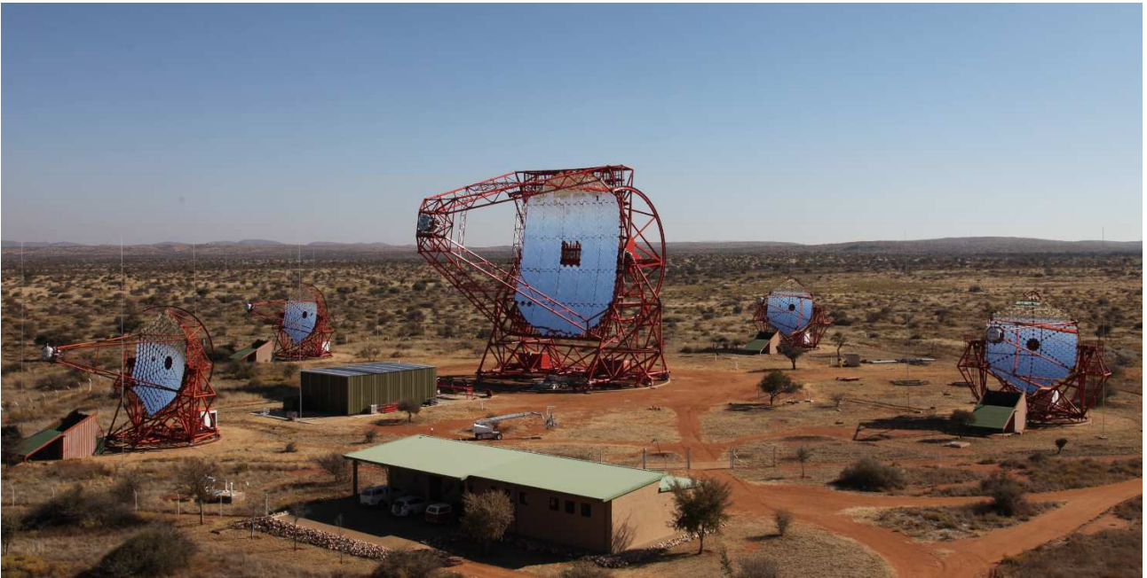
FIGURE 3.1 – Photo de la phase II du réseau de télescope H.E.S.S.
