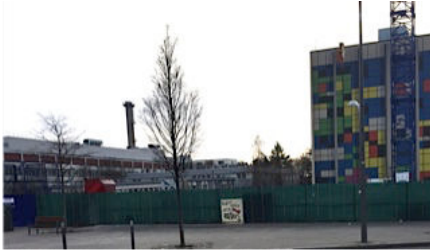
Figure 18 : L'emplacement du rond-point pendant les travaux
