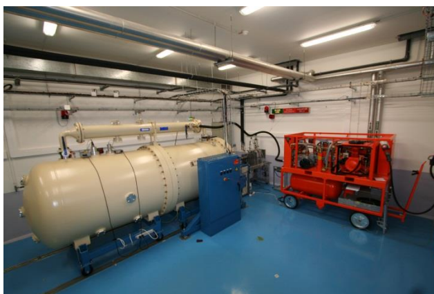
Figure 2.4 : Photo de l'accélérateur SIRIUS du LSI (polytechnique)
