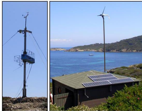
Figure 3-4 : Station de Porquerolles : (a) Mat équipé de capteurs et (b) Eolienne et panneaux photovoltaïques
