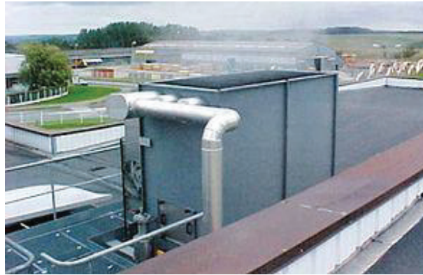
Figure 12. Les TAR sont des sources reconnues de légionellose et peuvent être à l'origine d'épidémies (67,140–144).
