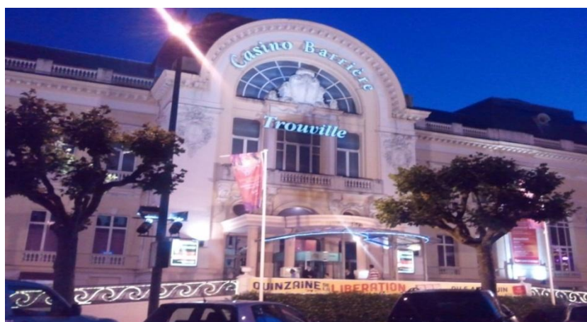
Illustration 21 : Façade du casino de Trouville en nocturne
