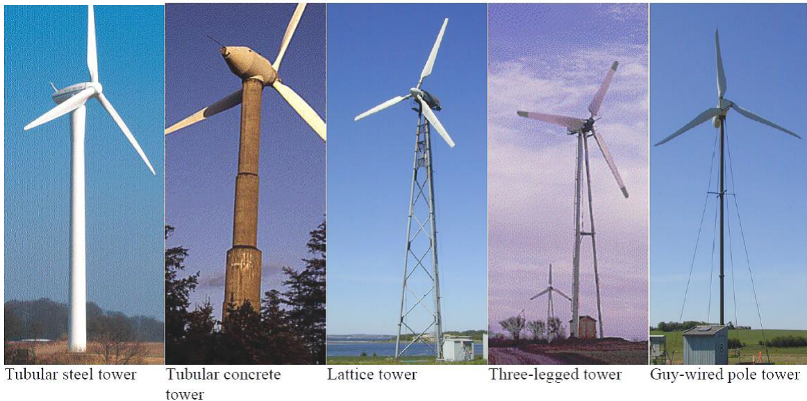
FIGURE 1.16 – Les différentes structures de la tour [59]
