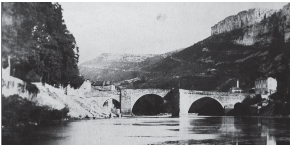
Fig. 207 : photographie ancienne du pont sur l'Aveyron, vu depuis l'ouest A gauche, les déblais des remparts sur le bord de la rivière (AC Saint-Antonin, O216).
