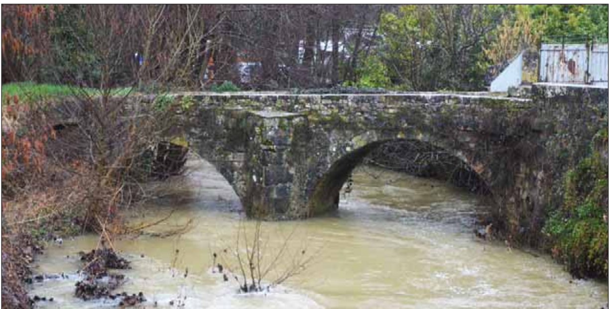
Fig. 151 : pont des Estafets sur la Bonnette vu depuis le sud
