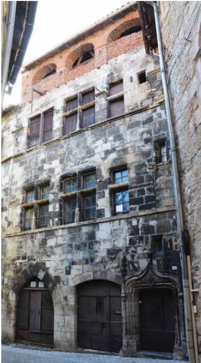
Croisées aménagées sur la façade du XIII e siècle de la maison ID51
