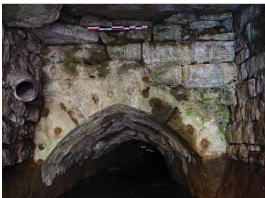
Fig. 199 : traces d'ancrage d'une grille métallique fermant l'accès à la ville au nord, au niveau de la dérivation supérieure, vues depuis le sud
