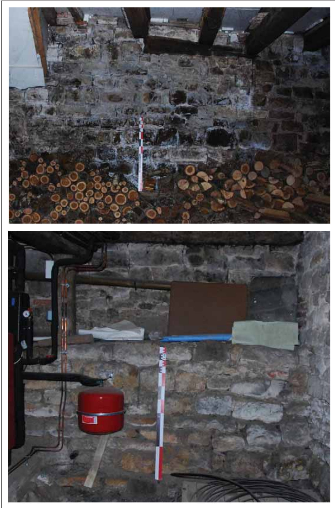
Fig. 187 : parement interne du rempart visible à l'intérieur du rez-de-chaussée de la maison ID237
