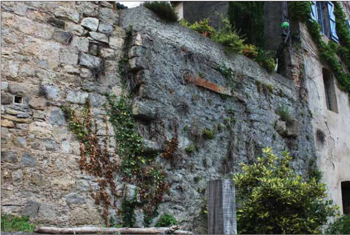
Fig. 146 : traces d'arrachement d'un mur sur l'Aveyron
