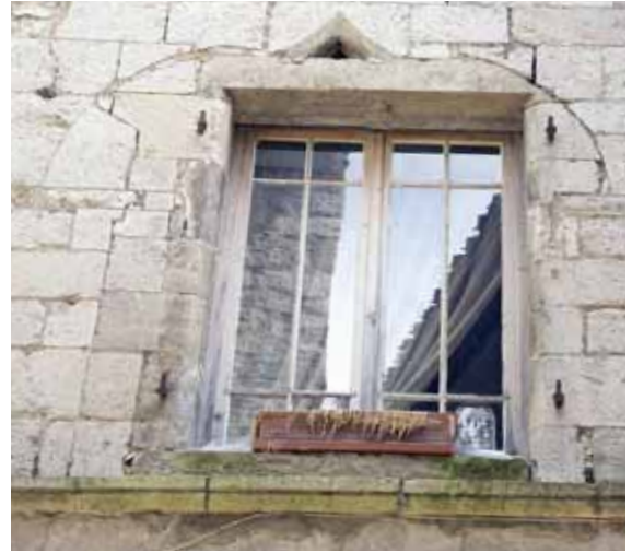
Baie géminée du premier étage de la maison ID49
