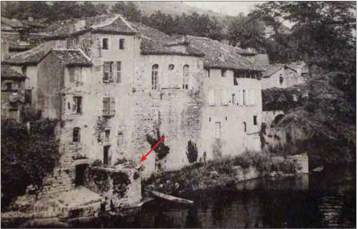
Fig. 148 : détail d'une carte postale ancienne des bords de l'Aveyron en amont du pont La flèche indique le massif maçonné à l'est du débouché de la rue Frézal.
