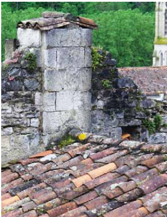
Souche quadrangulaire en pierre de la cheminée placée sur le mur pignon de la maison ID73
