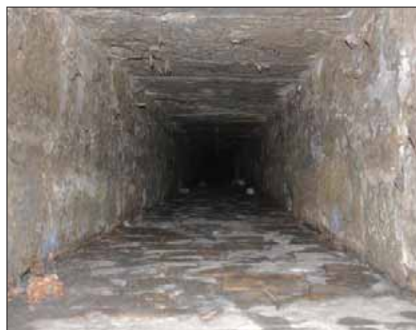
Fig. 198 : intérieur de l'aqueduc moderne qui draine l'eau du fossé
