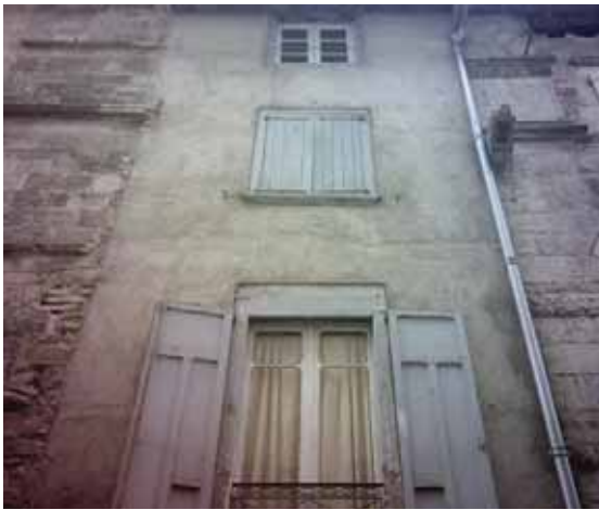
Maison ID231, rue de la Pélisserie Structure en pan-de-bois dissimulée sous le crépis au deuxième étage
