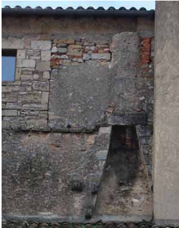
Hotte triangulaire et souche circulaire en tuf de la cheminée placée sur le mur de refend de la maison ID2
