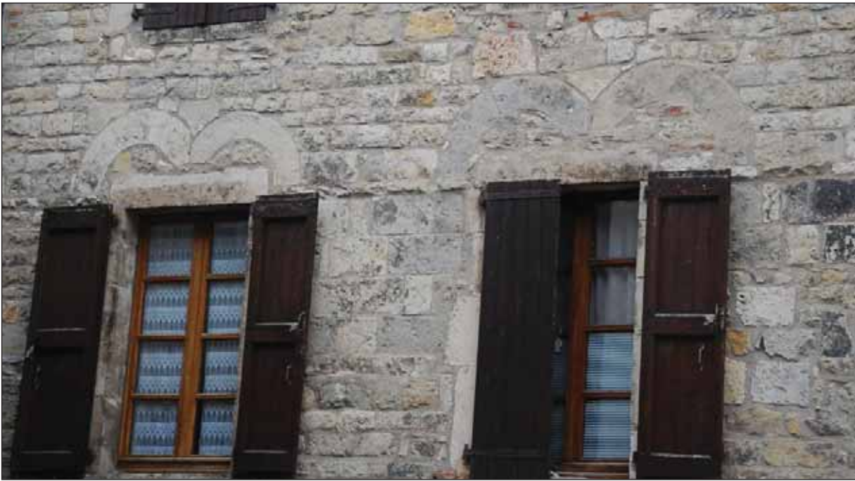
Fig. 224 : vestiges de baies géminées à arcs monolithes en plein cintre, caractéristiques des façades du XII e siècle, maison ID2
