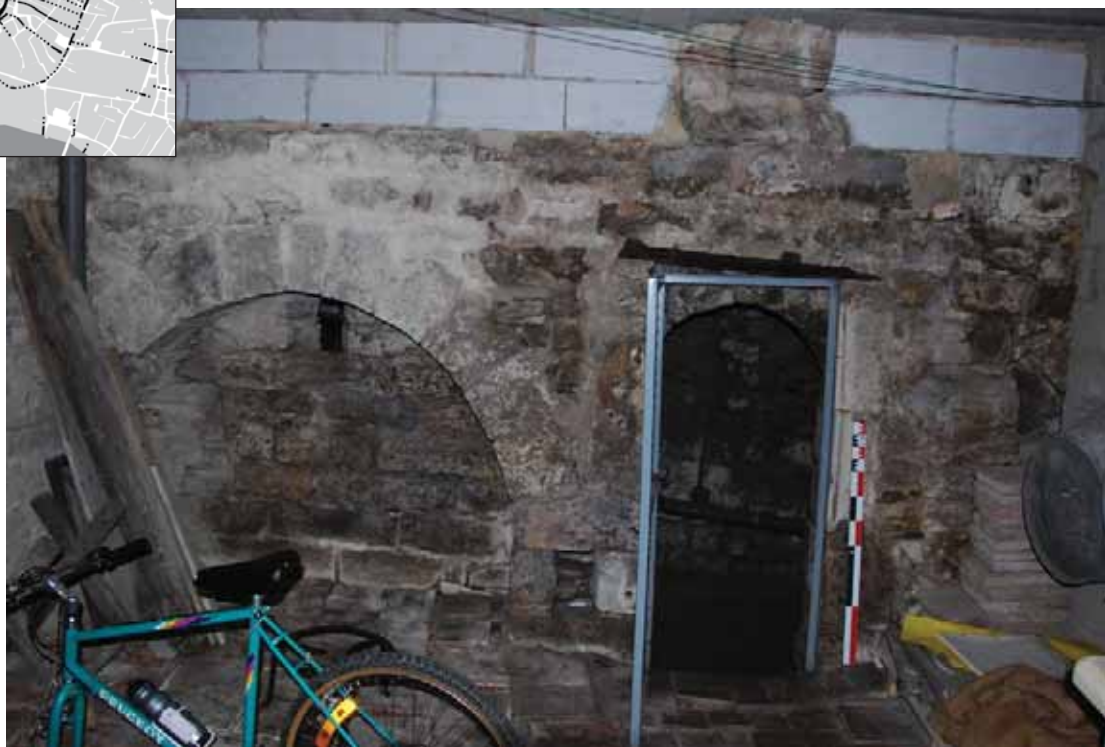
Accès au canal depuis le rez-de-chaussée
