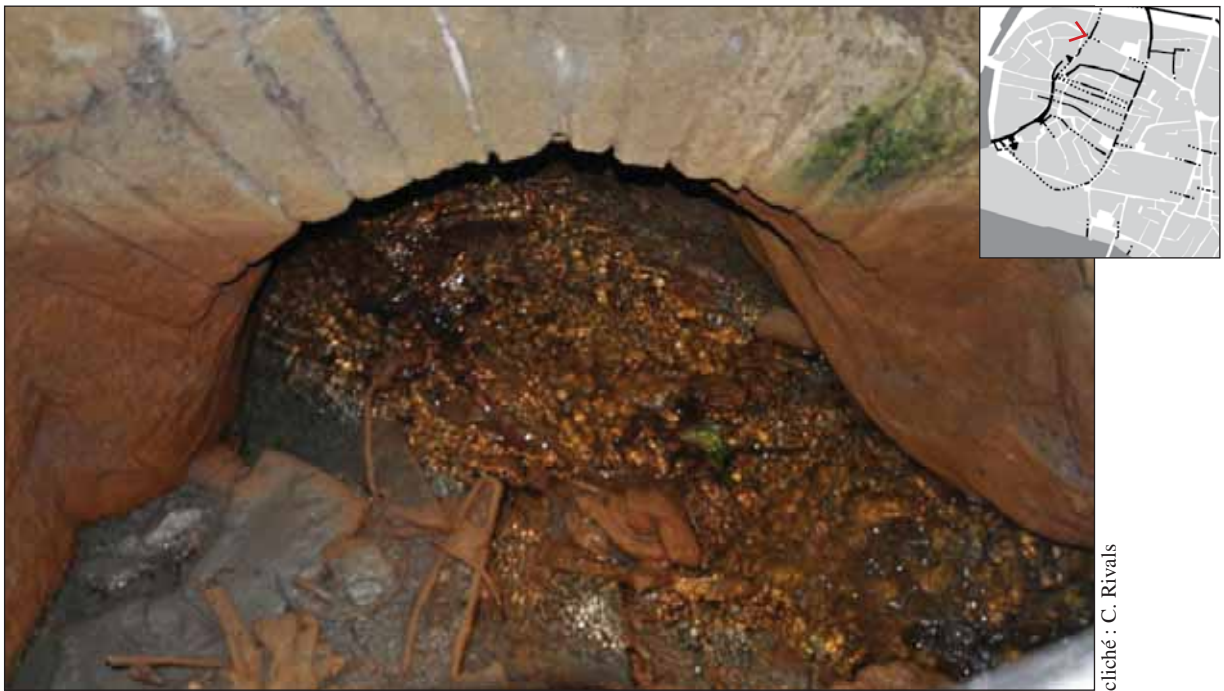
Fig. 431 : canal secondaire souterrain, orienté est-ouest débouchant dans le canal de dérivation inférieur, observé au niveau du regard rue Droite
