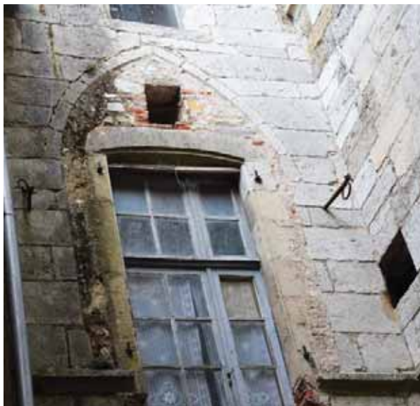
Baie du premier étage de la façade ouest de la maison ID72
