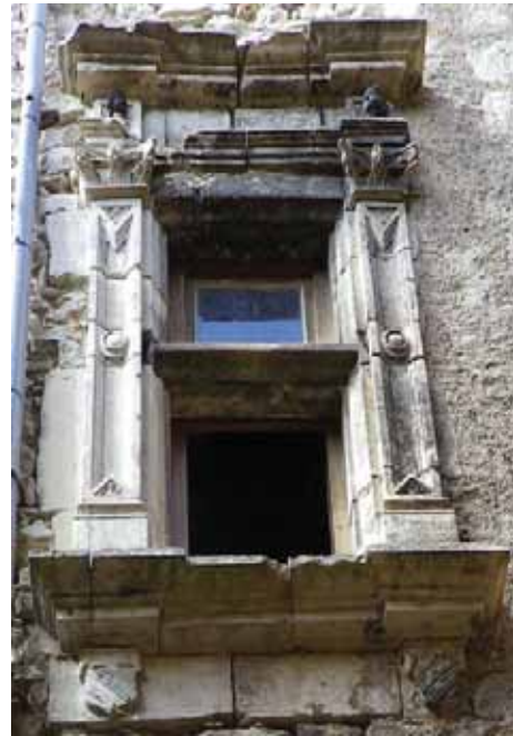
Demi croisée au premier étage de la maison ID79
