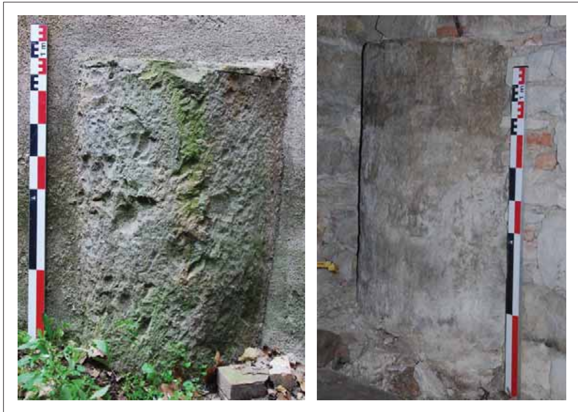
Fig. 114 : tambours de fûts de colonnes en remploi dans maison ID237
