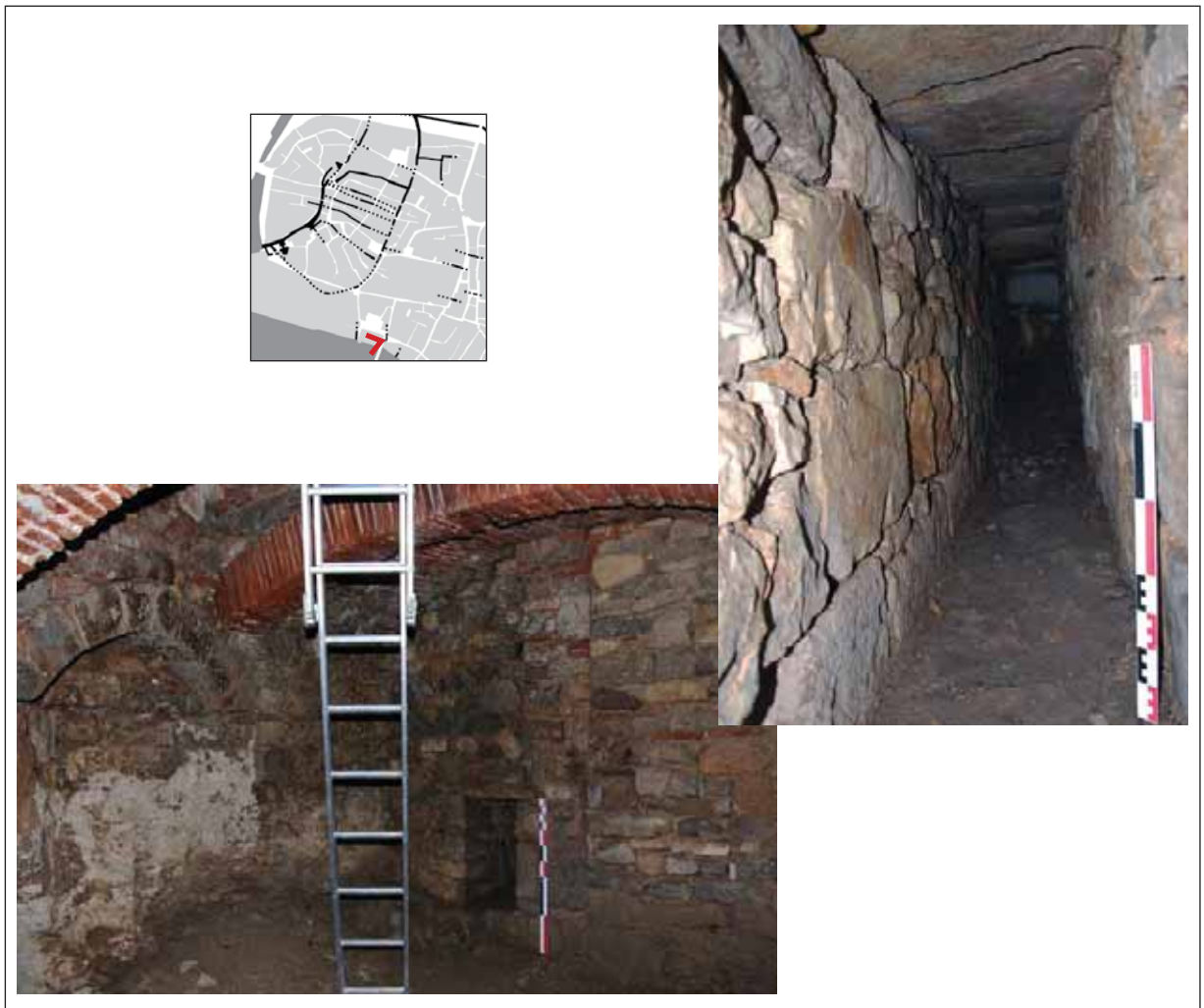
Fig. 439 : canal transversal observé au niveau de la sixième arche du pont sur l'Aveyron
