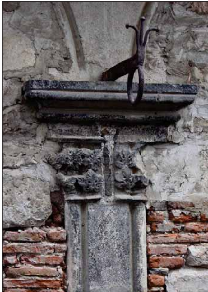
Fig. 325 : porte bannes formé d'un anneau surmonté de trois antennes, placé dans le joint au-dessus du trumeau des baies géminées du second étage de la maison ID 17
