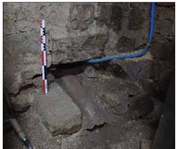
Fig. 478 : canalisation insérée dans la maçonnerie de la maison ID94
