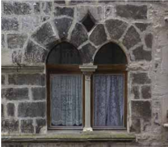
Baie géminée du premier étage de la maison ID56
