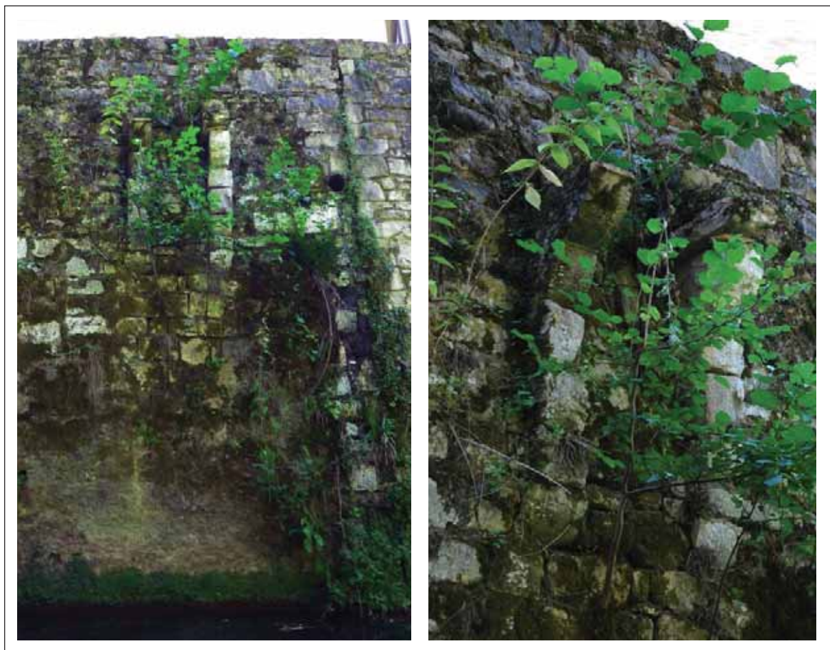
Fig. 101 : vestiges d'une bretèche sur le mur ouest de clôture de l'abbaye, avec un coup de sabre à droite
