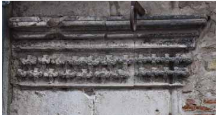
Cordon d'appui de la maison ID17
