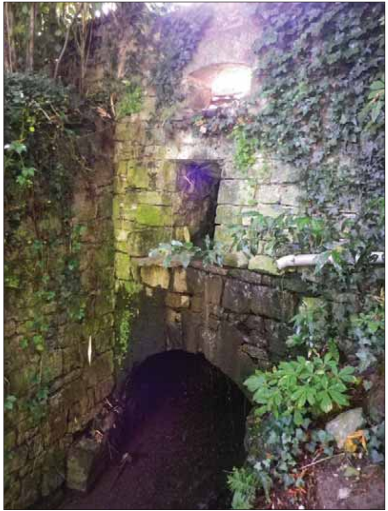
Fig. 388 : canal de la dérivation supérieure avant son entrée en ville, au niveau du boulevard
