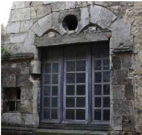
Baie géminée du premier étage de la maison ID109
