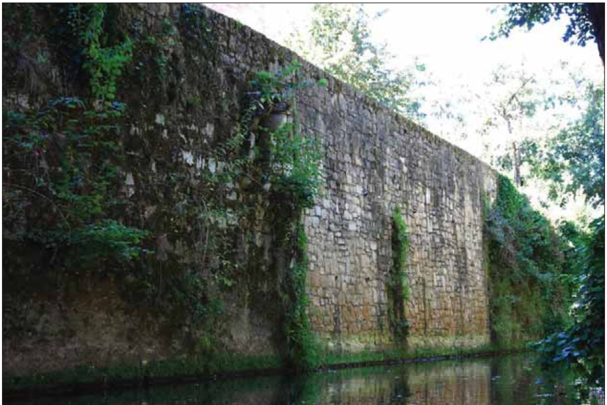
Fig. 99 : mur de clôture de l'abbaye sur la Bonnette La partie du mur plus claire correspond à une reprise, peut-être le bouchage de la porte.
