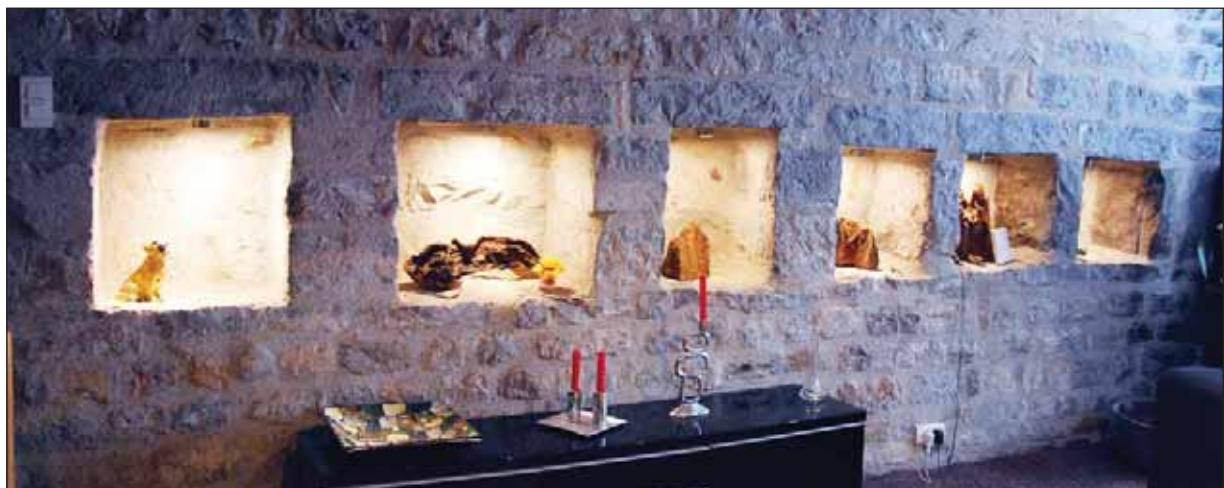
Fig. 238 : succession de niches au second étage de la maison n°3 rue Saint-Angel
