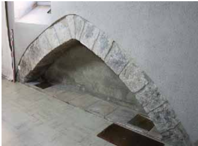
Arcades du mur ouest, vues de l'est, à l'intérieur
