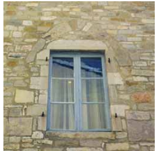
Vestige d'une baie au premier étage du mur ouest
