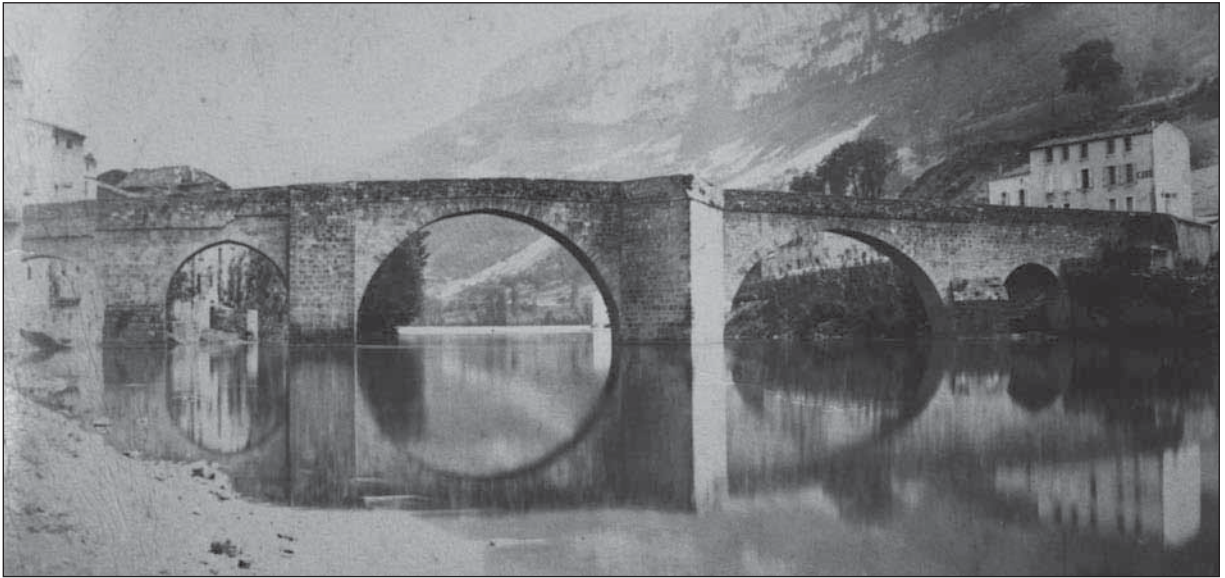
Fig. 137 : le pont sur l'Aveyron avant 1873, vu depuis l'ouest (AC Saint-Antonin, O216)
