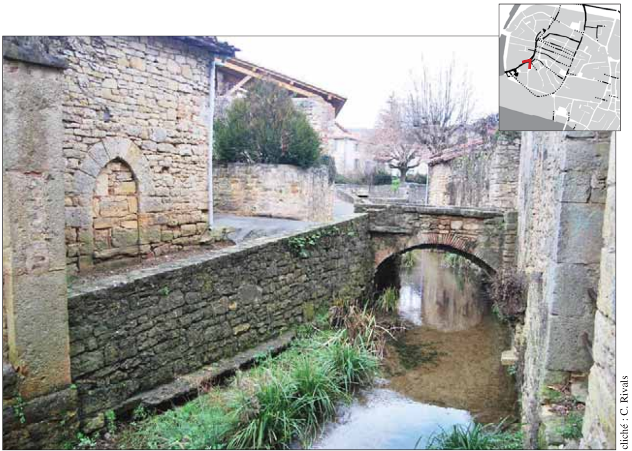
Fig. 412 : canal de la dérivation inférieure dans le quartier du Bessarel, vu depuis le sud
