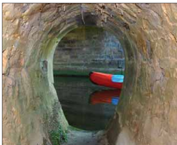
Fig. 197 : sortie vers la Bonette de l'aqueduc moderne qui draine l'eau du fossé
