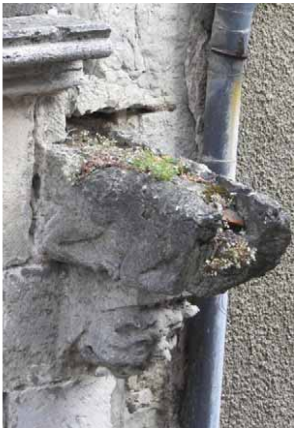
exutoire sud de la maison ID 17, rue de la Pélisserie
