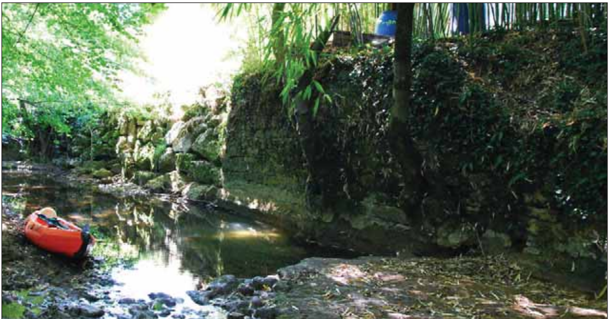
Fig. 377 : aménagement de berge correspondant à la lettre A sur la figure 370, construit au XVII e siècle en vue d'assécher le méandre
