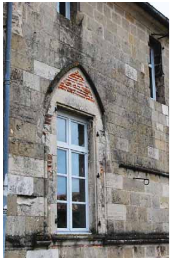
Baie du deuxième étage de la maison ID73
