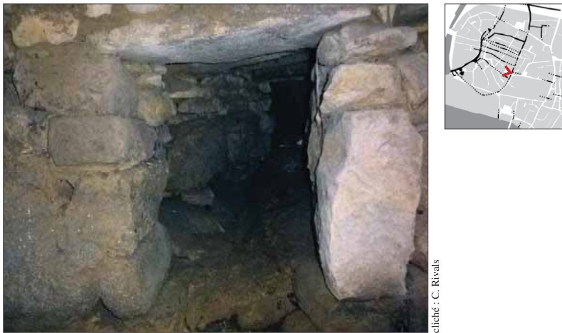
Fig. 437 : canal orienté est-ouest, vu vers l'est, se jettant dans le canal de la dérivation supérieure, observé dans la maison ID228
