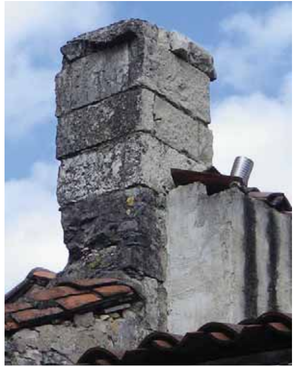
Souche quadrangulaire en pierre de la cheminée placée sur le mur pignon de la maison ID17
