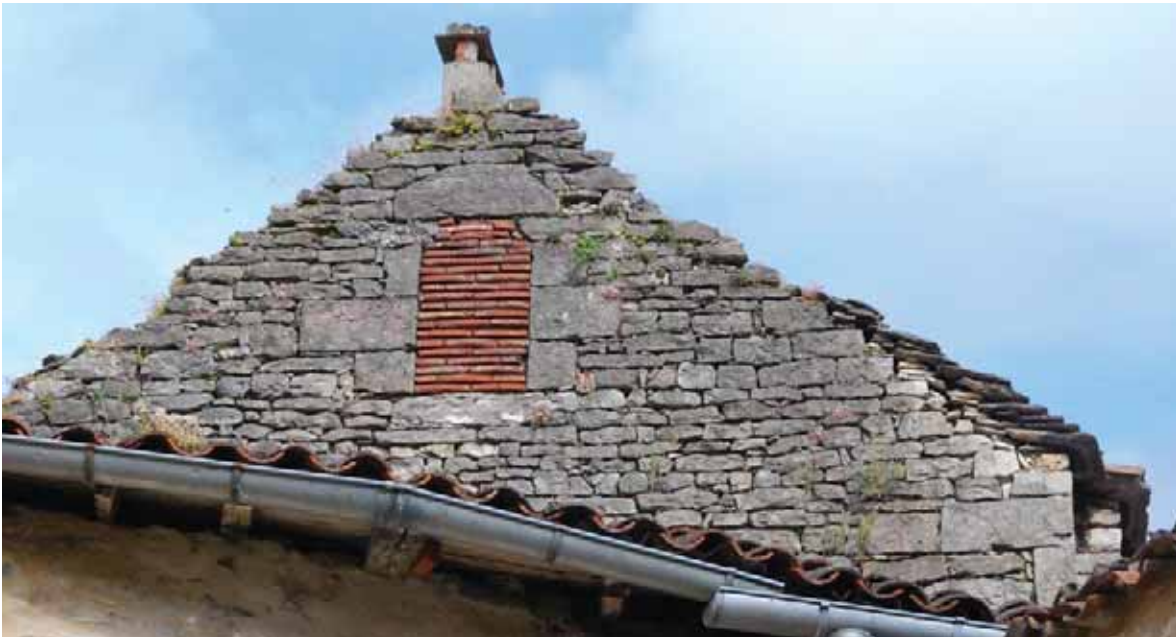
Vestiges de toiture en lauzes sur le pignon de la maison ID217
