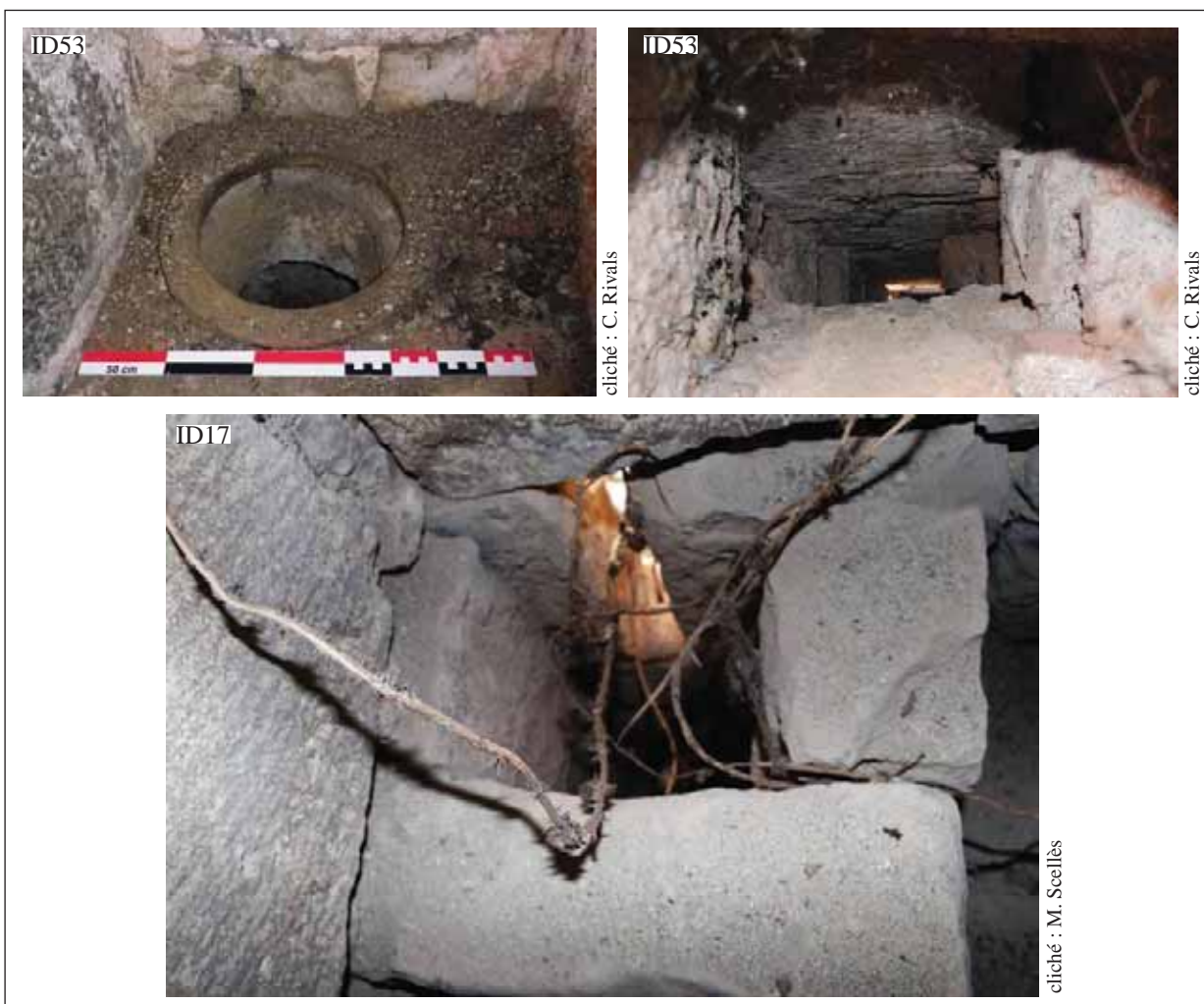
Fig. 473 : conduits d'évacuation de latrines insérés dans la maçonnerie des maisons ID 17 et 53
