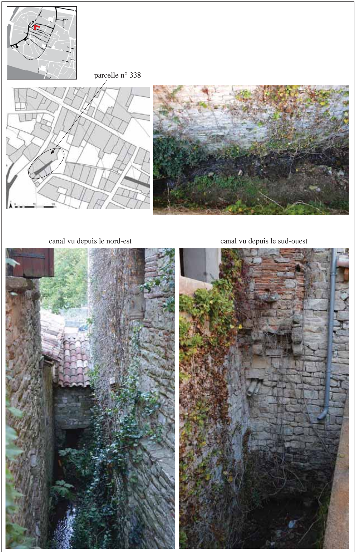
Fig. 429 : canal transversal à ciel ouvert dans le moulin M
