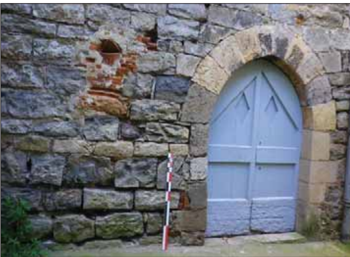
Fig. 178 : côté sud de la ruelle de la Sabaterie (D)
