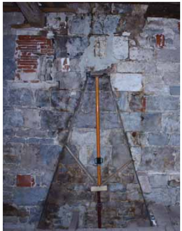
Hotte triangulaire de la cheminée placée sur le mur pignon de la maison ID17
