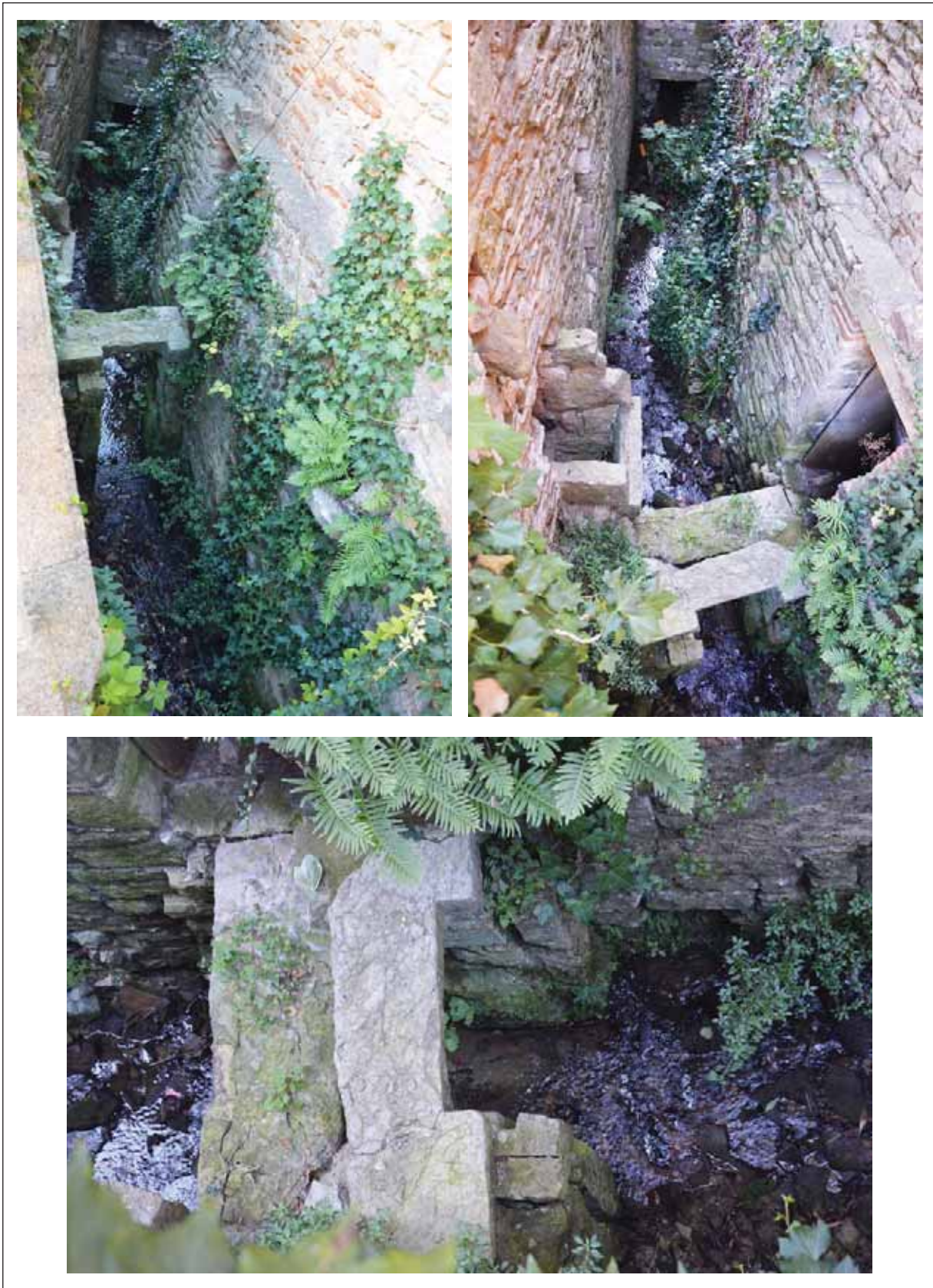
Fig. 430 : vestiges d'un système de vannes au niveau du canal transversal à ciel ouvert dans le moulon M
