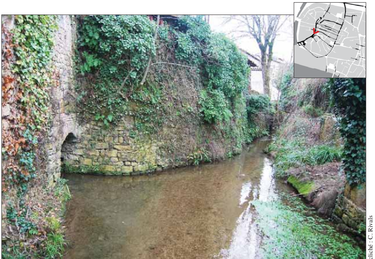
Fig. 413 : canal de la dérivation inférieure dans le quartier du Bessarel, vu depuis le nord
