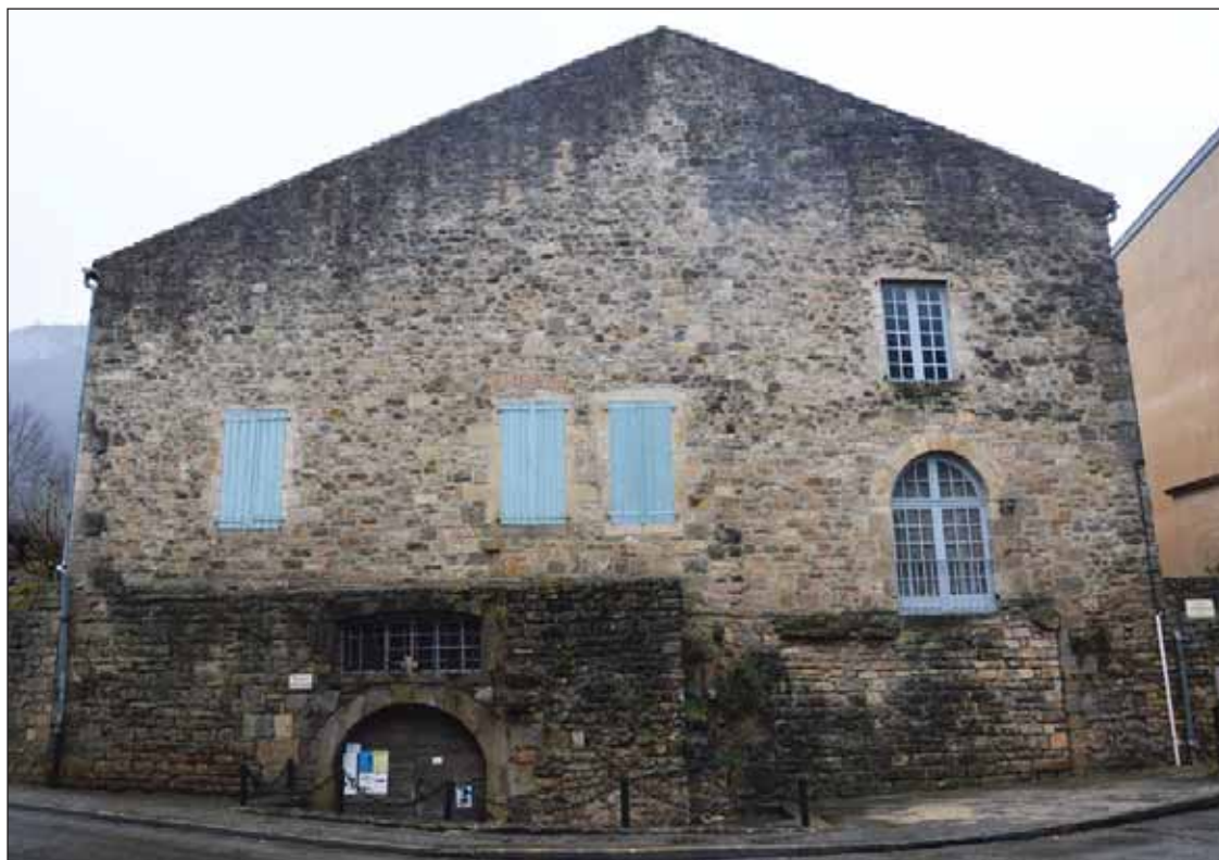
Fig. 89 : façade nord de l'actuel presbytère La porte à gauche donne accès à l'ancien chai. Au centre se trouve la section du mur arraché.
