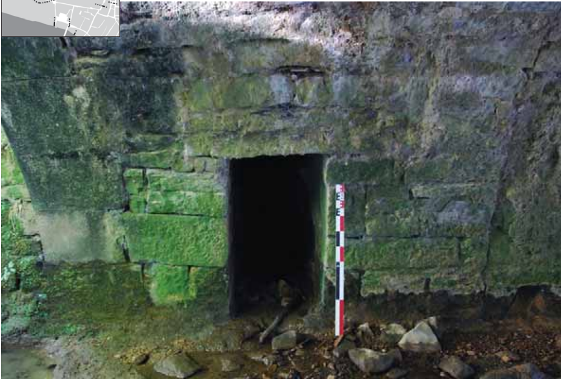
sortie du canal transversal sur le canal de la dérivation inférieure
