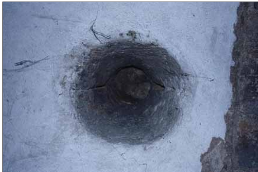
Fig. 483 : ouverture percée dans la voûte au rez-de-chaussée de la maison ID 206, rue Rive Valat
