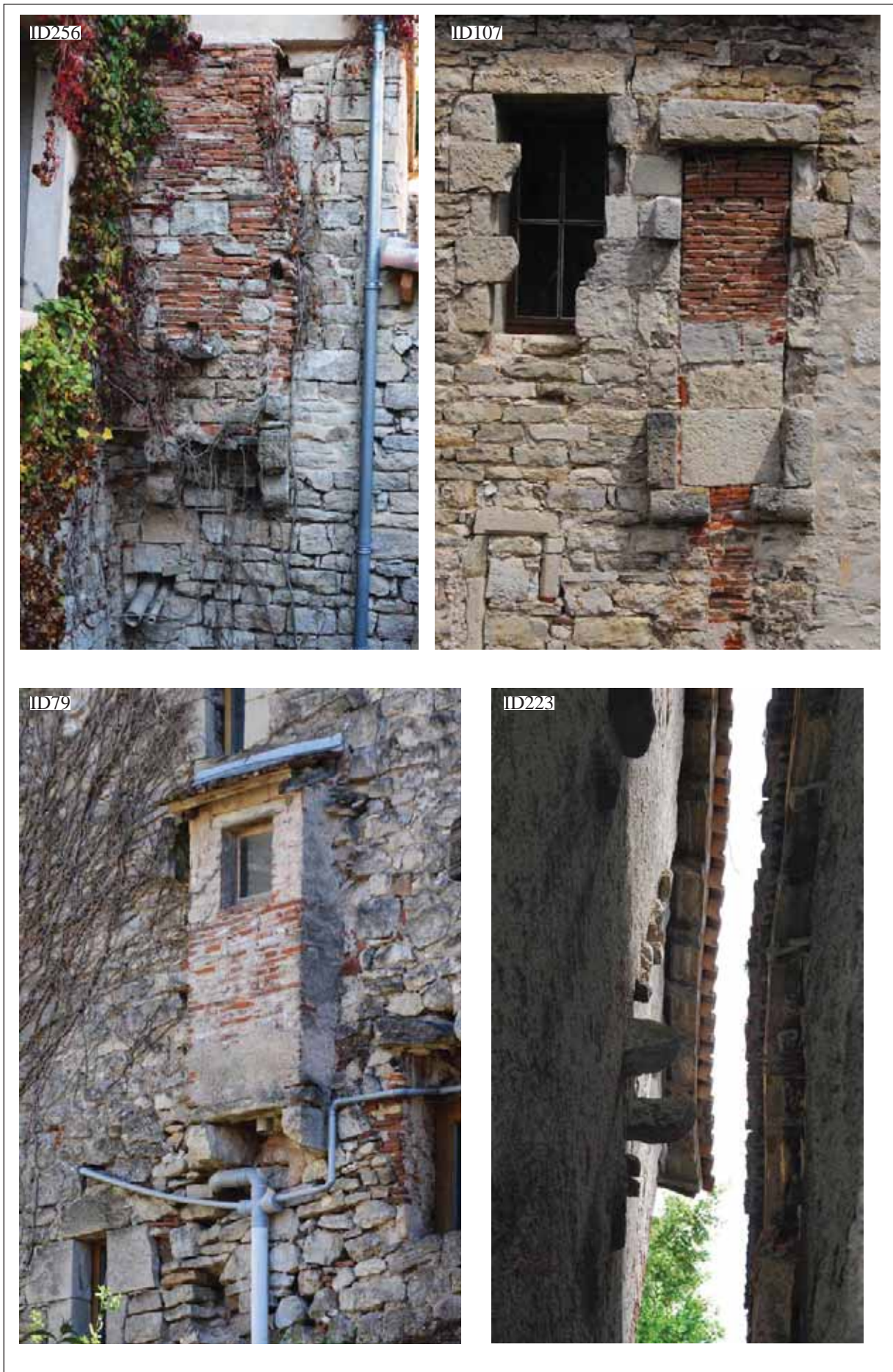
Fig. 474 : latrines en encorbellement au-dessus d'un canal ou d'une venelle
