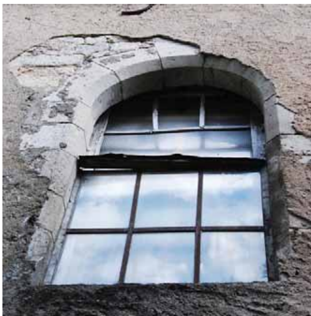
Fenêtre en plein cintre du mur gouttereau oriental
