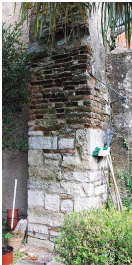
Contrefort de l'église
