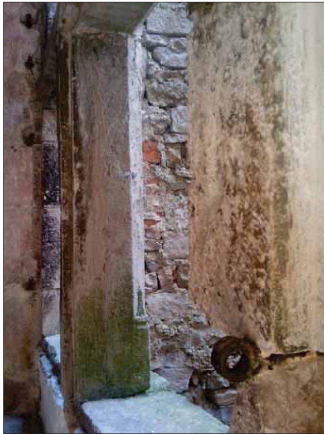
Fig. 232 : système de fermeture d'une baie géminée de la maison ID13
