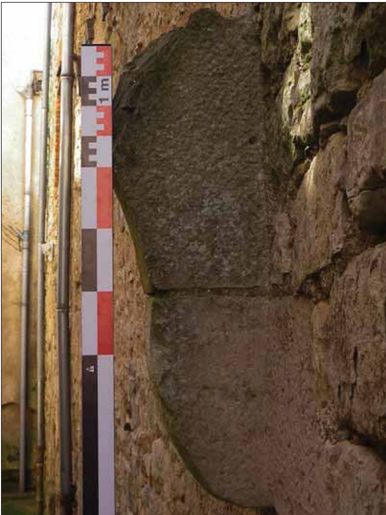
Fig. 149 : corbeau de la façade latérale de la maison ID83
