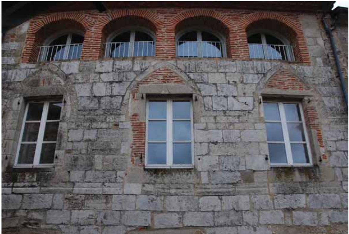
Baies du deuxième étage de la maison ID72
