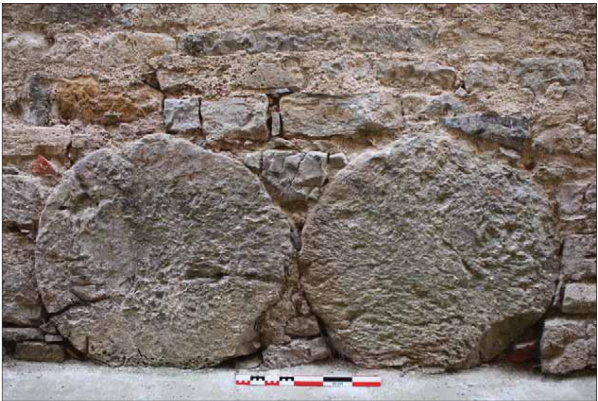
Fig. 115 : tambours de fûts de colonnes en remploi dans la maçonnerie de la maison ID191
