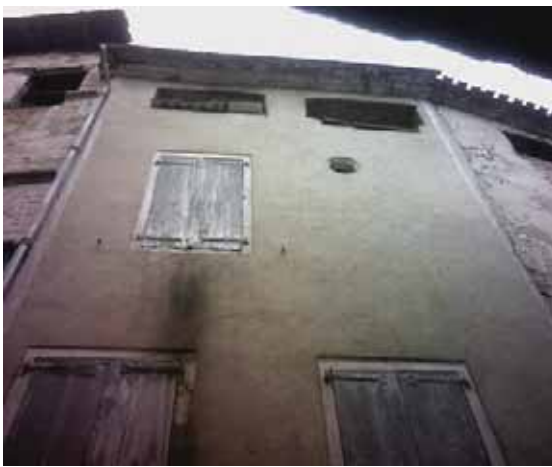
Maison ID220, rue de la Porte Rodanèse Baie géminée dissimulée sous le crépis au deuxième étage
