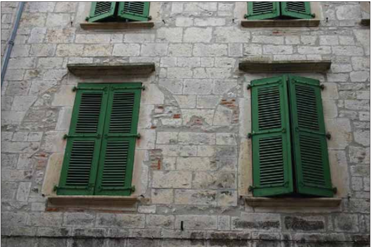
Fig. 3 : vestiges de baies géminées au premier étage de la façade sur la place de la Halle
