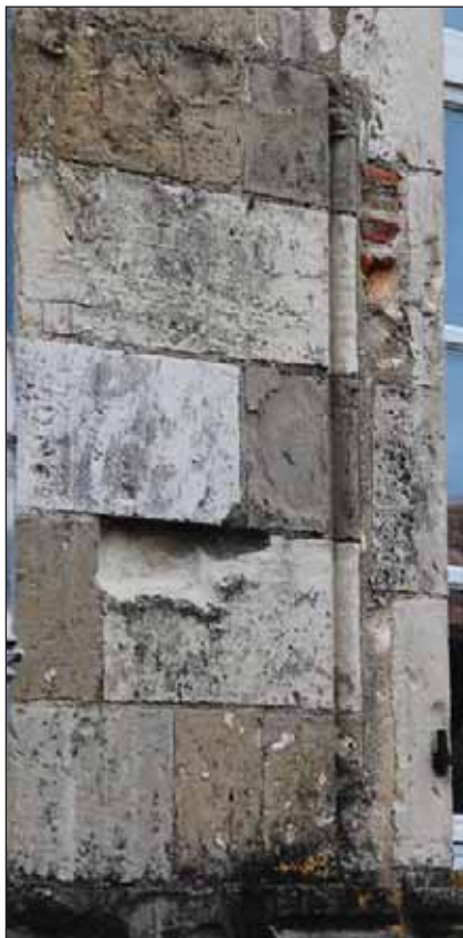
Fig. 9 : piédroit de la baie à remplage du deuxième étage de la partie nord
