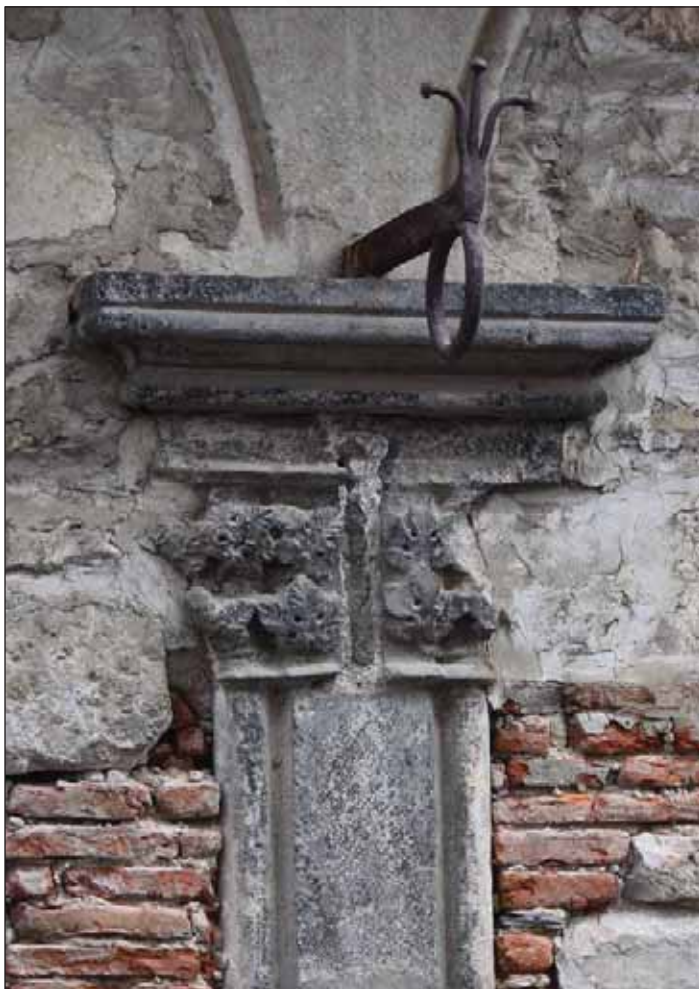
Fig. 11 : trumeau entre les baies géminées du second étage
