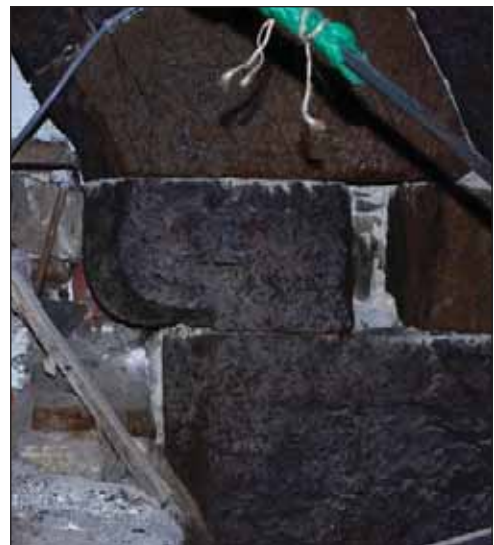
Fig. 16 : détail du chanfrein de l'arcade du mur oriental au rez-de-chaussée
