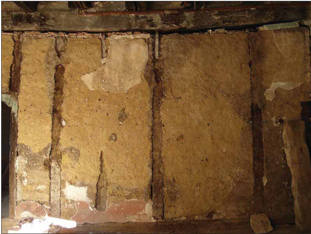
Fig. 25 : cloison en pan-de-bois et torchis séparant le deuxième étage du corps de bâtiment A
