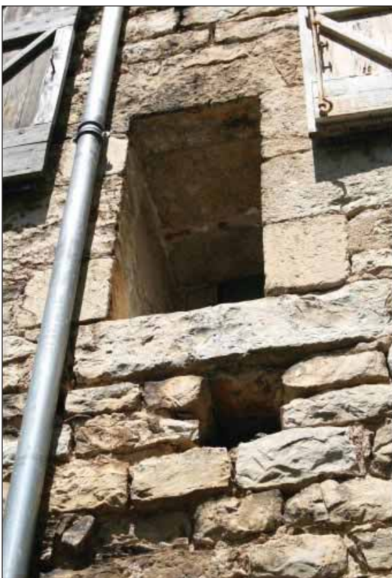
Fig. 3 : vestige d'une baie géminée, au premier étage de la façade ouest sur la rue du Pont des Vierges
