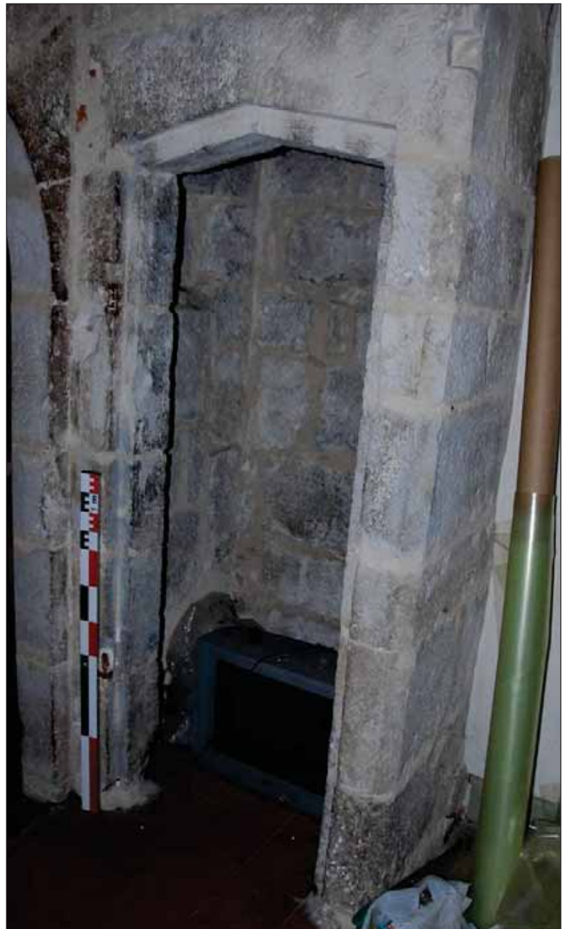
Fig. 34 : latrines contre le mur de refend du premier étage
