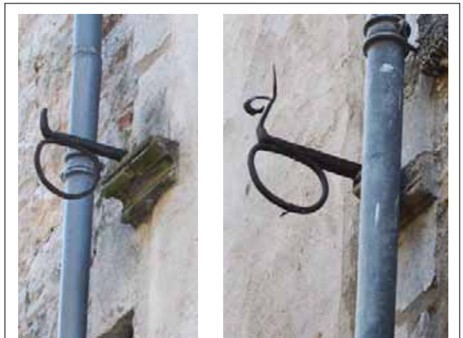
Fig. 3 : porte-bannes du premier étage A gauche, porte-bannes de l'extrémité sud de la façade, à droite, porte-bannes de l'extrémité nord de la façade.
