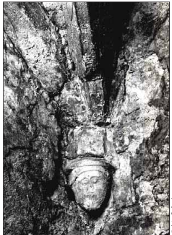
Fig. 4 : retombée des ogives sur un culot sculpté d'une tête, à l'angle nord-ouest de la pièce A2
