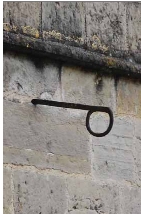
Fig. 10 : porte-bannes du deuxième étage sur la façade sur la place de la Halle
