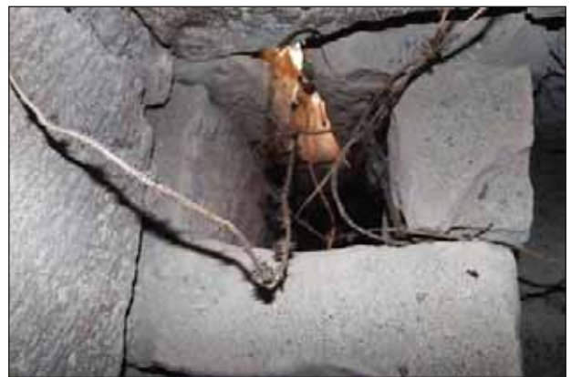
Fig. 31 : conduit de latrines ménagé dans l'épaisseur du mur nord
