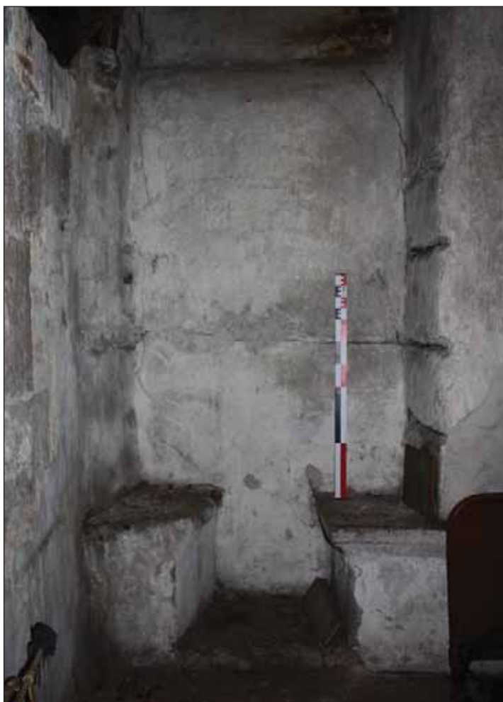
Fig. 19 : grand appareil de pierre de taille du mur ouest au troisième étage
