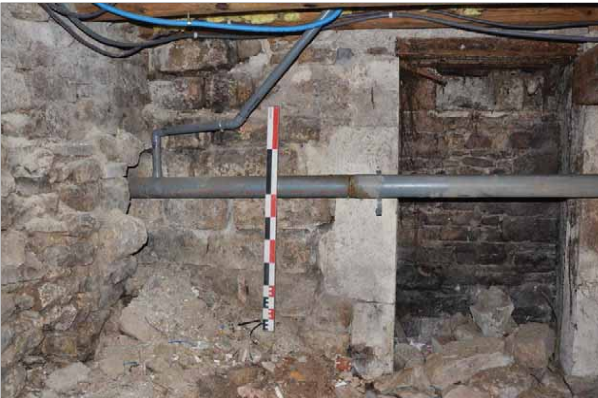
Fig. 13 : porte murée dans le mur ouest
