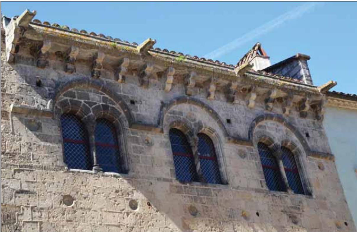
Fig. 6 : système d'évacuation de l'eau de pluie au-dessus du deuxième étage
