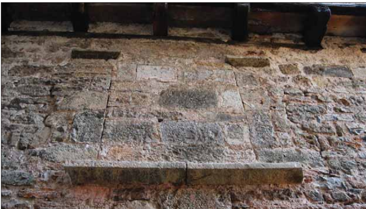
Fig. 4 : fenêtre bouchée du premier étage de la partie centrale de la parcelle
