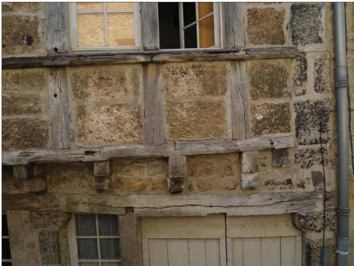
Fig. 7 : pan-de-bois du premier étage sur la rue Droite
