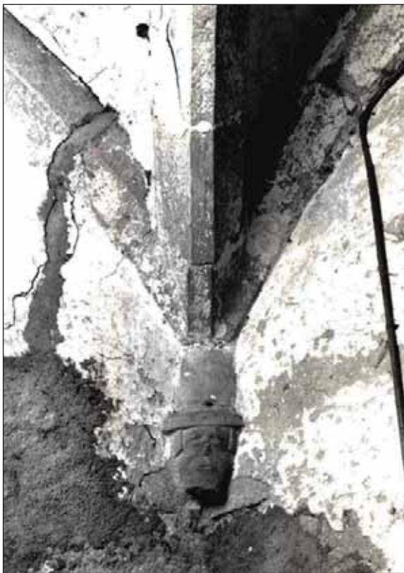
Fig. 3 : retombée des ogives sur un culot sculpté d'une tête, à l'angle sud-ouest de la pièce A2
