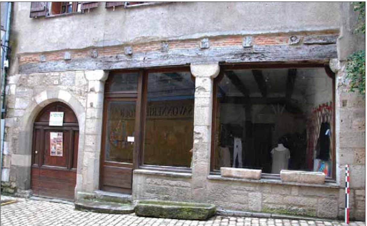
Fig. 3 : rez-de-chaussée sur la place de la Halle
