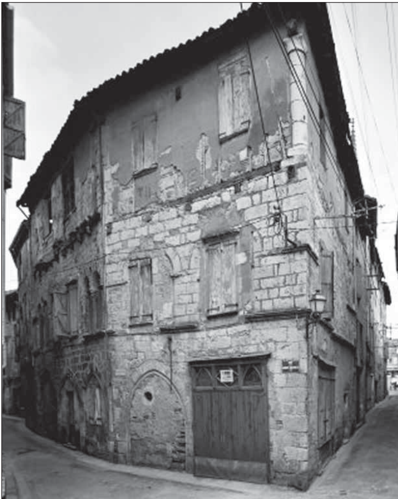
Fig. 4 : élévations sur la rue des Grandes Boucheries, avant restauration
