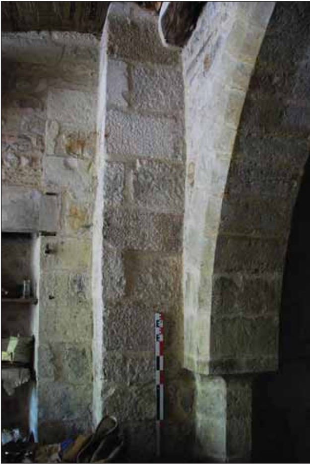
Fig. 30 : pilier de l'arc soutenant le plancher du premier étage, dans la pièce orientale de la partie ouest du rez-de-chaussée
