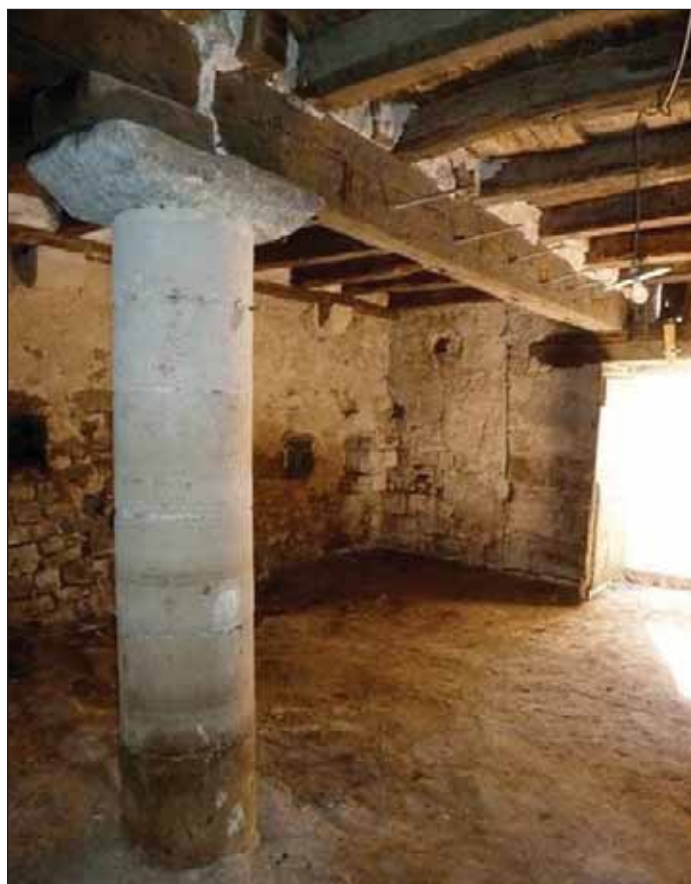
Fig. 17 : colonne du rez-de-chaussée supportant le plancher de l'entresol
