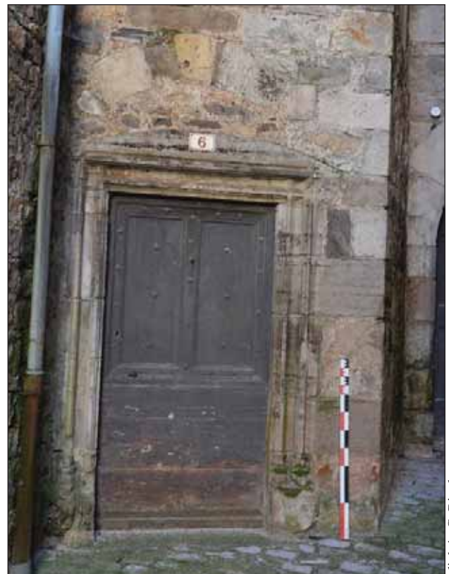
Fig. 11 : porte d'accès à la tour d'escalier
