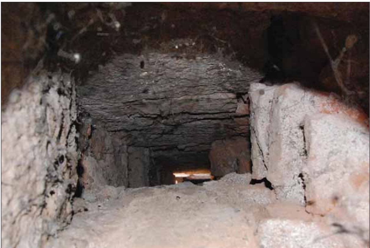
Fig. 16 : intérieur du conduit des latrines dans l'épaisseur de la maçonnerie
