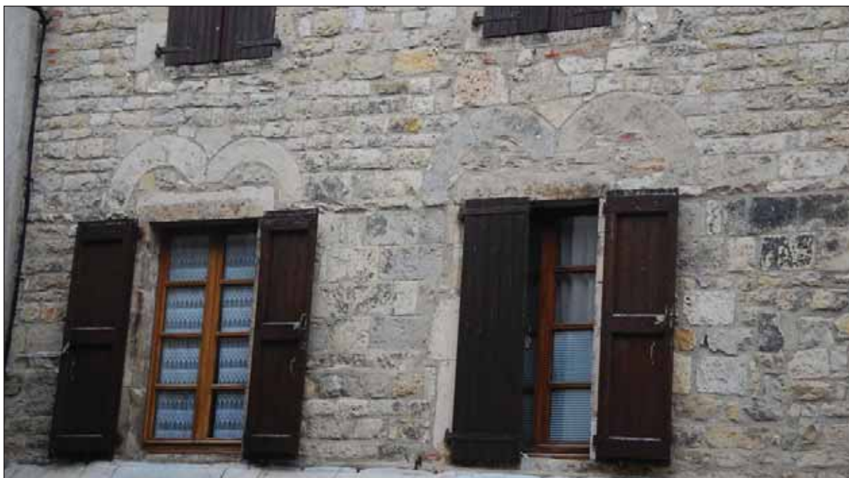
Fig. 4 : arcs monolithes des baies géminées du premier étage de la façade sur la place du Buoc
