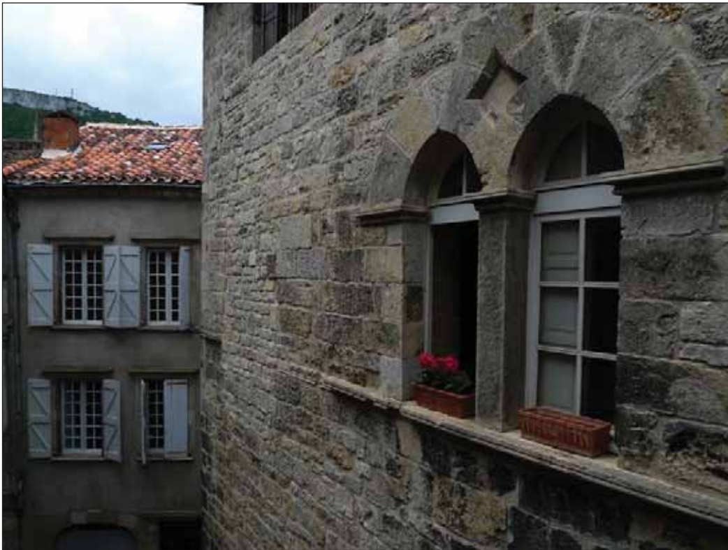
Fig. 3 : baie géminée de la façade orientale sur la rue du Four Neuf
