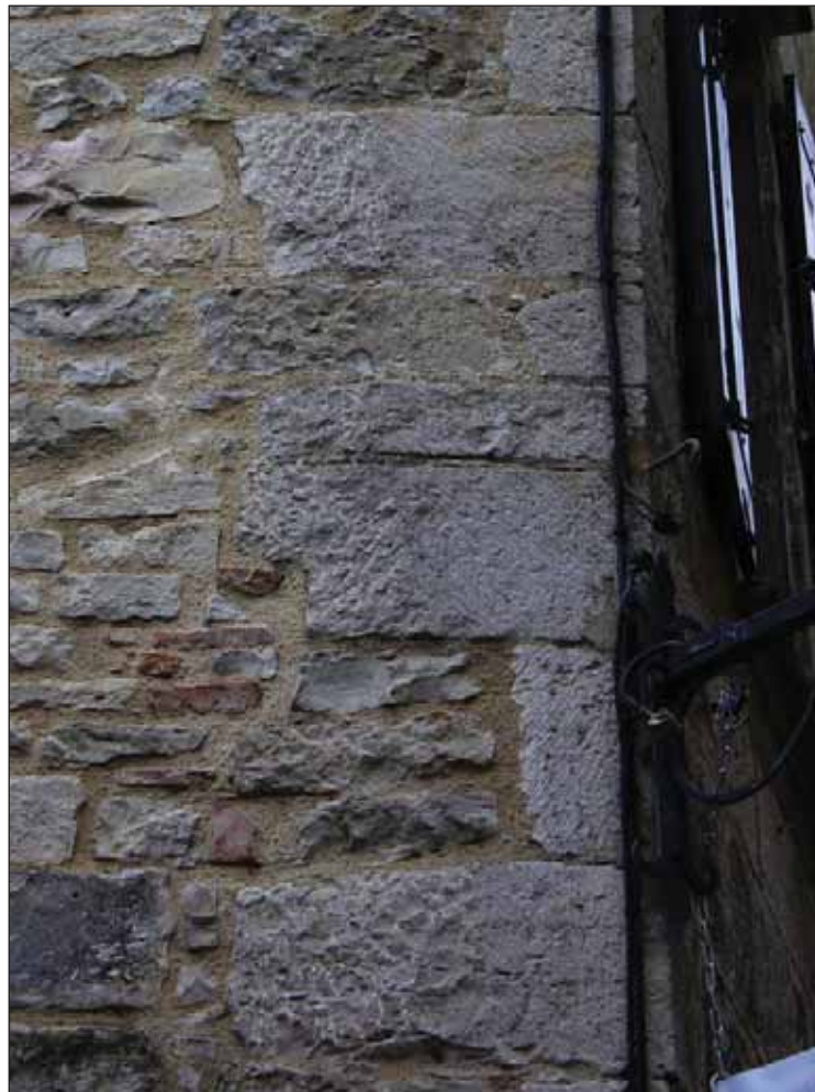
Fig. 6 : chaîne d'angle sur la rue Rive-Valat
