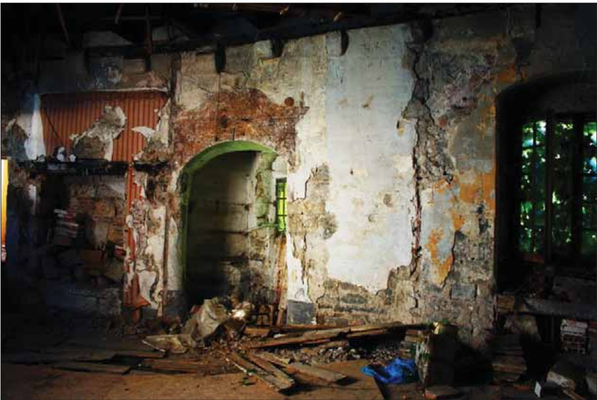
Fig. 22 : mur sud de la pièce 1 du premier étage du corps de bâtiment A En partant de la gauche : niche d'évier h et croisée g.
