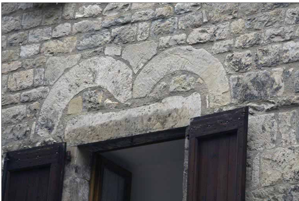
Fig. 5 : arcs monolithes d'une baie géminée au premier étage de la façade sur la place du Buoc
