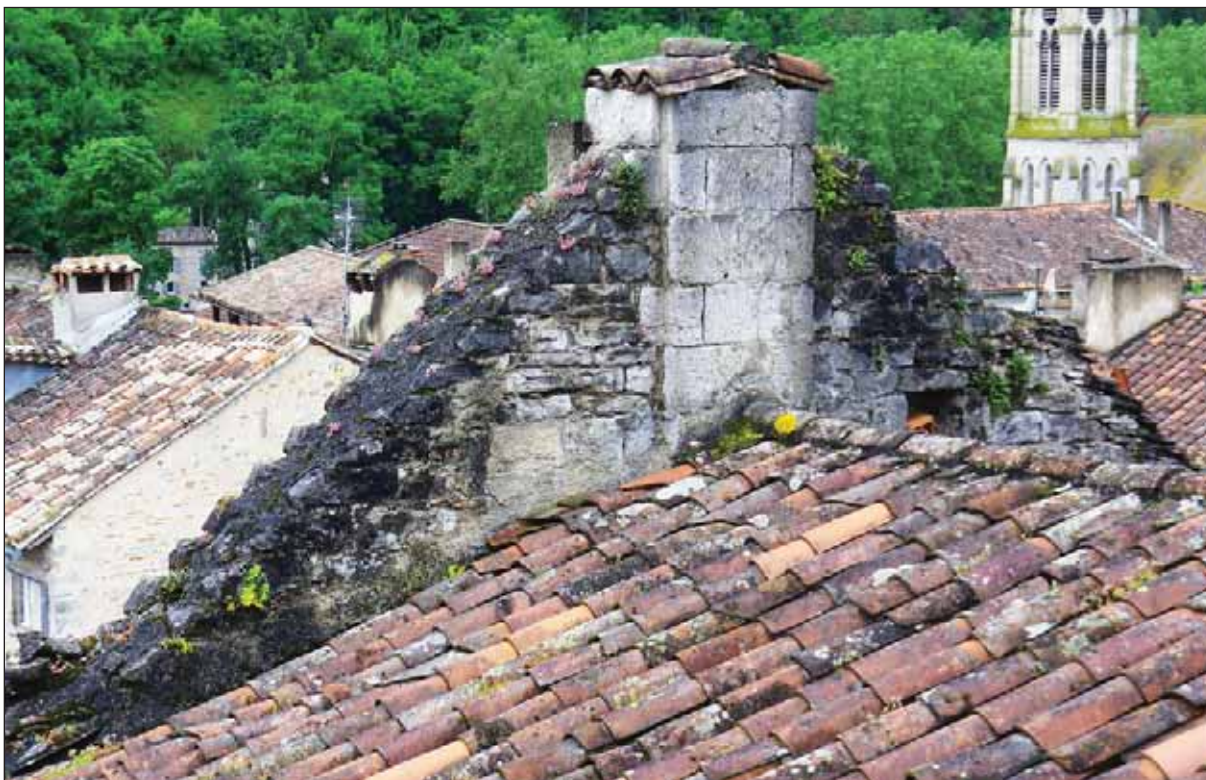
Fig. 11 : souche de la cheminée et vestiges du toit couvert de lauzes sur le mur pignon sud, vus depuis le nord
