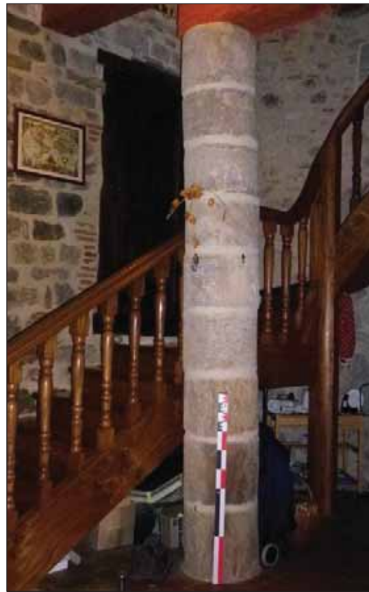
Fig. 8 : colonne à tambours soutenant le plancher du premier étage
