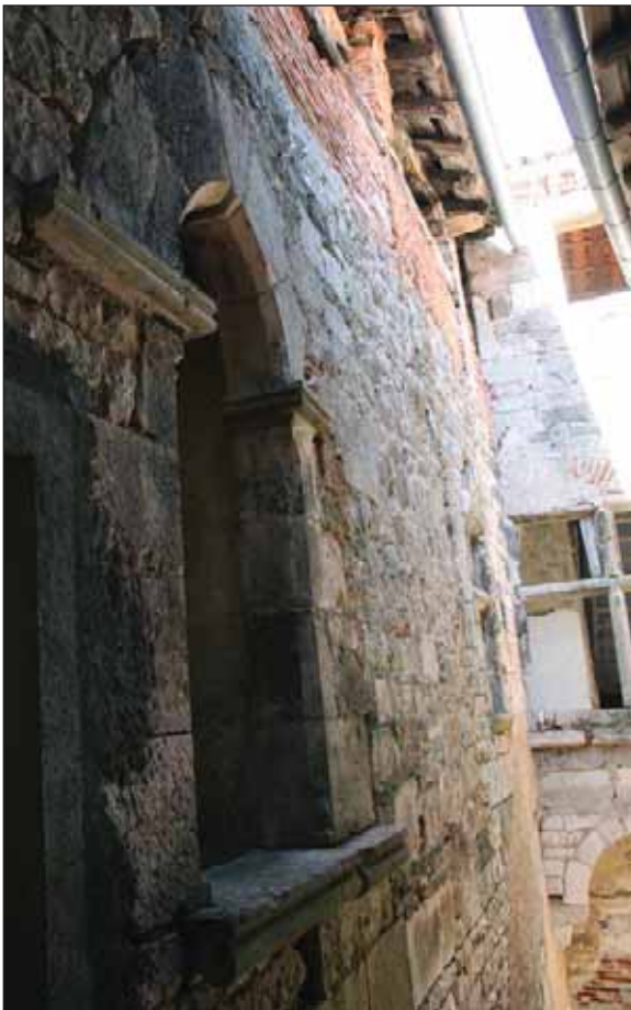
Fig. 26 : baie géminée réduite sur le mur nord au deuxième étage du corps de bâtiment A
