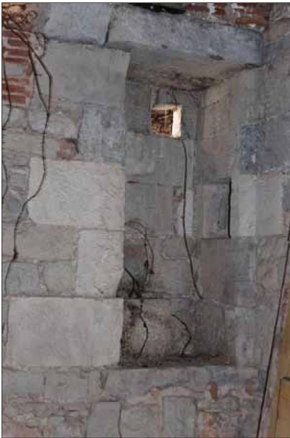
Fig. 30 : latrines dans l'épaisseur du mur nord, dans l'angle nord-est au deuxième étage
