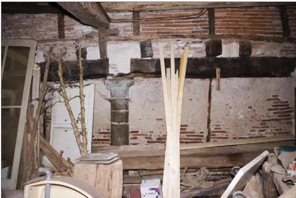
Fig. 8 : rez-de-chaussée, colonne portant une poutre de support de plancher à la jonction des parcelles A et D
