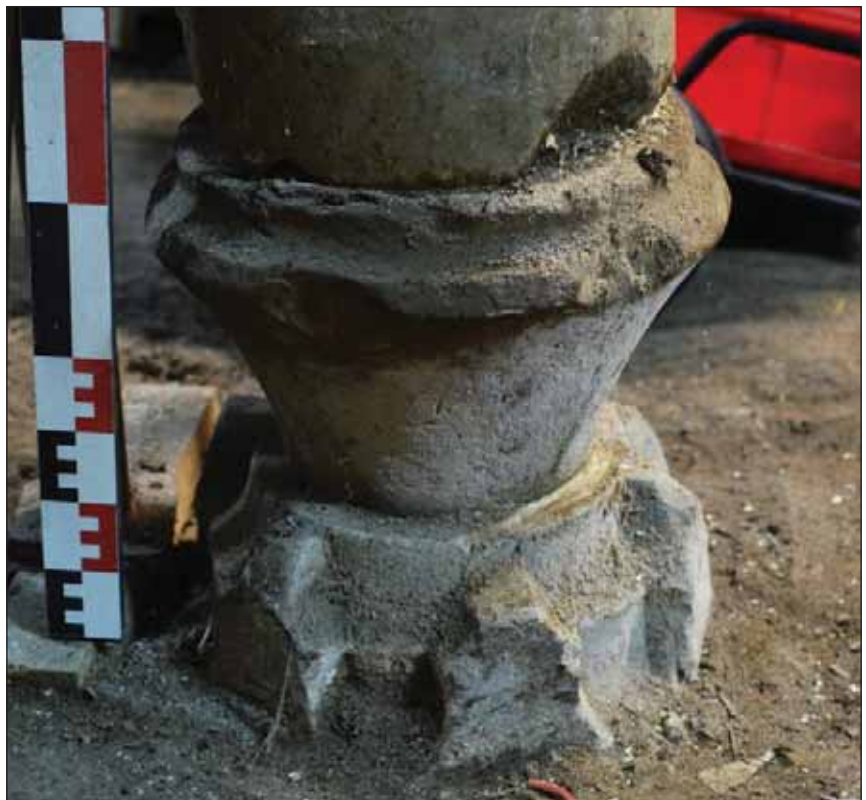
Fig. 6 : clef de voûte en remploi comme base de colonne au rez-de-chaussée
