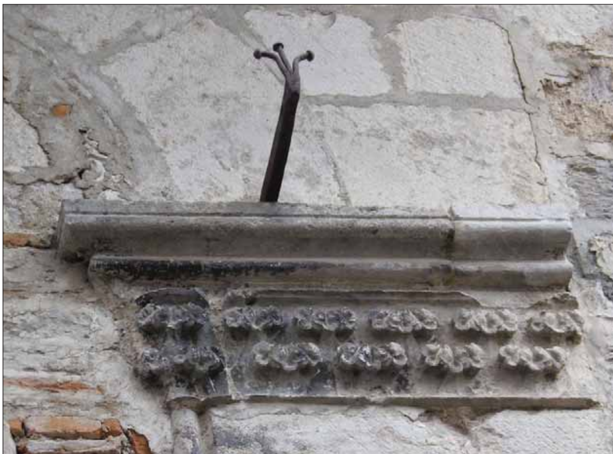
Fig. 12 : cordon d'imposte de la baie géminée de droite au deuxième étage
