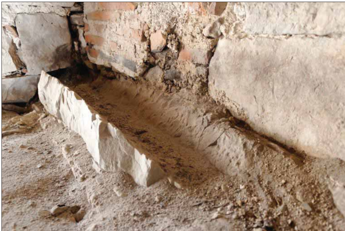
Fig. 16 : détail d'une pierre du chéneau au sommet du mur sud
