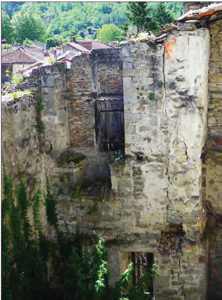
Fig. 37 : croisée à coussièges et peintures murales au premier étage, sur le mur ouest du corps de bâtiment G
