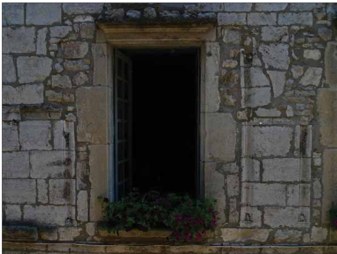
Fig. 11 : fenêtre moderne remplaçant une baie géminée transformée en croisée au premier étage
