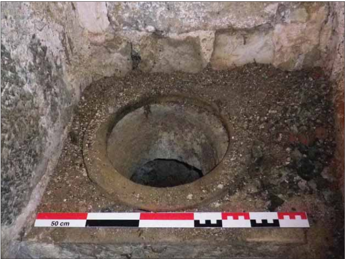
Fig. 15 : banquette maçonnée et conduit d'évacuation des latrines
