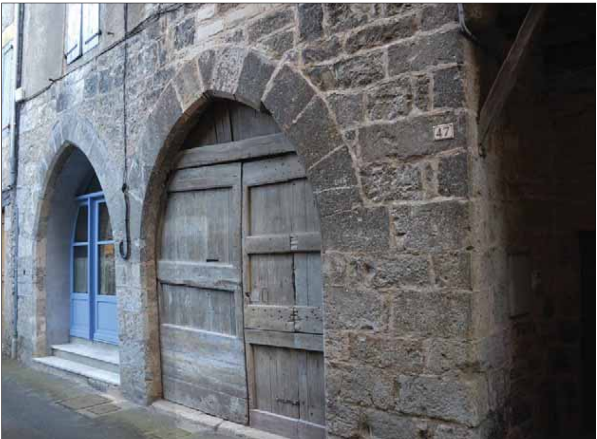
Fig. 2 : arcades du rez-de-chaussée de la façade sur la rue Droite
