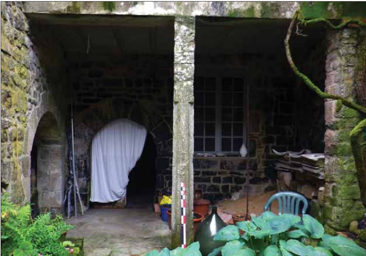
Fig. 12 : cour intérieure, au premier plan, meneau remployé en pilier
