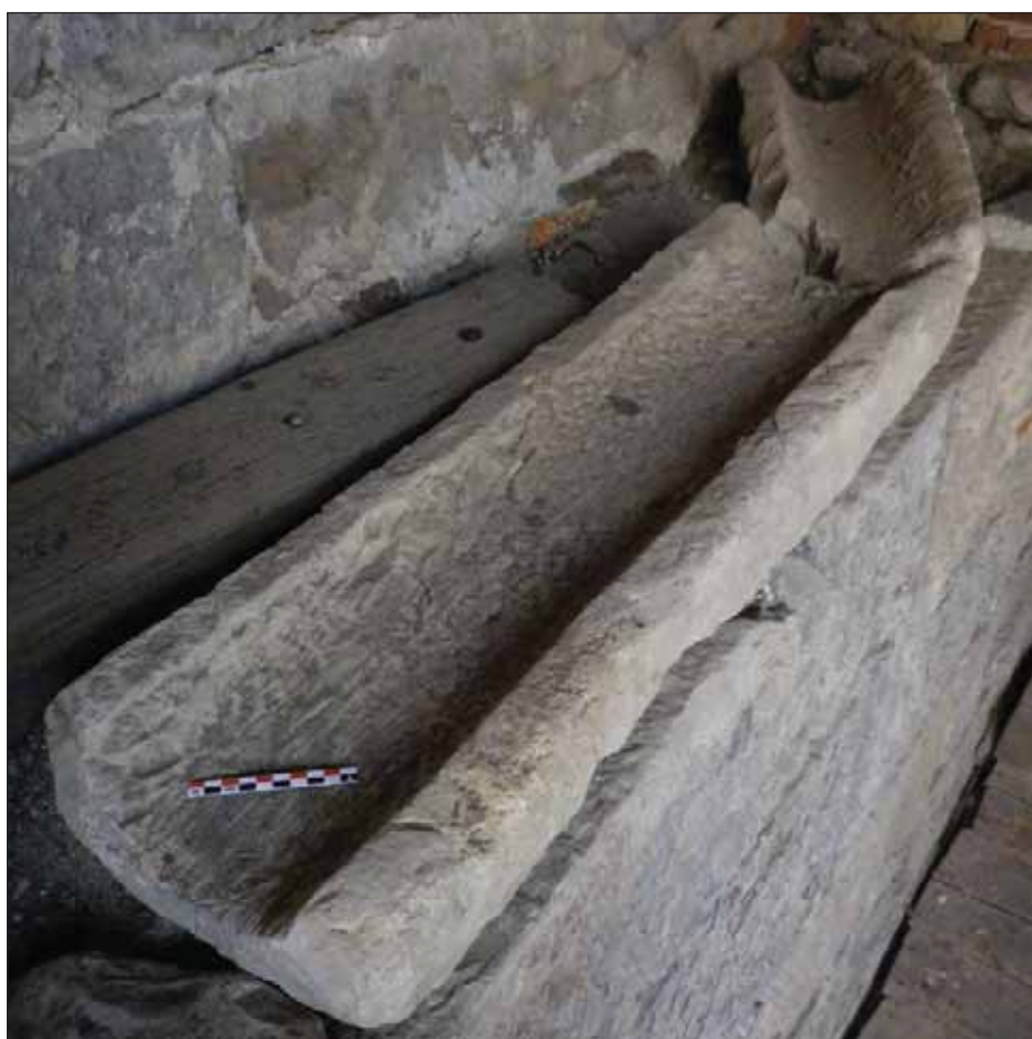
Fig. 17 : blocs calcaires appartenant à un chéneau déposé
