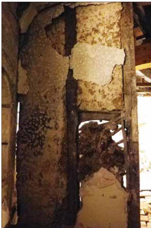
Fig. 18 : cloison e de la pièce 2 du premier étage du corps de bâtiment A
