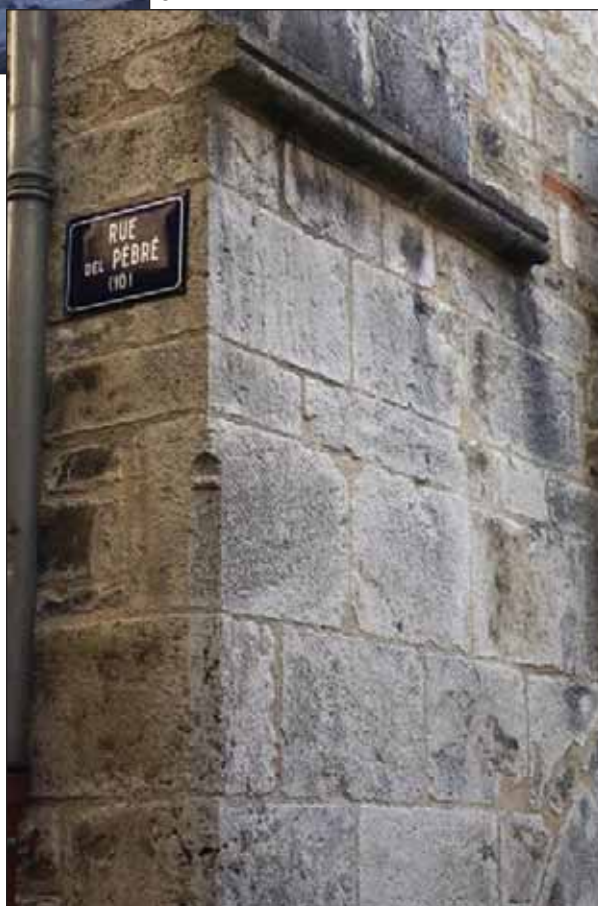
Fig. 2 : élévation sur la rue des Carmes, angle gauche chanfreiné et cordon d'appui
