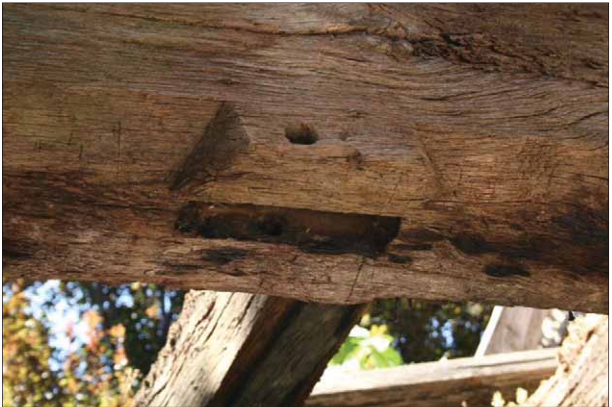
Fig. 3 : emplacement du poteau disparu, mortaise et trou de cheville, au rez-de-chaussée de la façade sur la rue du Pont des Vierges
