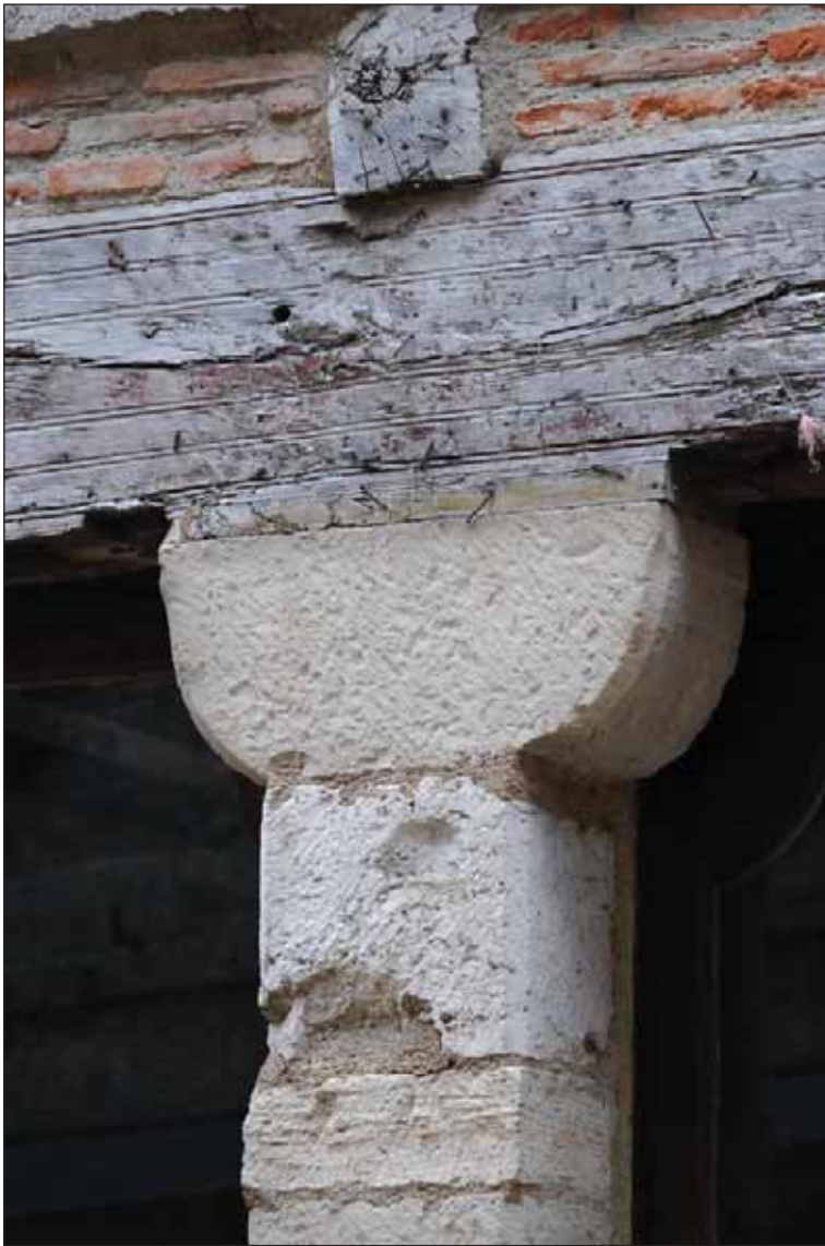
Fig. 2 : pilier soutenant la sa- blière basse du pan-de-bois
