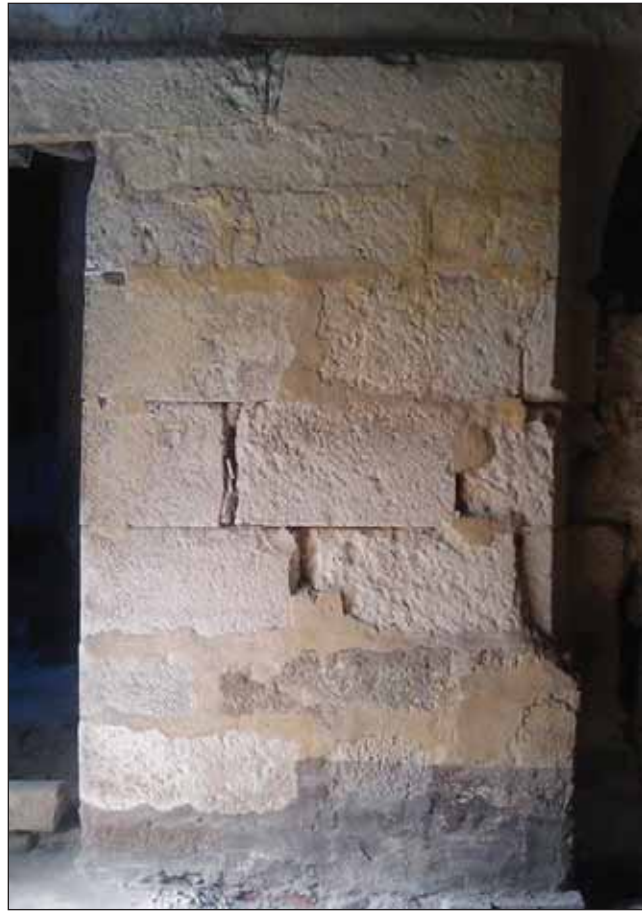
Fig. 23 : mur épaissi des latrines du deuxième étage
