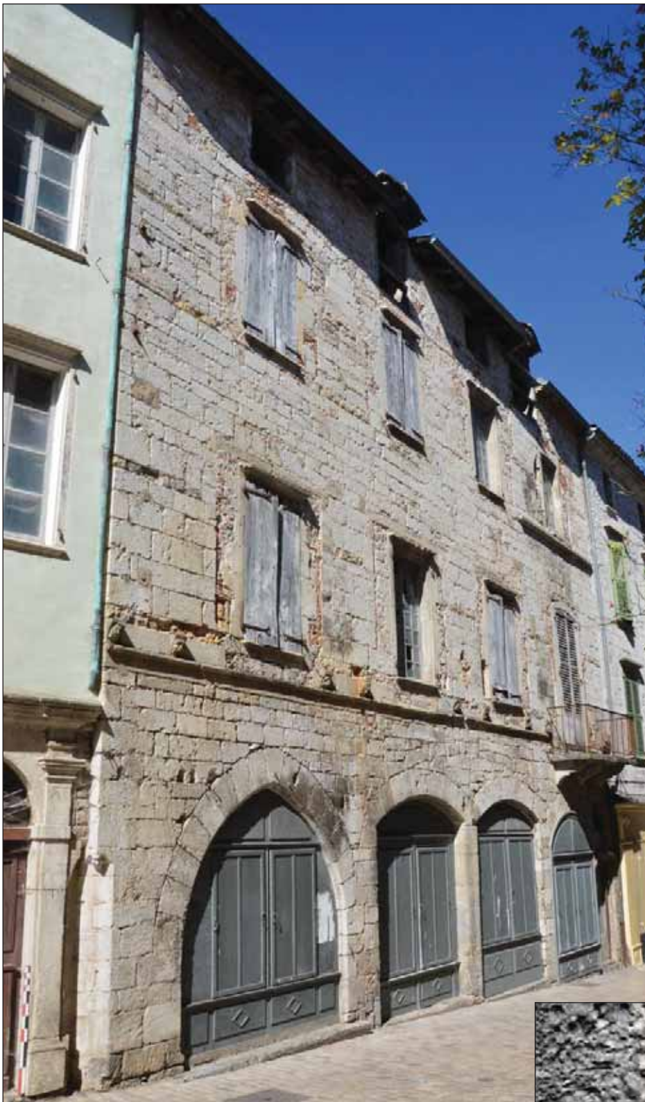
Fig. 6 : élévation du corps de bâtiment A, sur la place de la Halle
