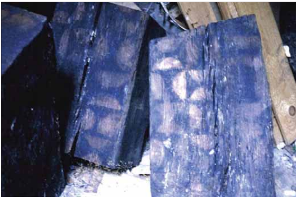
Fig. 16 : ancienne poutre de plancher portant l'empreinte d'un décor peint, déposée et débitée en morceaux en 1987, provenant de la pièce 1 du premier étage du corps de bâtiment A
