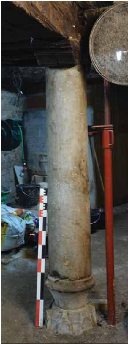
Fig. 5 : colonne soutenant le plancher du premier étage
