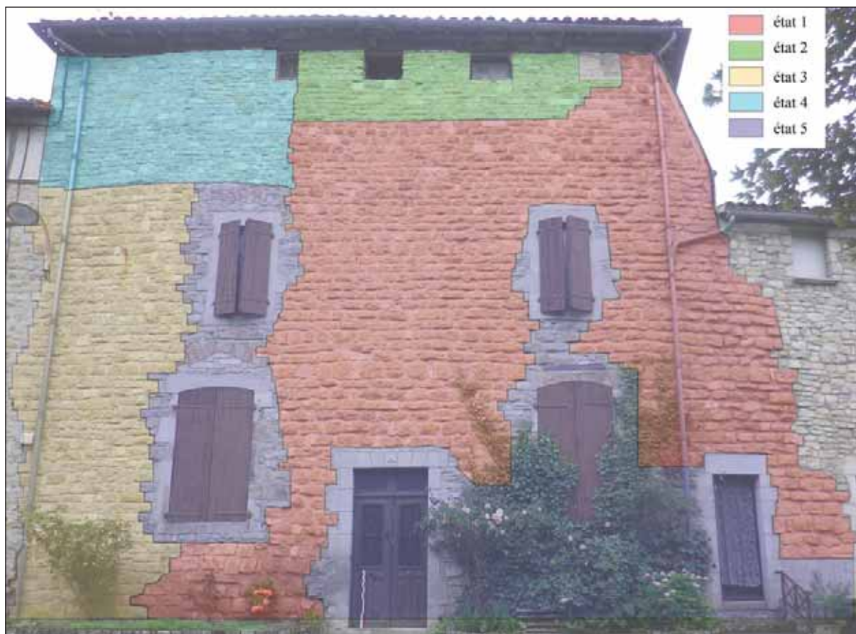
Fig. 19 : phasage des vestiges du rempart sur l'élévation orientale
