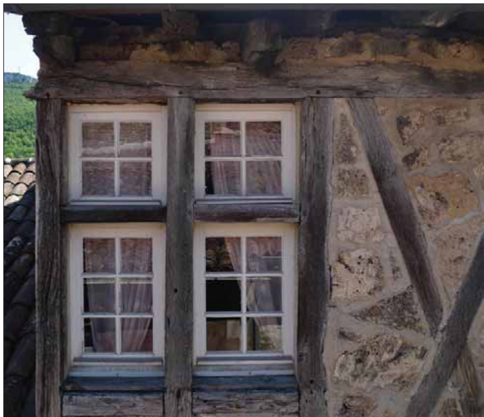
Fig. 8 : croisée du deuxième étage sur la rue Droite
