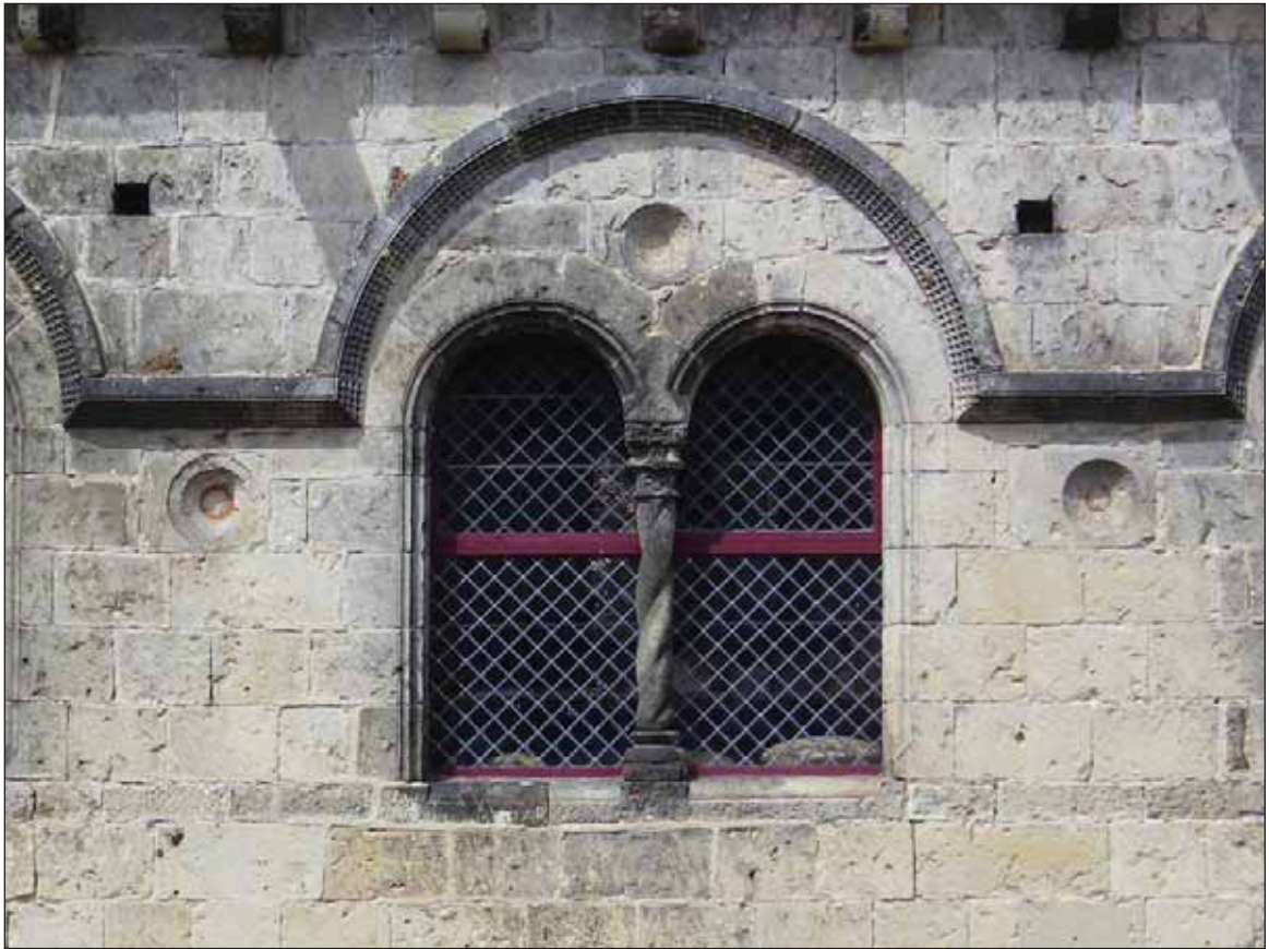
Fig. 20 : baie géminée centrale du deuxième étage et alvéoles destinées à recevoir les bacini
