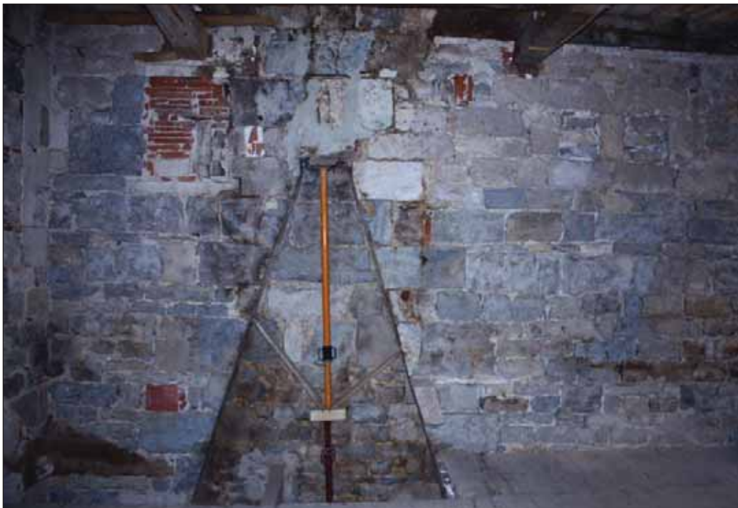
Fig. 27 : conduit de la cheminée visible au deuxième étage
