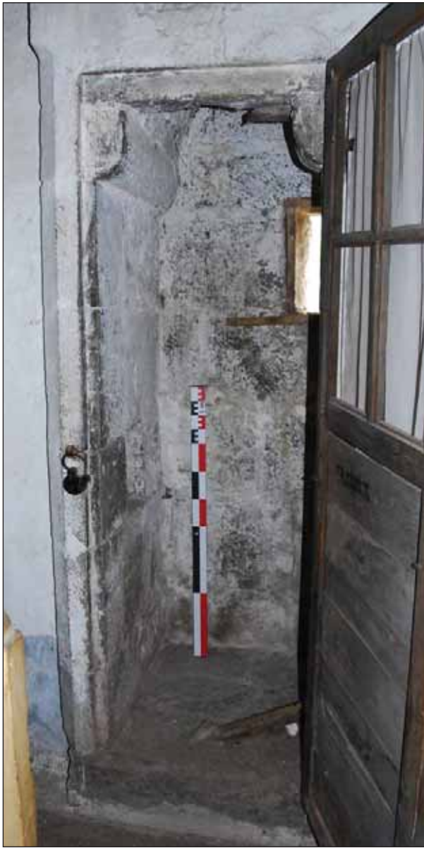
Fig. 13 : latrines placées dans le mur ouest, au deuxième étage
