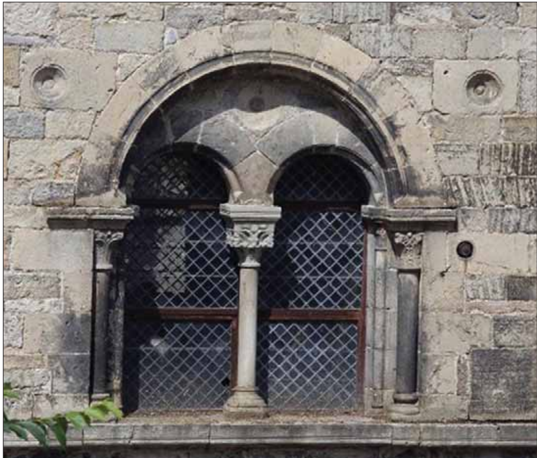
Fig. 21 : baie géminée du premier étage de la tour et alvéoles destinées à recevoir les bacini . La colonnette et le chapiteau ne sont pas ceux d'origine.
