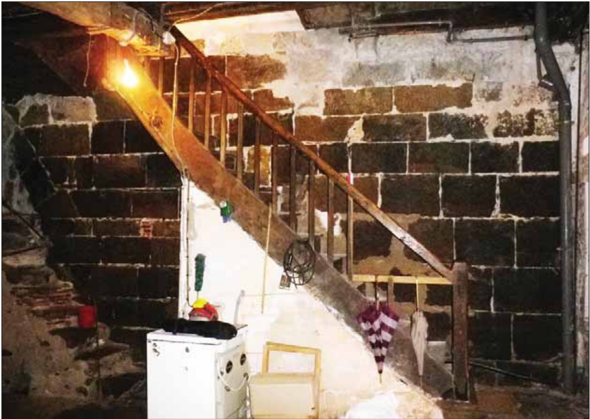
Fig. 14 : mur latéral oriental en grand appareil de pierre de taille, au rez-de-chaussée
