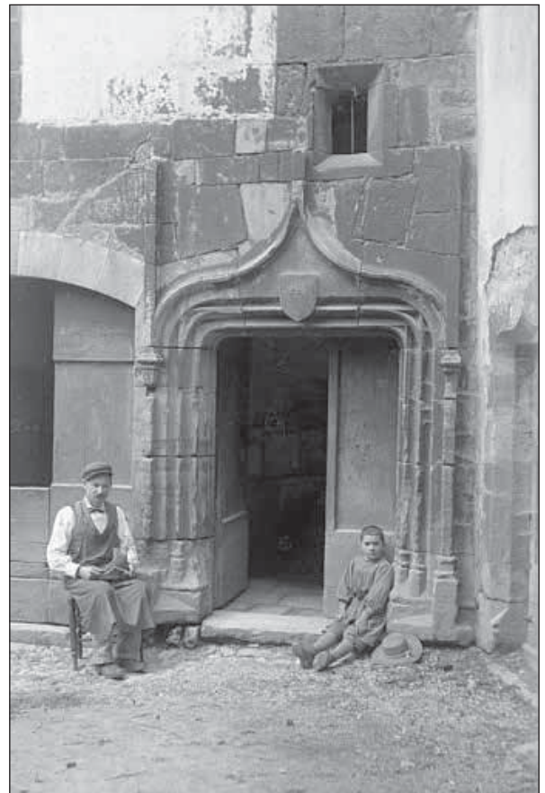
Fig. 9 : porte en accolade du rez-de-chaussée, photographie prise en 1897 par Amélie Galup (MAP, GLP00054).
