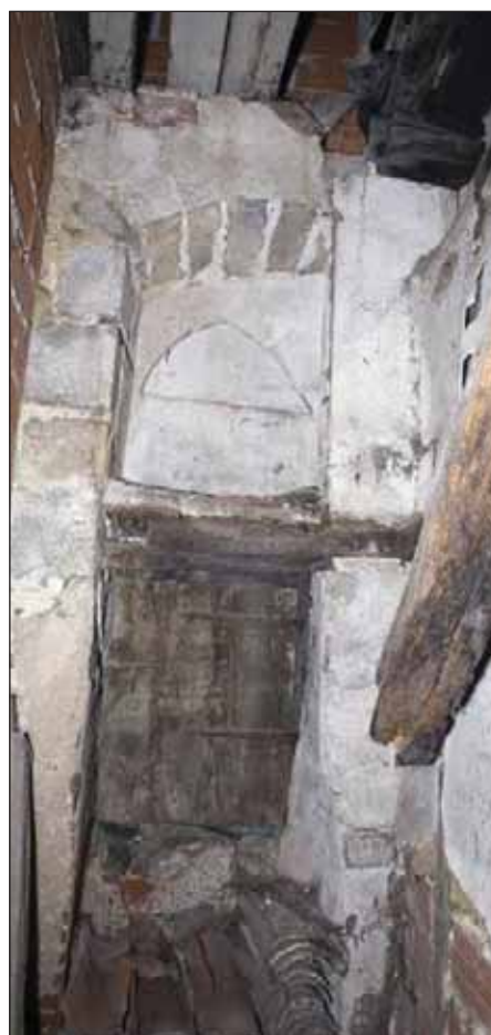
Fig. 11 : fenêtre bouchée à l'angle nord-ouest du deuxième étage, vue de l'intérieur
