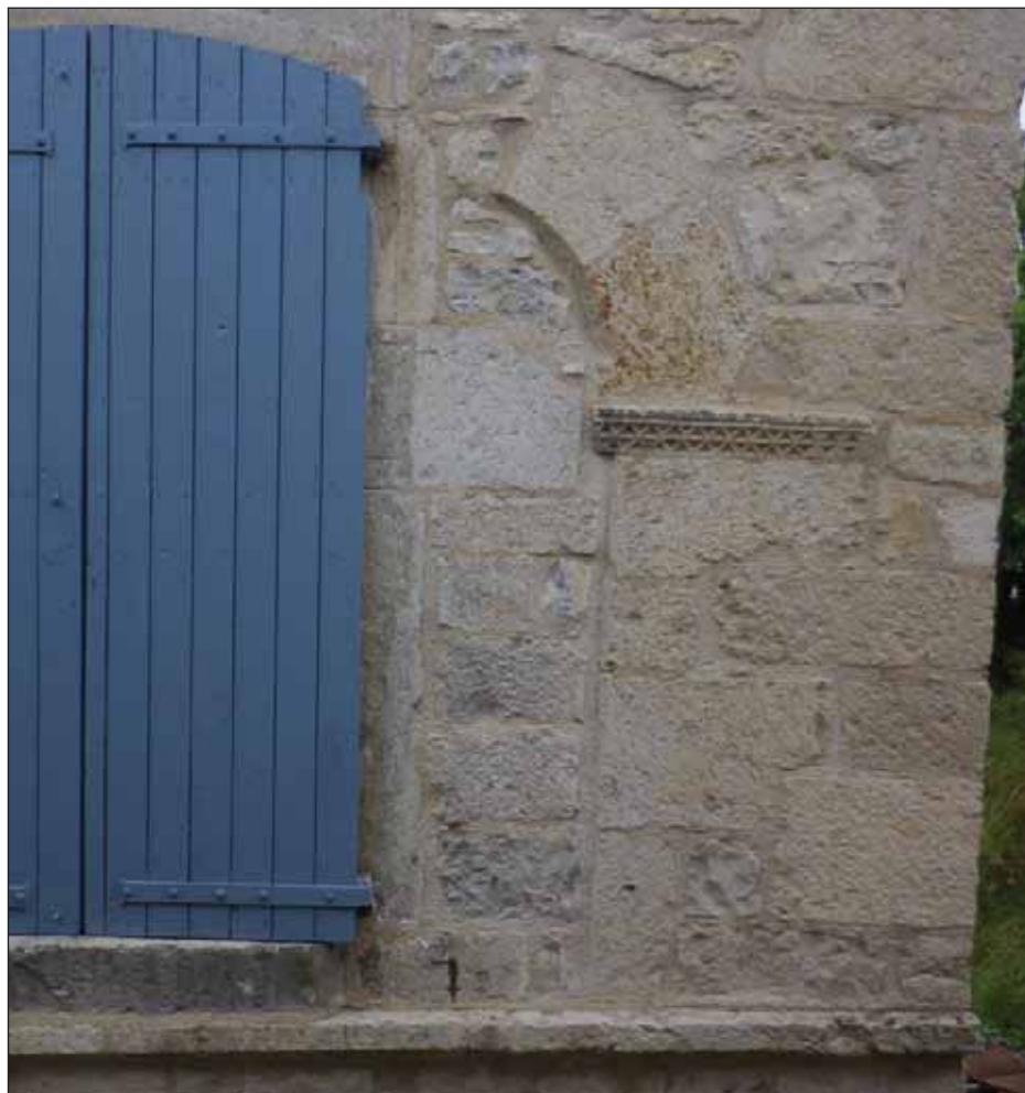
Fig. 2 : piédroit de la baie géminée de droite au premier étage sur la rue Droite
