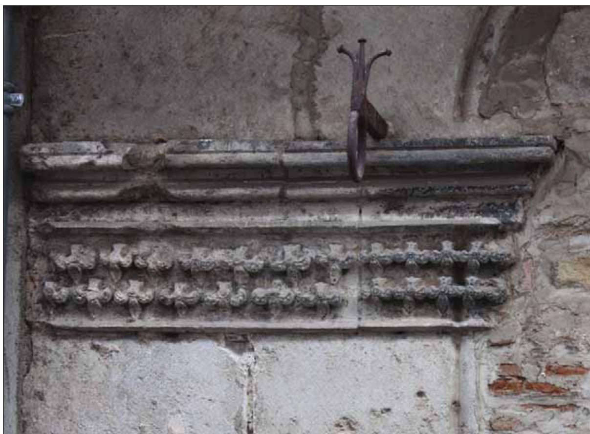
Fig. 13 : cordon d'imposte de la baie géminée de gauche au deuxième étage
