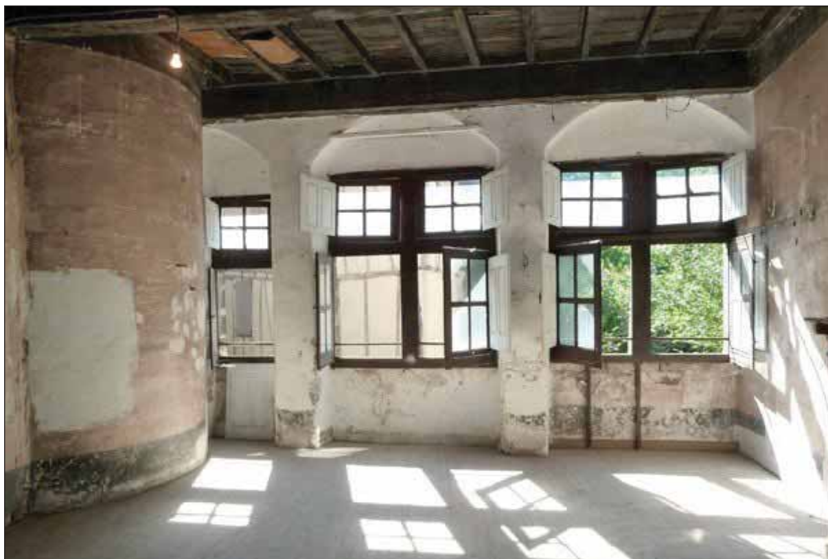
Fig. 12 : embrasures des baies gémignées transformées en croisées dans le mur est du premier étage
