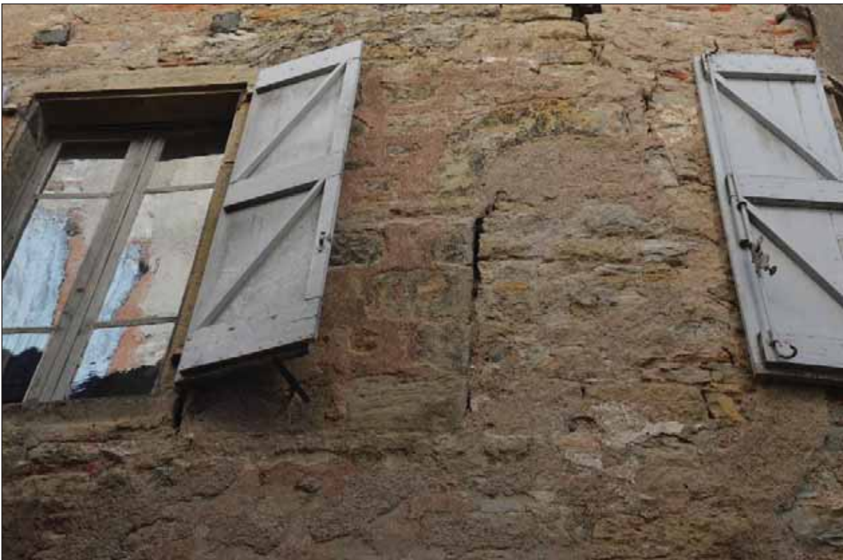
Fig. 3 : vestiges d'une baie couverte d'un arc monolithe au premier étage
