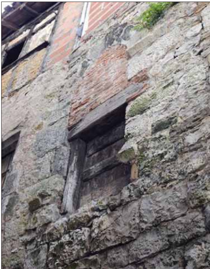
Fig. 10 : fenêtre bouchée à l'angle nord-ouest du deuxième étage de la façade orientale sur la rue Valat
