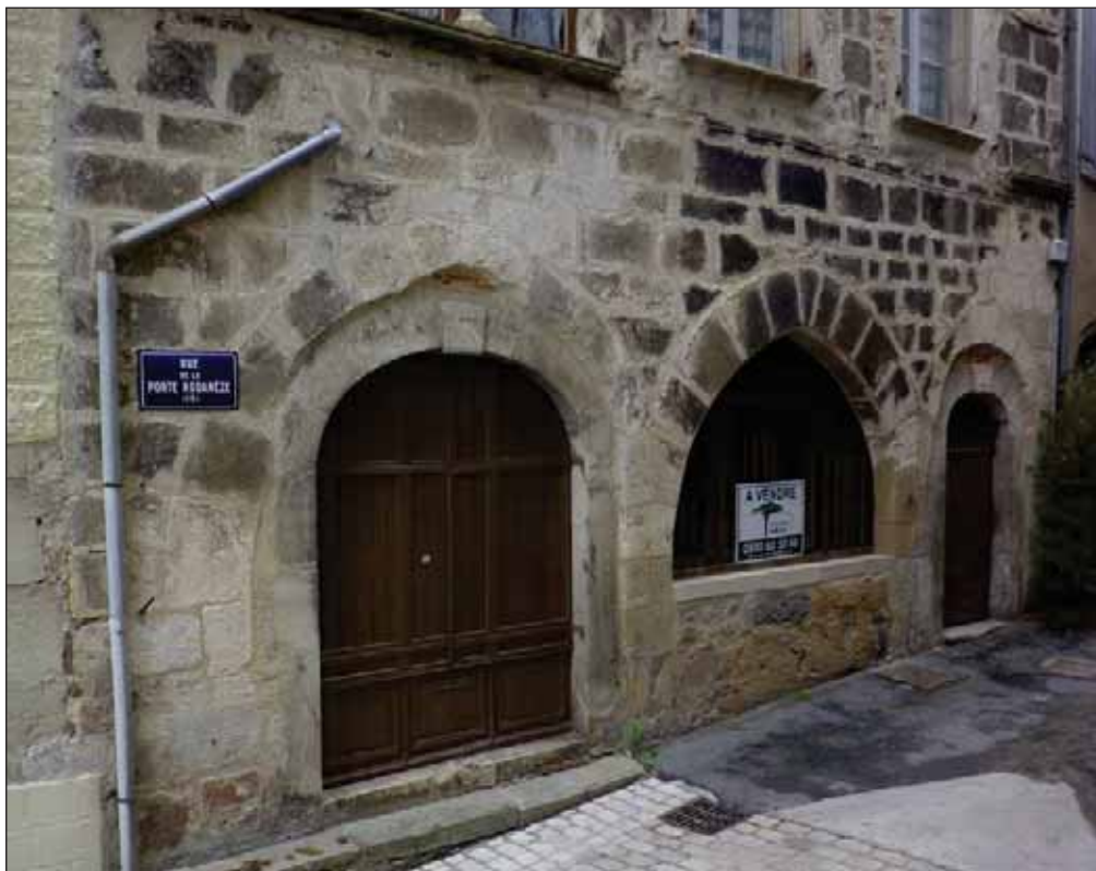
Fig. 4 : ouvertures du rez-de-chaussée sur la rue de la Porte Rodanèse
