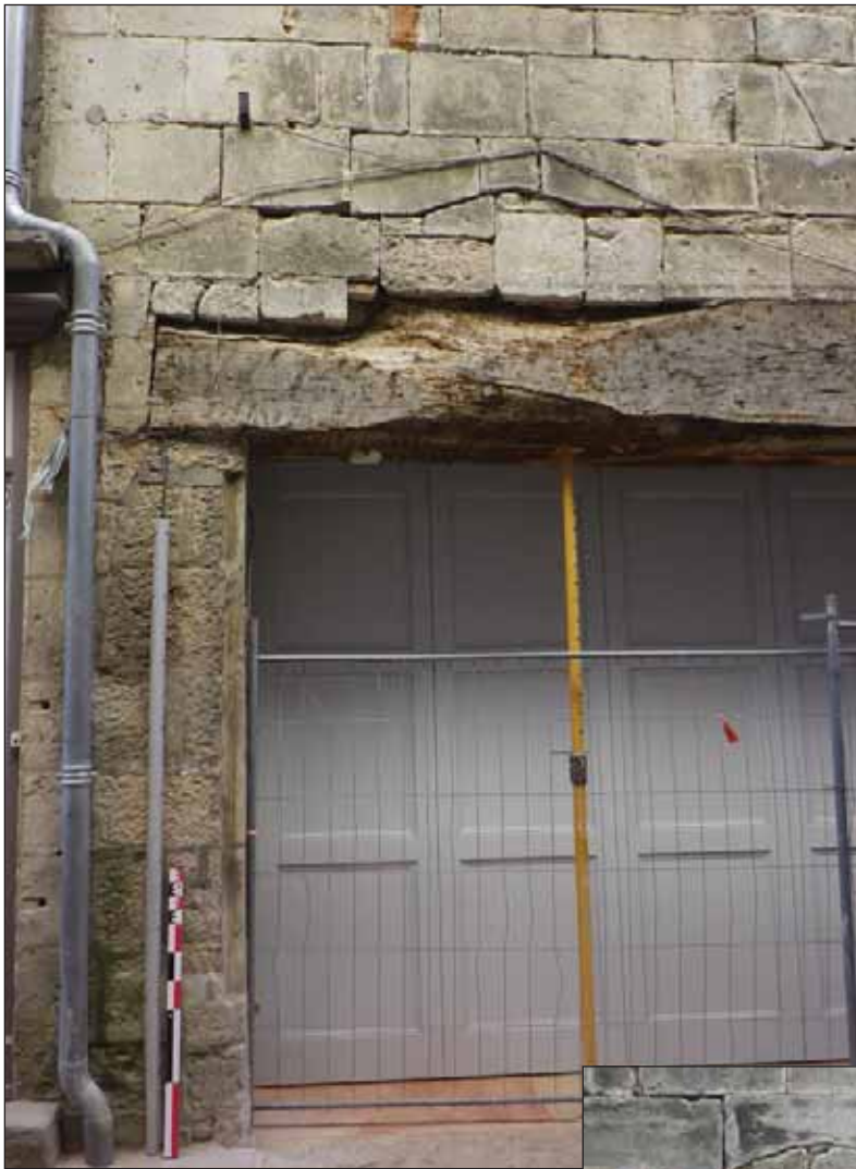
Fig. 2 : piédroit et négatif de la grande arcade de gauche au rez-de-chaussée sur la rue de la Pélisserie
