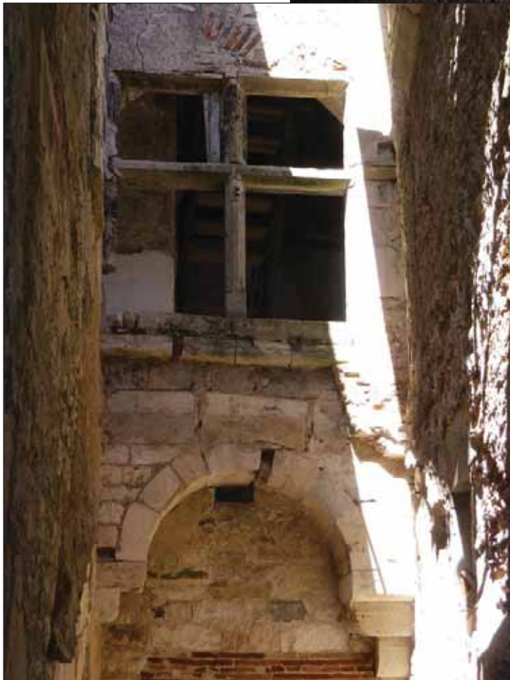
Fig. 31 : baie géminée transformée en croisée sur le mur est du corps de bâtiment B
