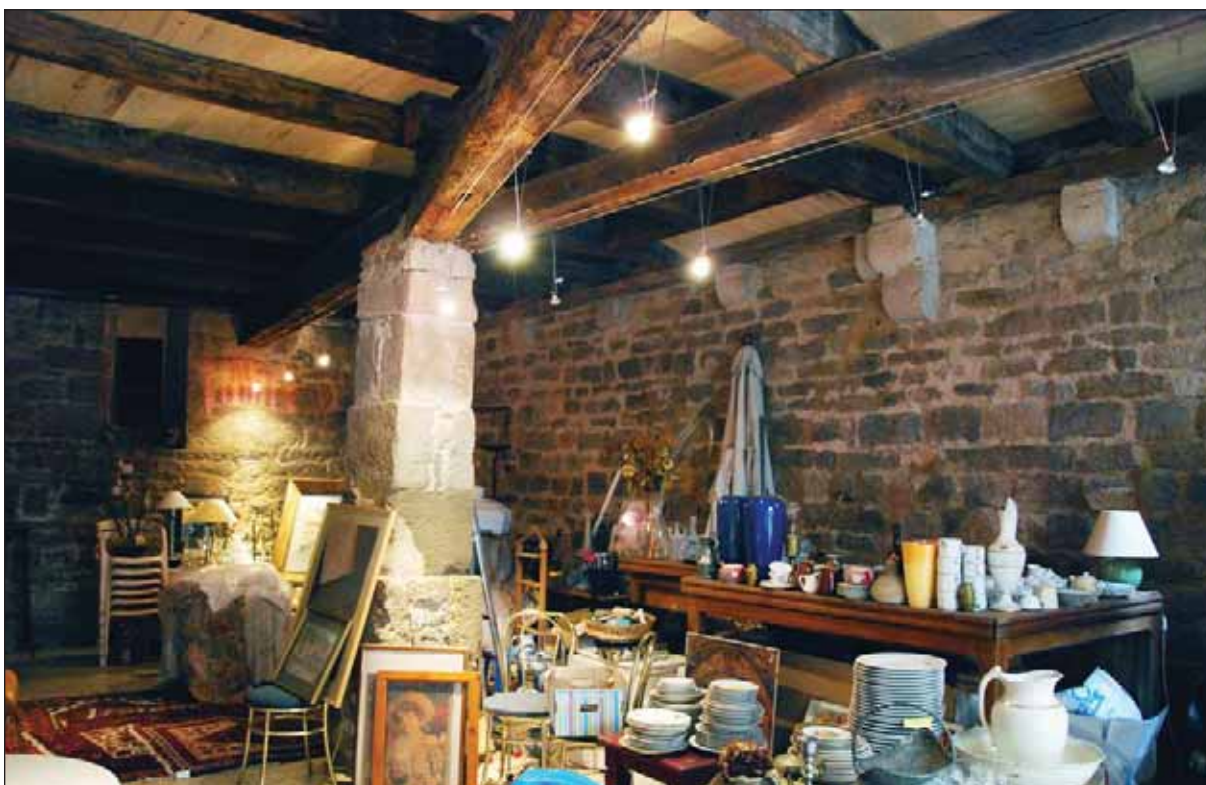
Fig. 11 : pilier du rez-de-chaussée, soutenant le plancher du premier étage
