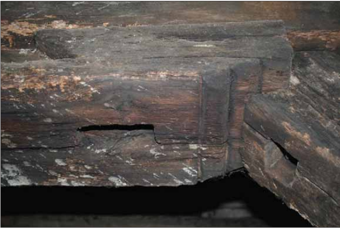
Fig. 12 : pièce de bois en remploi dans la charpente
