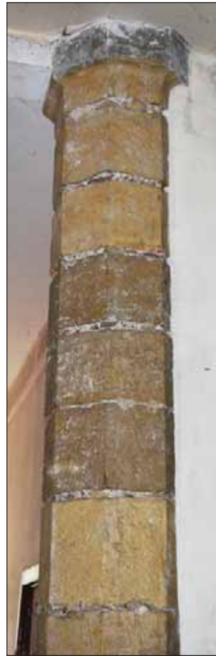
Fig. 31 : pilier soutenant le plancher du deuxième étage
