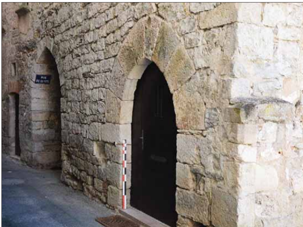
Fig. 2 : porte du rez-de-chaussée et passage de la rue del Cluzel
