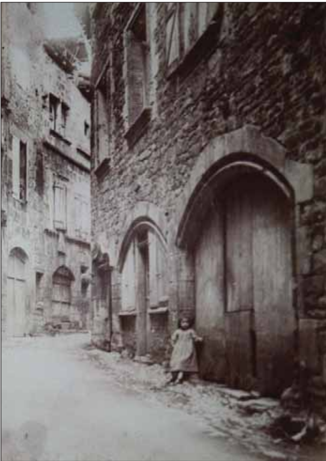
Fig. 4 : carte postale de 1898 représentant la façade sur la rue Droite avant son démontage
