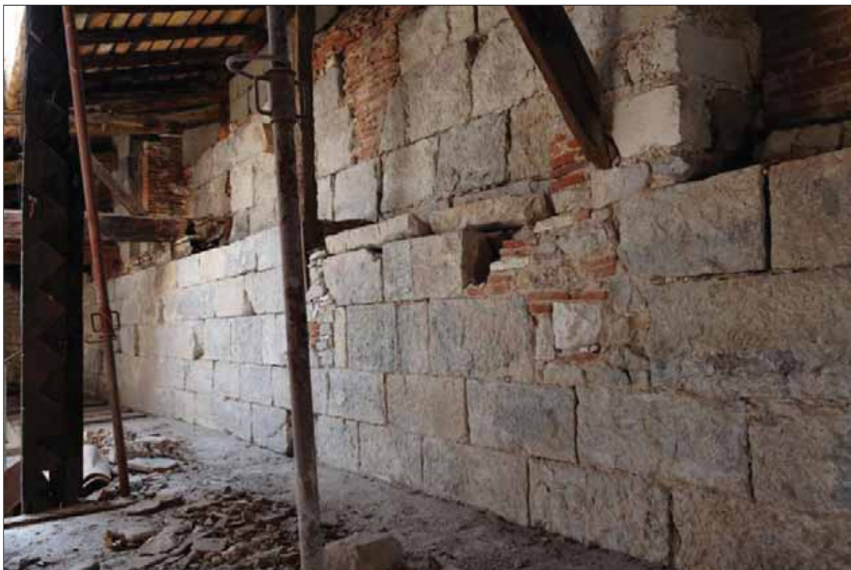
Fig. 33 : élévation en grand appareil du mur sud au deuxième étage
