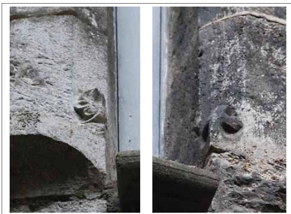
Fig. 13 : congés sculptés de la fenêtre du premier étage de la façade nord
