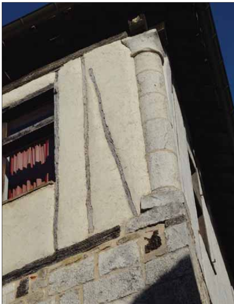
Fig. 12 : colonne d'angle du pan-de-bois du deuxième étage
