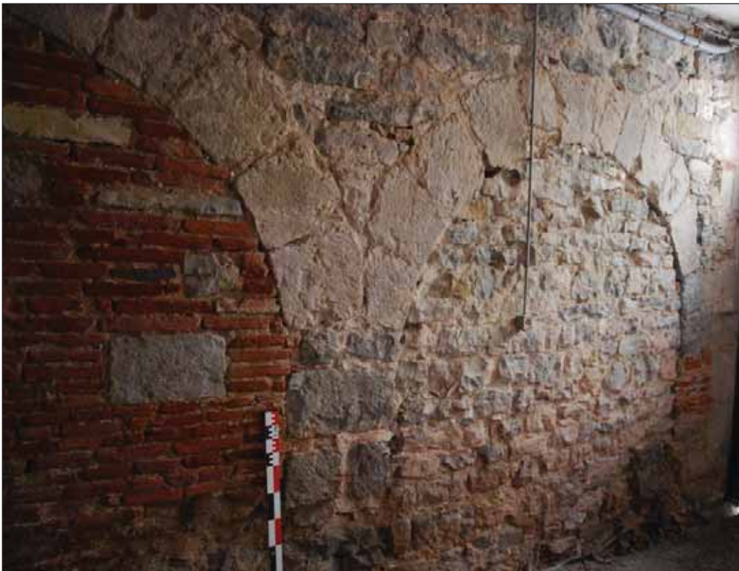
Fig. 20 : grandes arcades en plein cintre dans le mur latéral sud au rez-de-chaussée, à l'ouest
