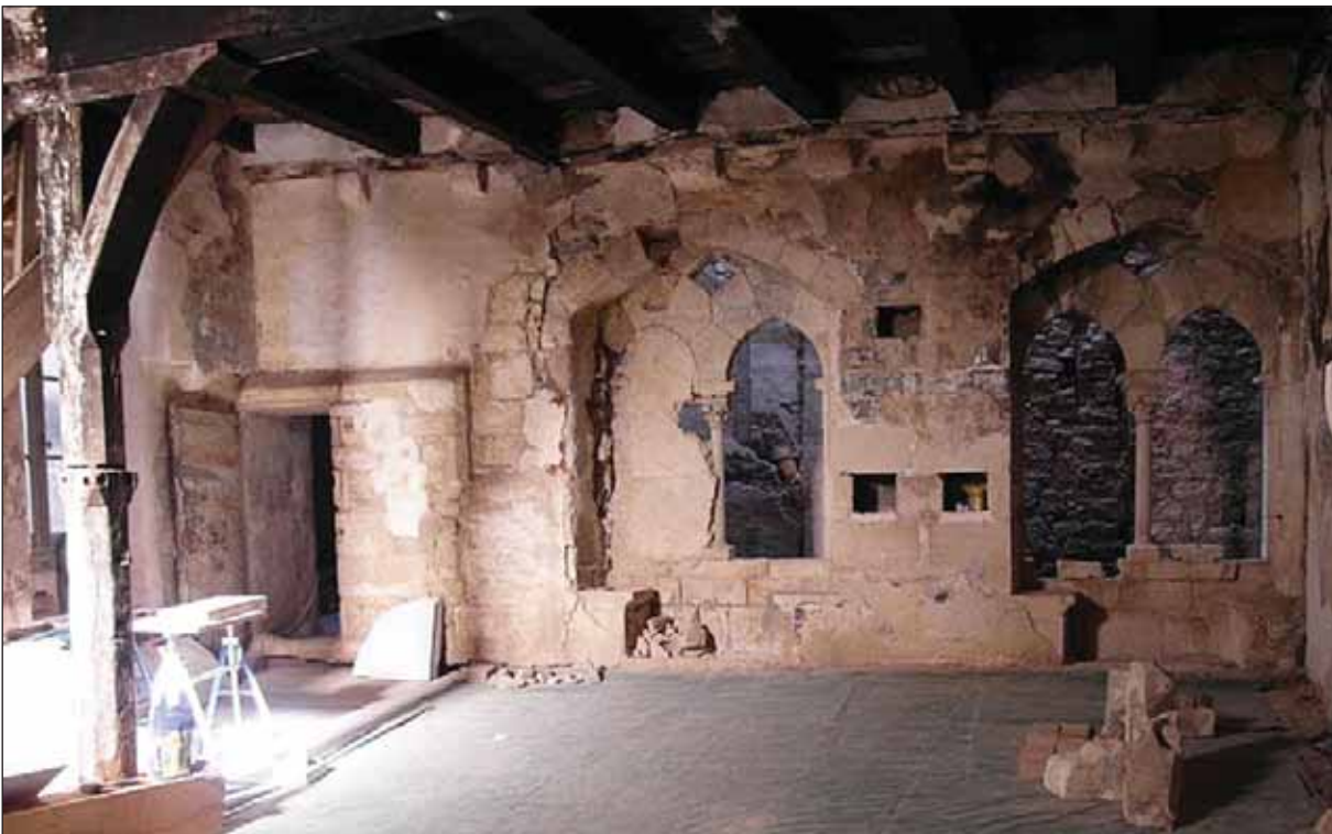
Fig. 19 : mur nord du corps de bâtiment A au premier étage. A gauche, mur épaissit des latrines.
