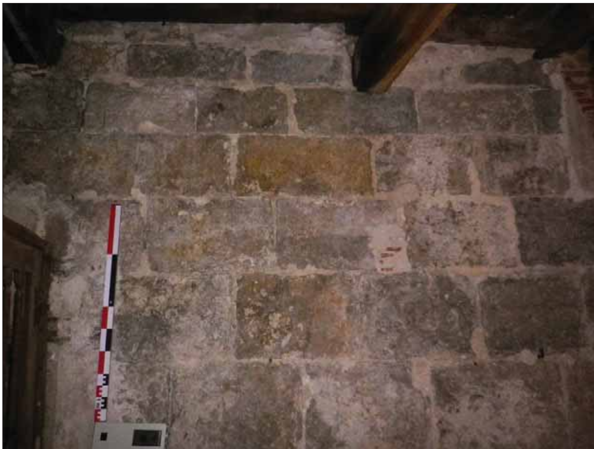
Fig. 19 : grand appareil de pierre de taille du mur ouest au troisième étage
