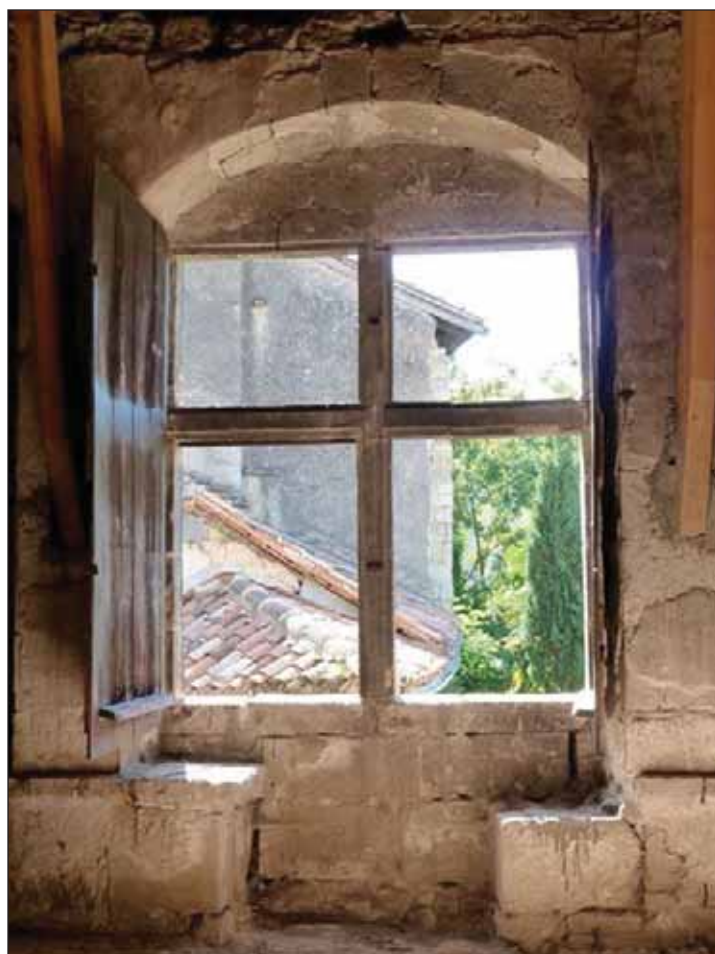
Fig. 13 : embrasure avec coussièges de la baie gémignée centrale transformée en croisée dans le mur est du deuxième étage
