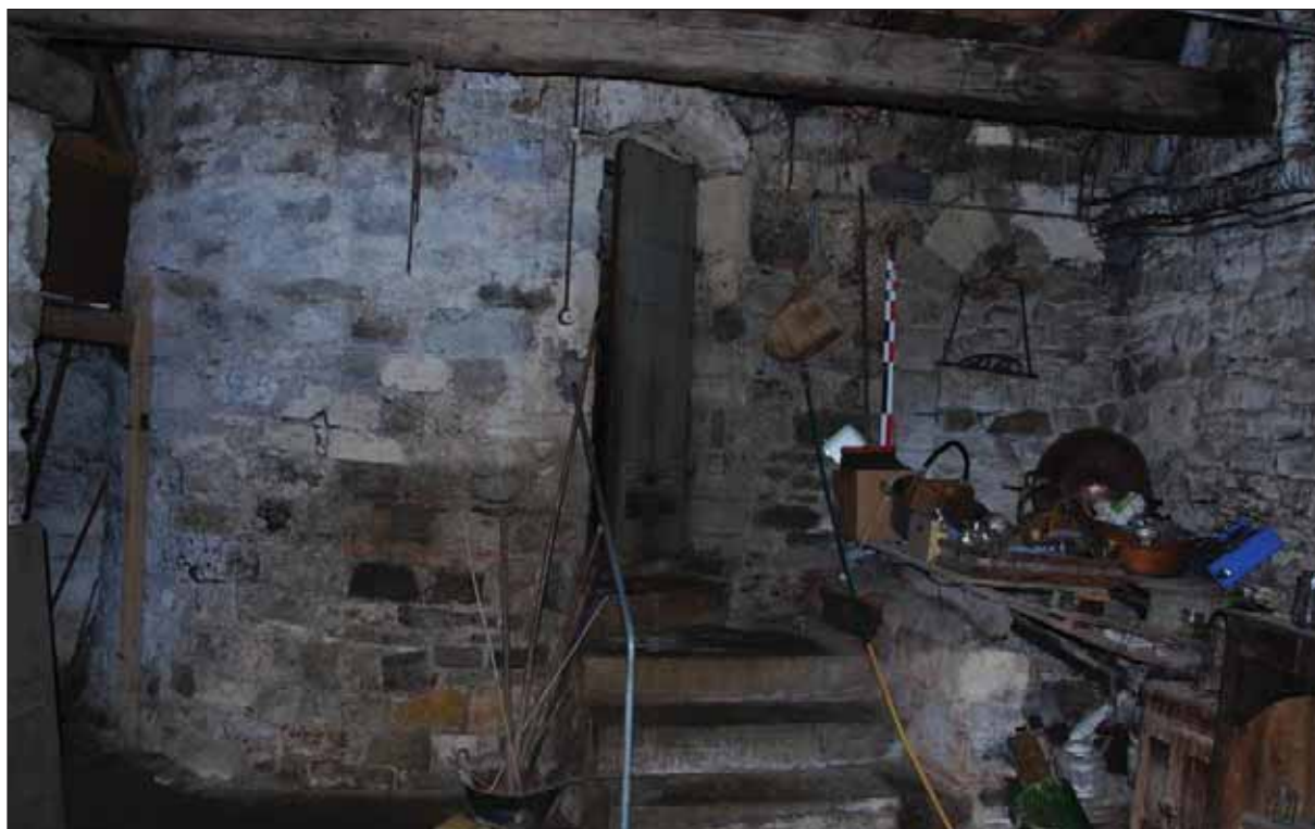
Fig. 16 : mur ouest du rez-de-chaussée du corps de bâtiment A Au centre, tour d'escalier et sa porte de communication. À droite, porte en arc brisé bouchée.
