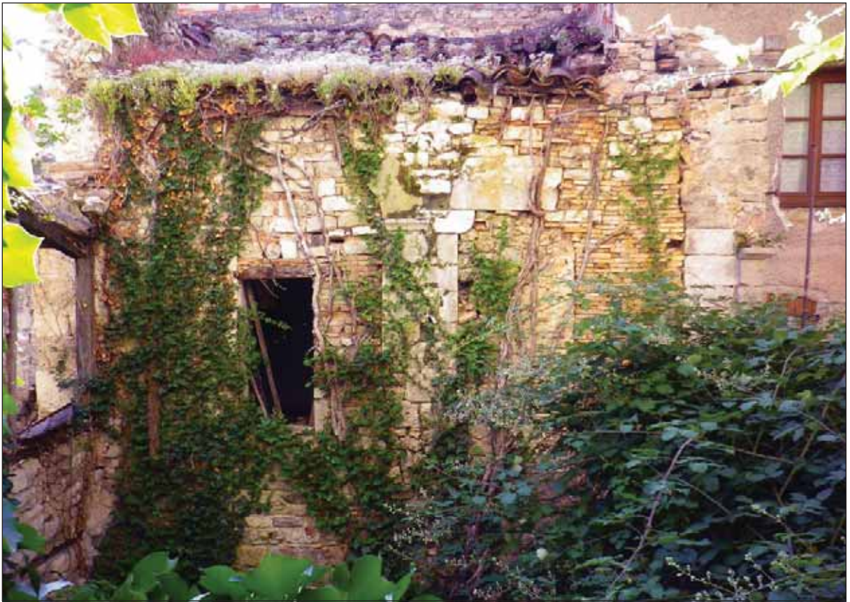
Fig. 36 : vestige de baie géminée sur le mur nord du corps de bâtiment F
