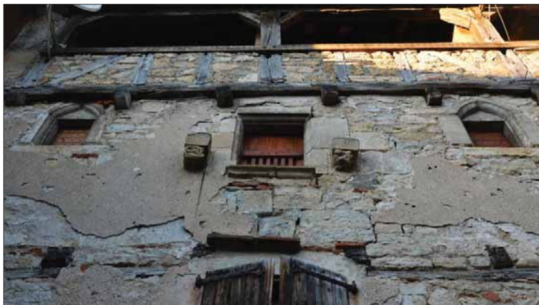
Fig. 7 : remplois dans le mur sud, sur la cour intérieure
