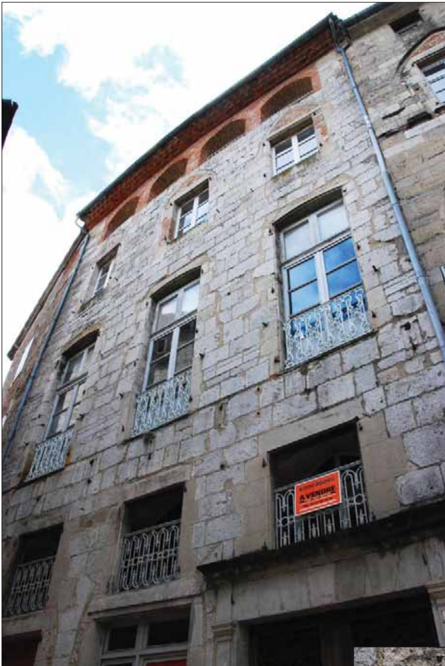
Fig. 1 : élévation sur la place de la Halle
