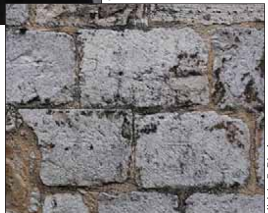
Fig. 2 : exemple de marques de tâcheron sur la façade principale
