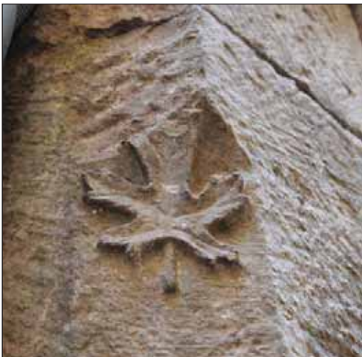
Fig. 3 : détail du congé du chanfrein de l'angle gauche de la façade sur la rue Droite
