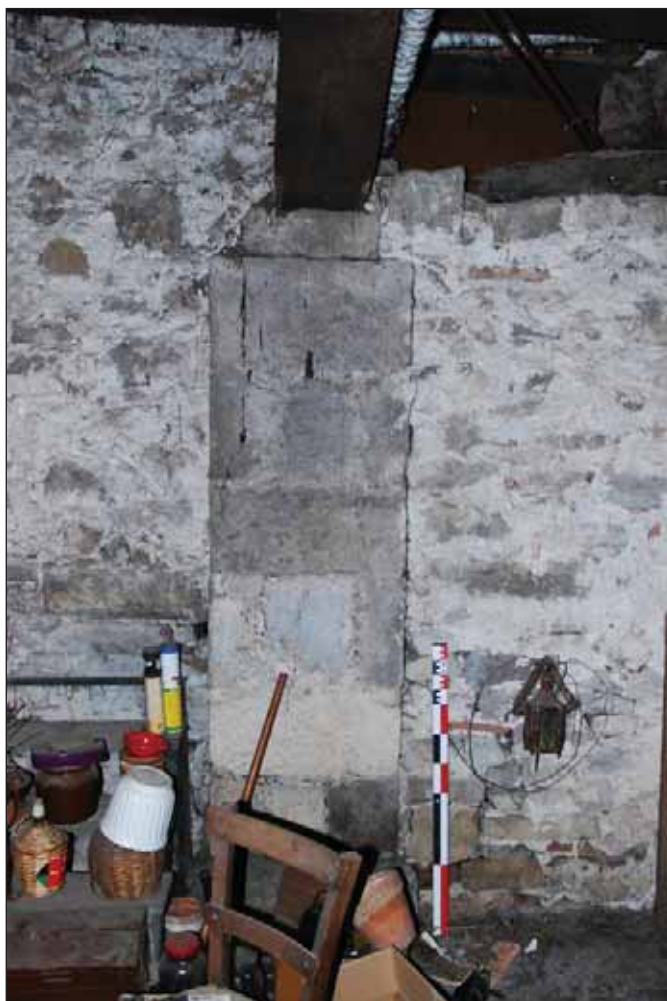
Fig. 17 : pilier soutenant le plancher du premier étage, au rez-de-chaussée du corps de bâtiment A
