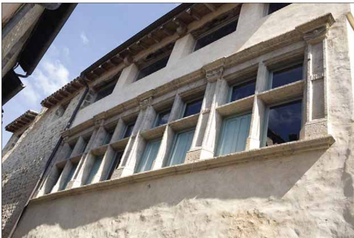
Fig. 6 : claire voie du premier étage
