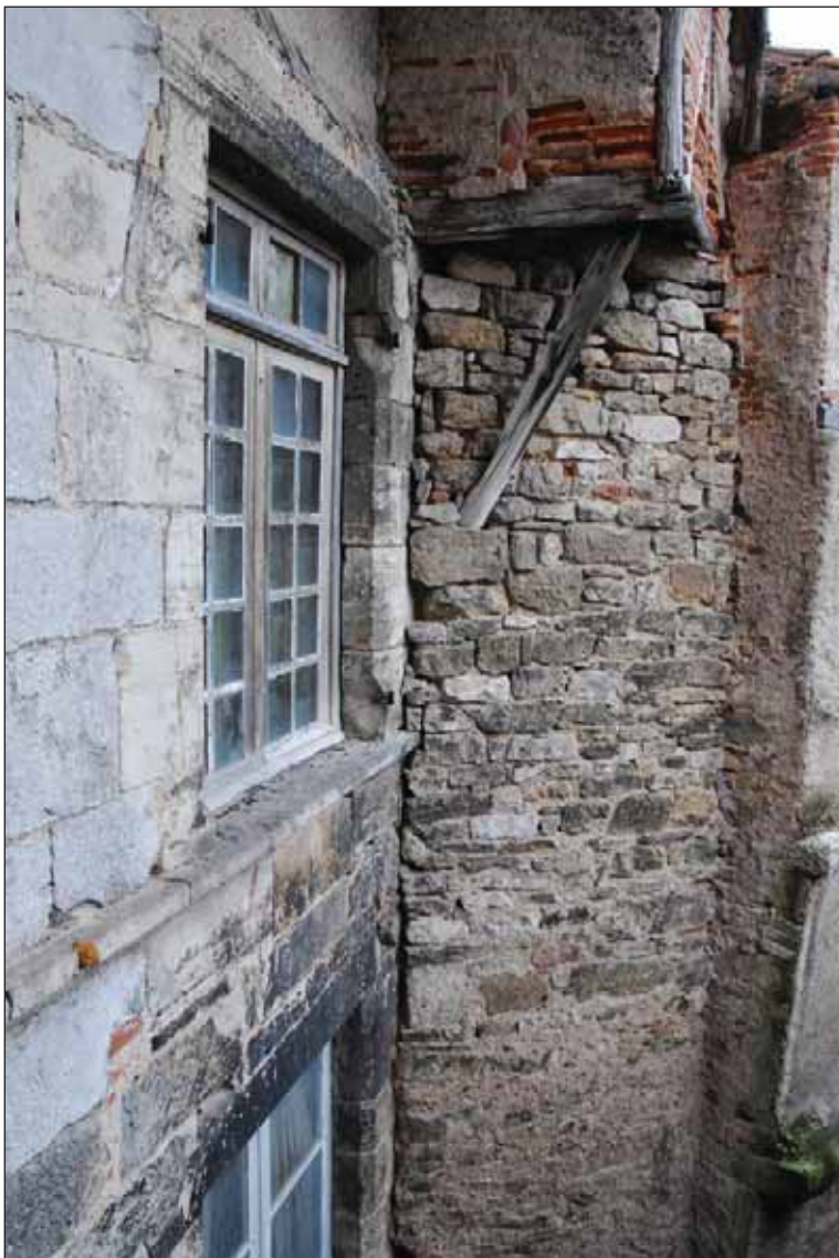
Fig. 14 : fenêtre du deuxième étage de la façade nord sur la ruelle
