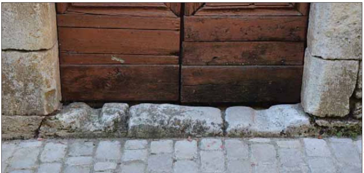
Fig. 4 : rainures sur le seuil de la porte de la façade orientale
