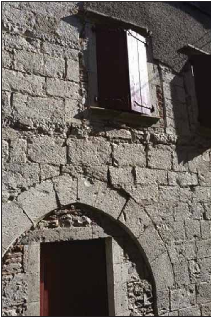
Fig. 5 : piédroits de baies géminées conservés au premier étage de la façade sur la rue Basse du Temple
