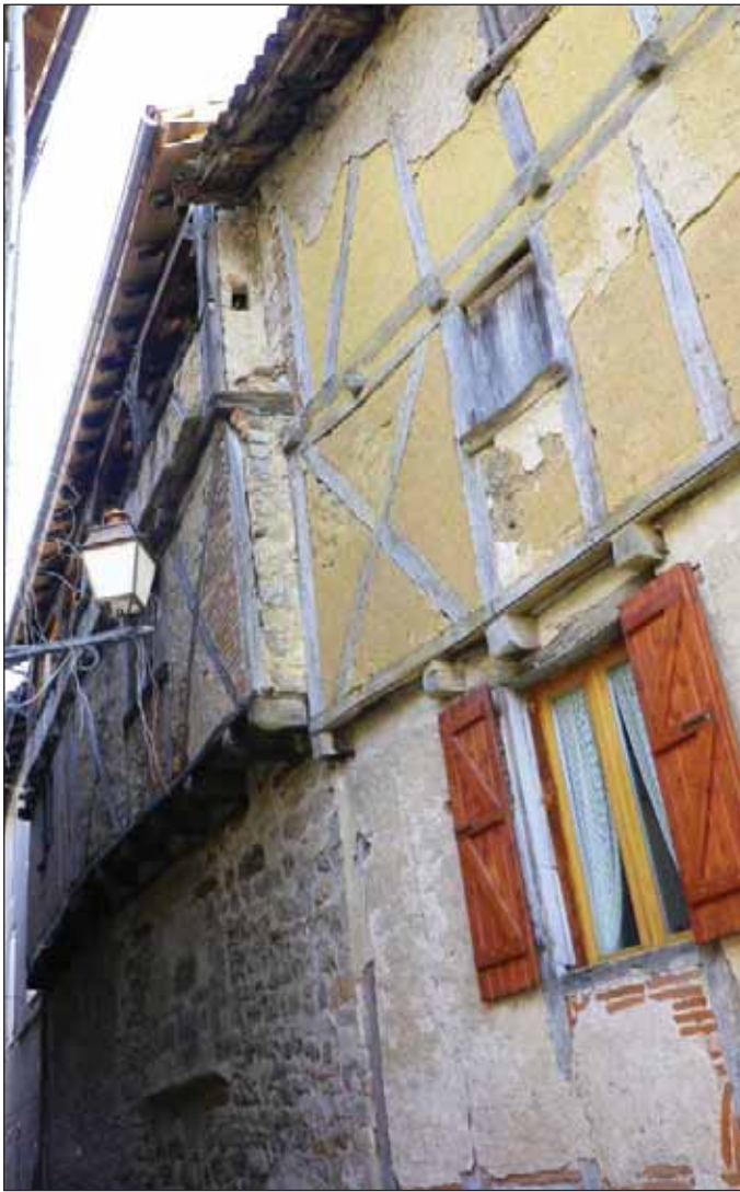
Fig. 1 : partie centrale de la parcelle, façade sur la rue du Bessarel
