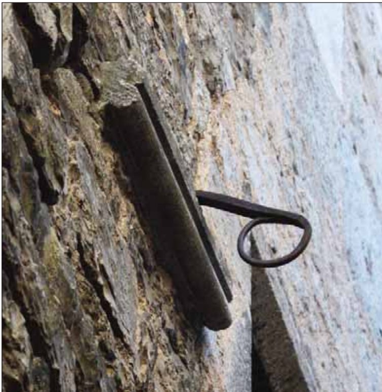
Fig. 5 : porte-bannes et cordon d'imposte de la fenêtre gauche du premier étage
