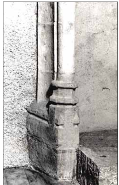
Fig. 10 : haut du piédroit de la cheminée au deuxième étage du corps de bâtiment A
