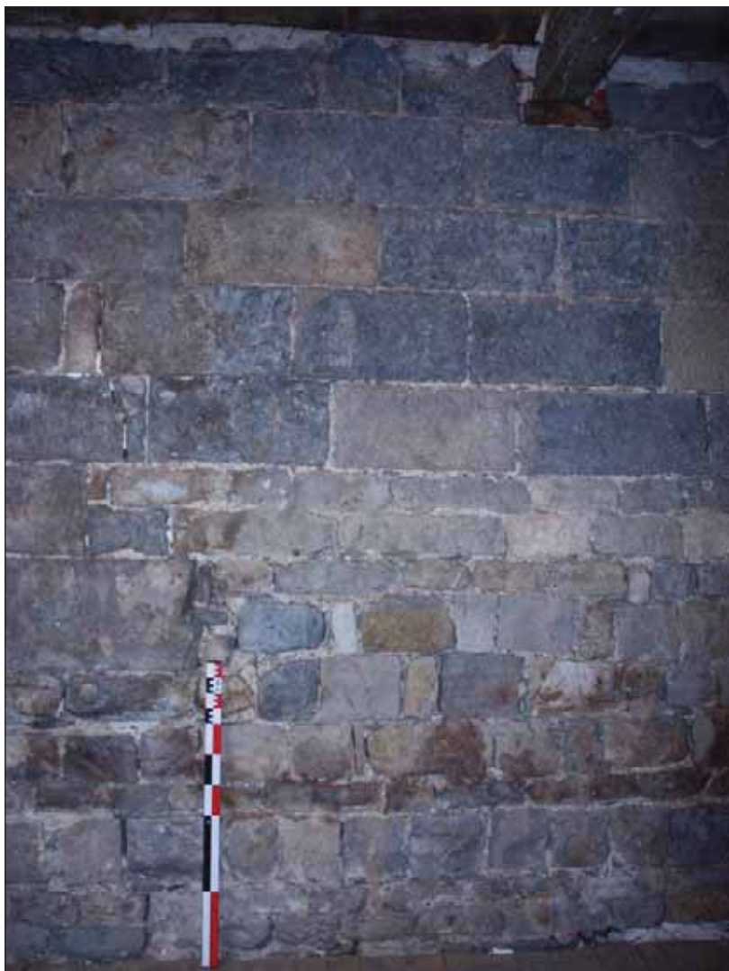
Fig. 32 : mur sud au deuxième étage
