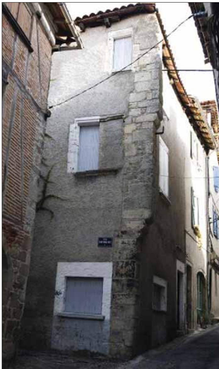
Fig. 1 : élévation sud, sur la rue de Fontanilles
