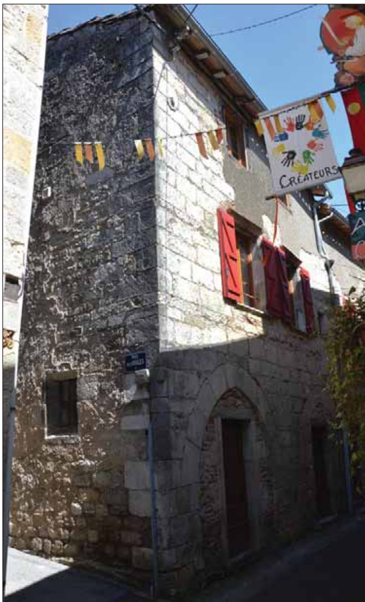
Fig. 1 : élévations sur la rue Basse du Temple et la rue des Oules
