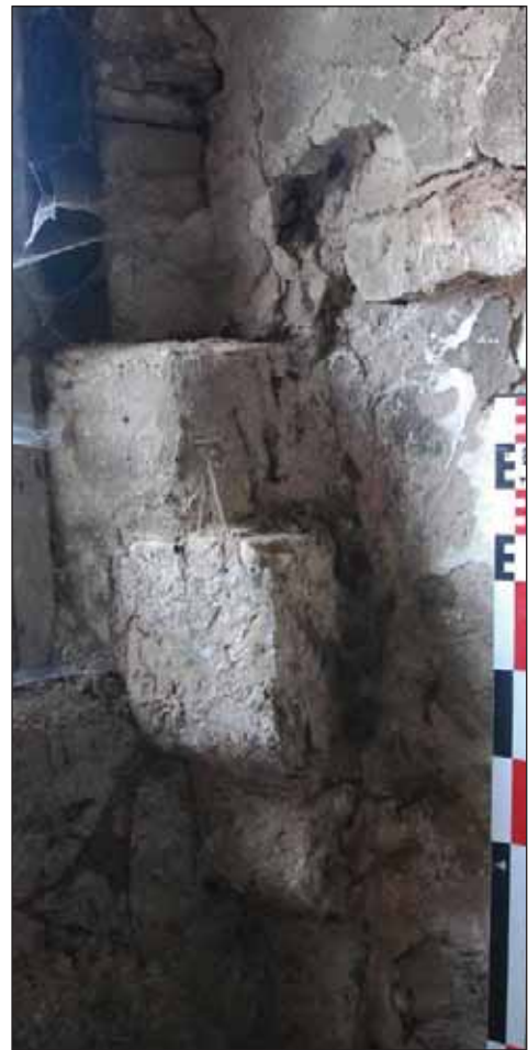
Fig. 24 : console à ressauts du chemin de ronde
