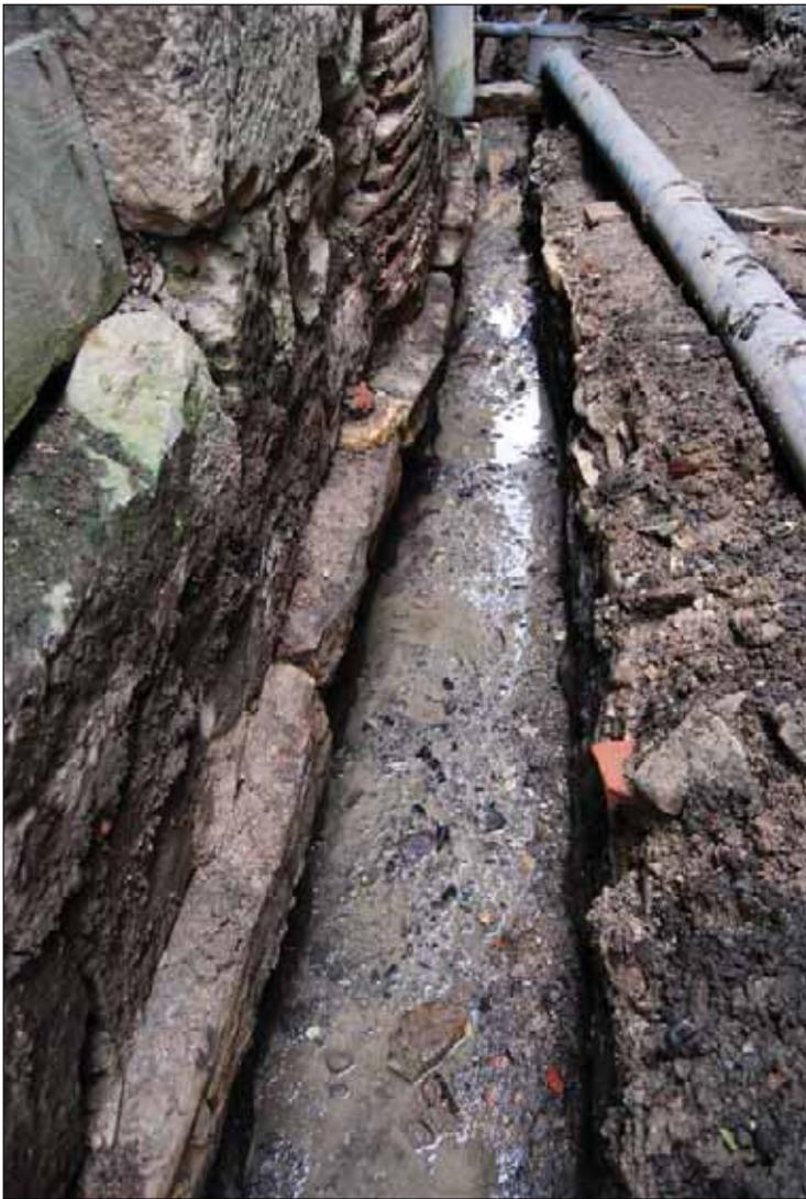
Fig. 6 : canal de la rue du Four Neuf (section nord) sans sa couverture de lauzes
