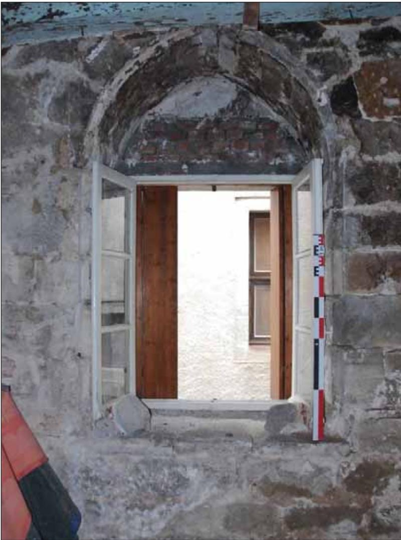
Fig. 10 : ancien placard transformé en fenêtre dans le mur nord
