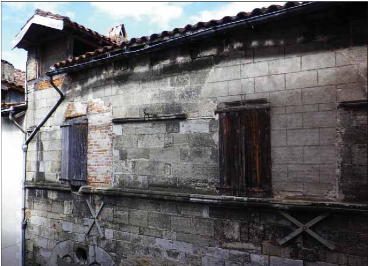
Fig. 9 : cordons d'appui et d'imposte des baies géminées du deuxième étage
