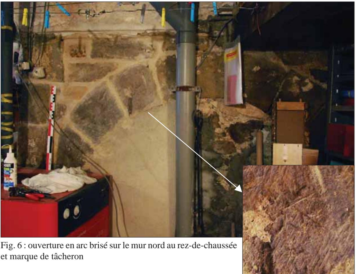
Fig. 6 : ouverture en arc brisé sur le mur nord au rez-de-chaussée et marque de tâcheron
