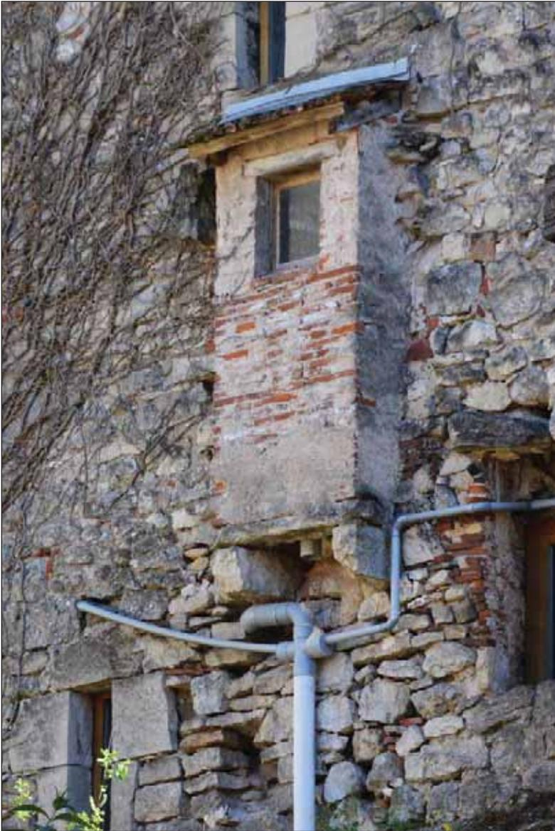
Fig. 22 : latrines en encorbellement sur la façade nord, débouchant sur une venelle
