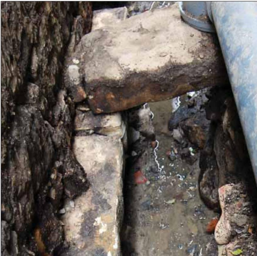
Fig. 7 : ressaut du canal de la rue du Four Neuf (section nord) destiné à recevoir la couverture de lauzes dont une est encore en place
