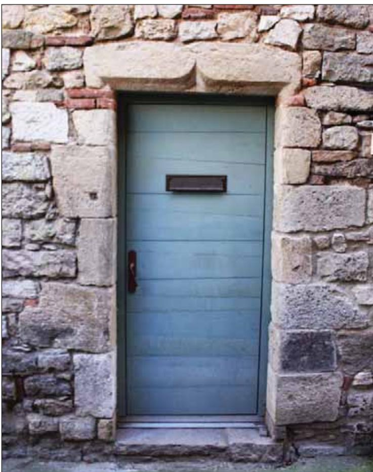
Fig. 2 : porte à linteau droit orné d'une accolade au rez-de-chaussée sur la rue Basse du Temple, partie est
