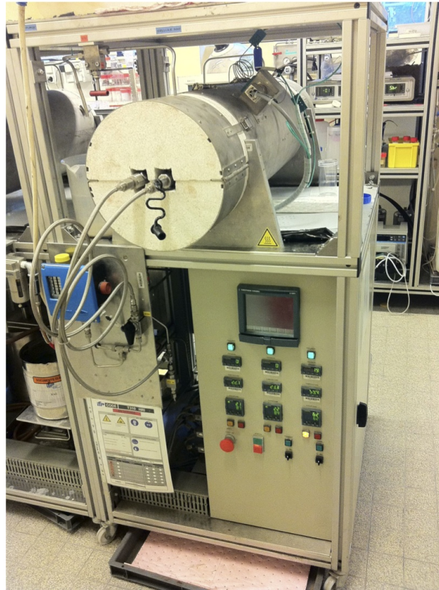
Fig 1.8. Détails du dispositif expérimental de la cellule chauffante pressurisée pour la préparation des plots de ciment.
