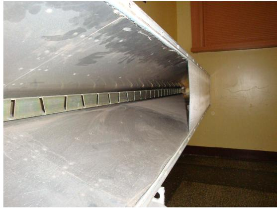
FIGURE 2.1: Coupe d'une antenne RADAR utilisée dans la marine, constituée d'un guide d'onde troué.
